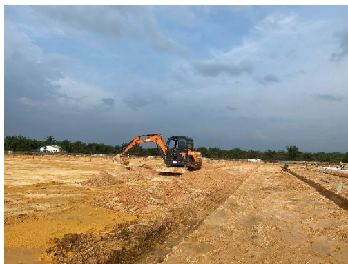
Gambar 3. 9. Pengalihan pipa HDPE
