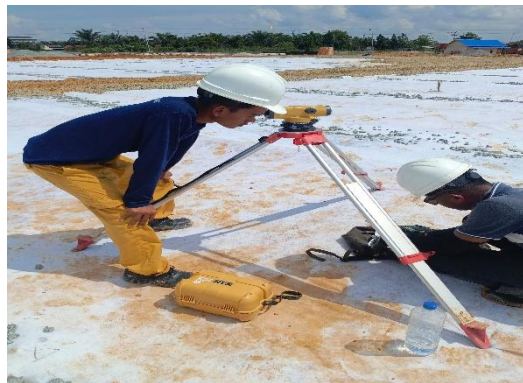
Gambar 3.2 Pengukuran Elevasi Timbunan Batu Split (Sumber : Dokumentasi Proyek, 2024)
