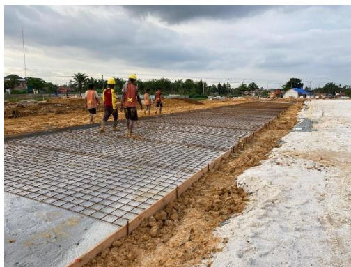
Gambar 3. 28. Pemasangan besi wiremesh m8
