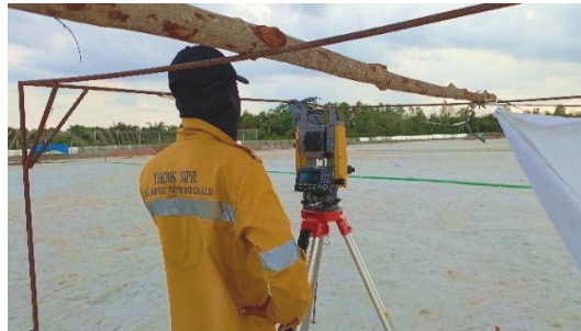
Gambar 3. 64. Pengukuran Pondasi Pagar BRC
