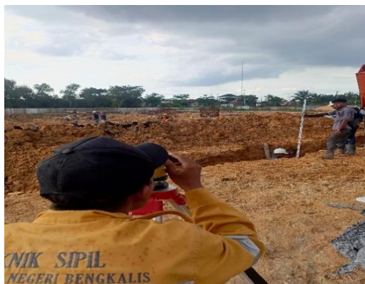
Gambar 3. 77. Pengukuran elevasi U-ditch
