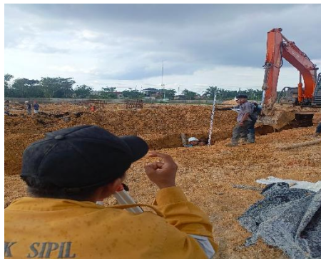
Gambar 3. 7. Pengukuran U-ditch
