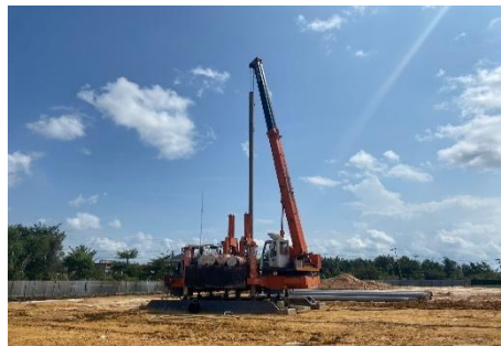
Gambar 3. 41. Pemancangan tiang pancang
