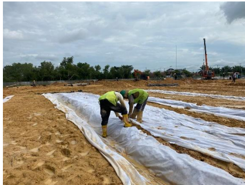
Gambar 3. 10. Pekerjaan lapisan geotextile non woven 150gr/m 2
