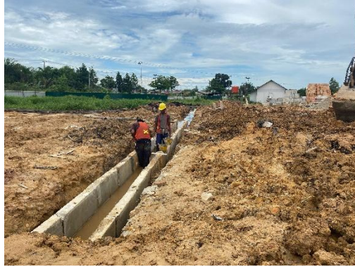
Gambar 3. 8. Pemasangan U-ditch
