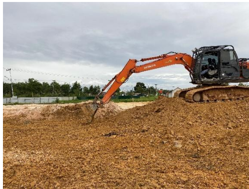
Gambar 3. 2. Pengurugan tanah timbun (Sumber : Dokumentasi Pribadi, 2024)
