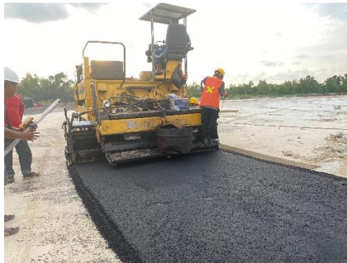
Gambar 3. 33. Pengelaran aspal AC-WC
