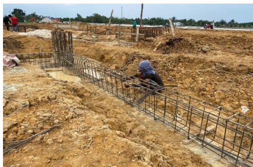
Gambar 3. 50. Pengecoran pondasi setempat (Sumber : Dokumentasi Pribadi, 2024)
