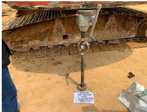
.Gambar 3. 5. Pengujian CBR timbunan tanah
