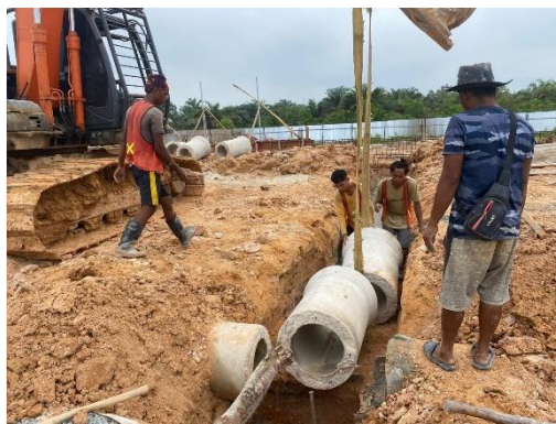
Gambar 3. 17. Pekerjaan pemasangan buis beton RCP 40 cm
