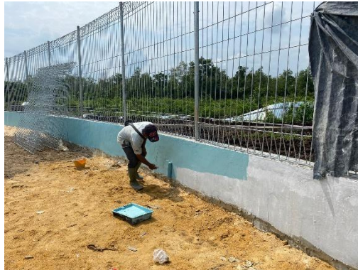
Gambar 3. 60. Pengecatan dinding beton (Sumber : Dokumentasi Pribadi, 2024)
