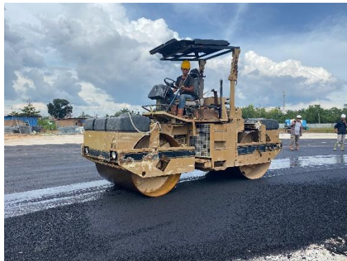
Gambar 3. 35. Pemadatan aspal AC-WC
