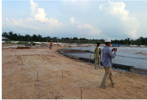
Gambar 3. 83. Patok-patok hasil pengukuran (Sumber : Dokumentasi Pribadi, 2024)
