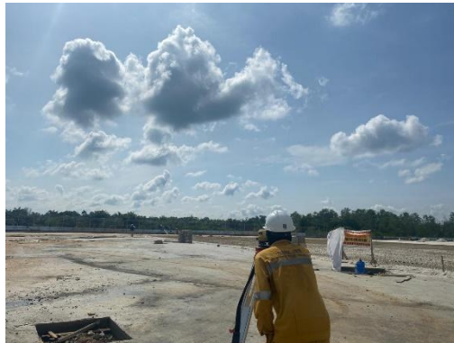
Gambar 3. 31. Pengukuran elevasi ketebalan aspal
