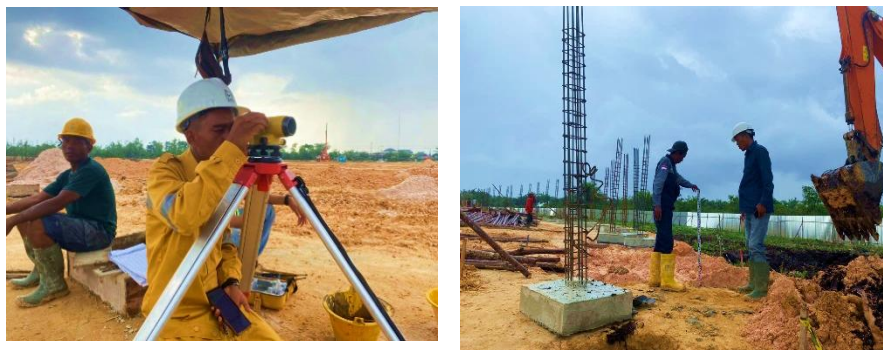
Gambar 3. 66. Pengukuran Elevasi Lantai Kerja Pagar BRC
