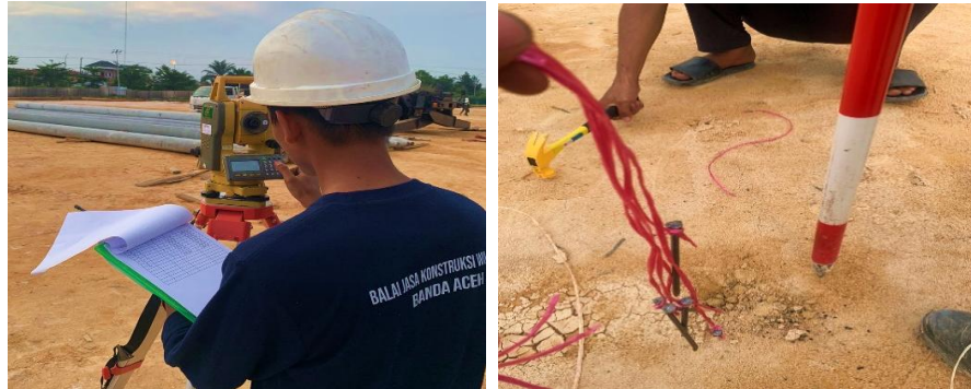
Gambar 3. 70. Pengukuran titik Koordinat Tiang Pancang
