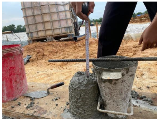
Gambar 3. 29. Uji slump beton ready mix K-225
