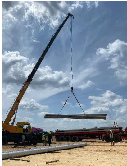
Gambar 3. 38. Pengadaan tiang pancang Spun pile
