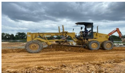
Gambar 3. 3. Perataan tanah (Sumber : Dokumentasi Pribadi, 2024)
