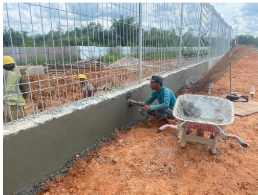
Gambar 3. 59. Afwerking beton
