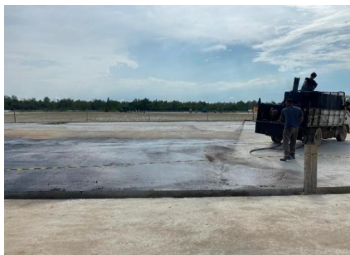
Gambar 3. 32. Pengawasan pekerjaan prime coat
