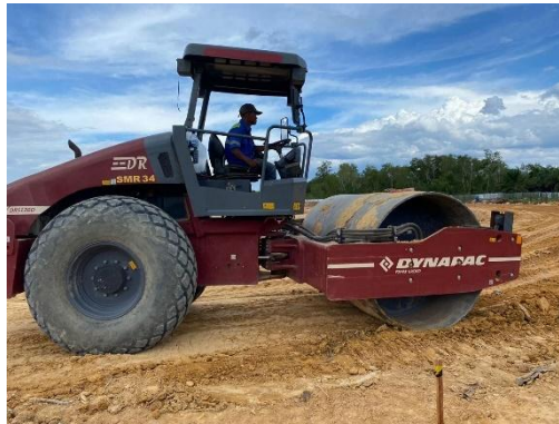
.Gambar 3. 4. Pemadatan tanah timbun
