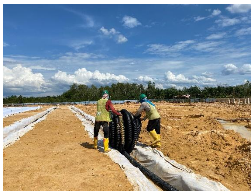
Gambar 3. 11. Pekerjaan instalasi pipa HDPE Dia. 4 cm
