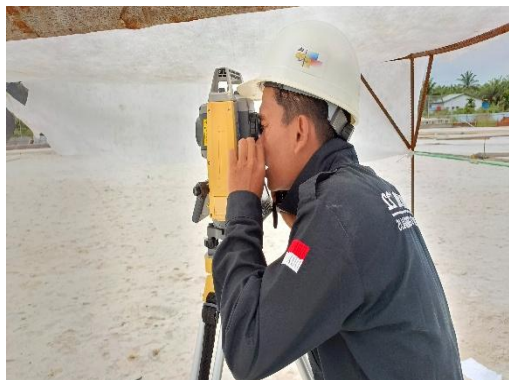
Gambar 3. 82. Pengukuran lintasan Atletik
