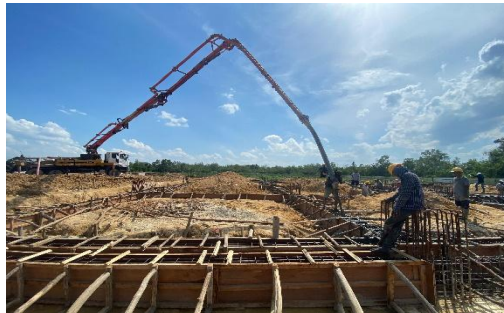
Gambar 3. 53. Pengecoran slump sloof (Sumber : Dokumentasi Pribadi, 2024)
