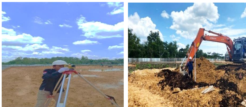
Gambar 3. 73. Pengukuran ke Dalam Elevasi Top lantai kerja (Sumber : Dokumentasi Proyek, 2024)
