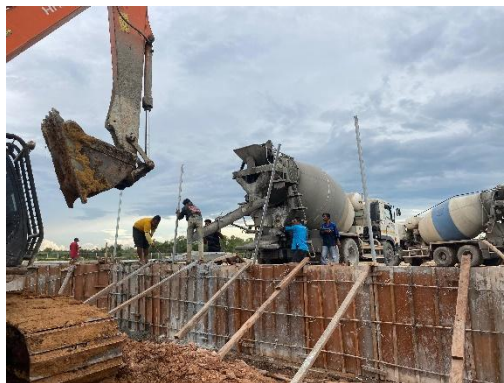
Gambar 3. 57. Pengecoran dinding (Sumber : Dokumen Pribadi, 2024)
