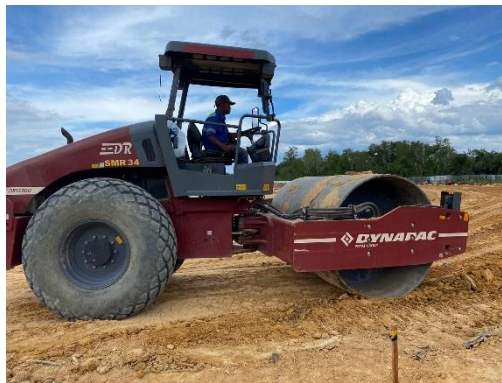
Gambar 3. 26. Pemadatan tanah
