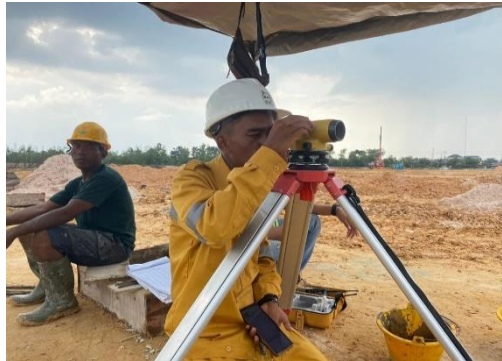
Gambar 3. 51. Pengukuran elevasi top cor beton sloof
