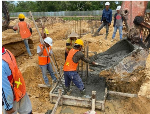
Gambar 3. 49. Pengecoran pondasi setempat (Sumber : Dokumentasi Pribadi, 2024)
