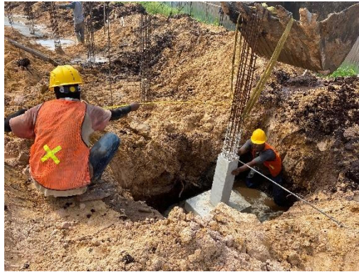
Gambar 3. 55. Pemasangan pondasi setempat dan kolom pedestal
