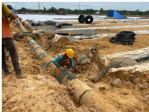
Gambar 3. 16Pemasangan buis beton diameter 30 cm (Sumber : Dokumentasi Pribadi, 2024)
