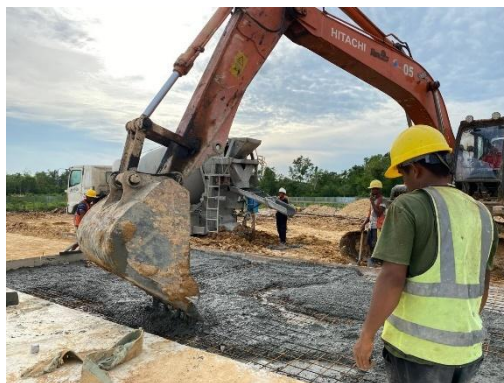
Gambar 3. 30. Pengecoran landasan lintasan atletik K-225
