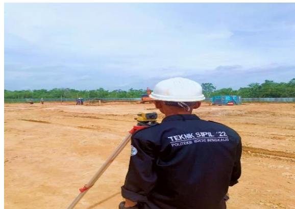
Gambar 3. 72. Pengukuran elevasi kedalaman Top pilecep (Sumber : Dokumentasi Pribadi, 2024)
