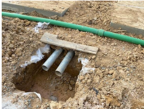
Gambar 3. 21. Pekerjaan cable trench
