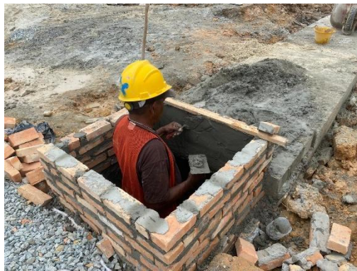
Gambar 3. 20. Pekerjaan bak kontrol
