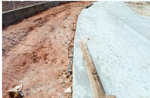
Gambar 3. 86. Patok-patok hasil pengukuran (Sumber : Dokumentasi Pribadi, 2024)
