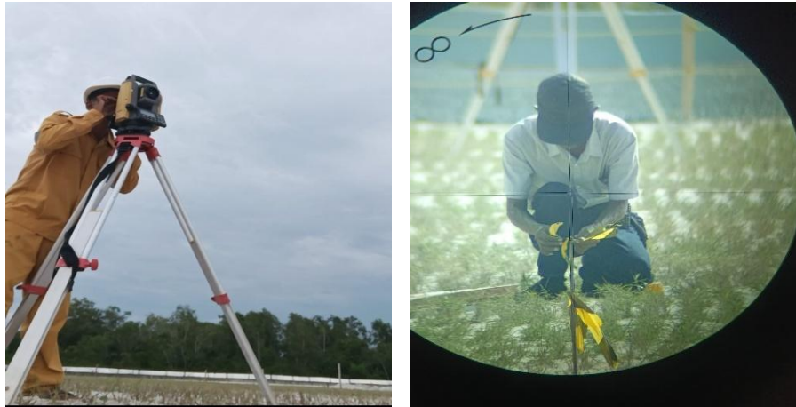
Gambar 3. 88. Pengukuran garis AS lapangan (Sumber : Dokumentasi Pribadi, 2024)
