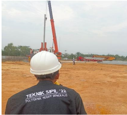
Gambar 3. 40. Pengukuran elevasi top pancang spun pile
