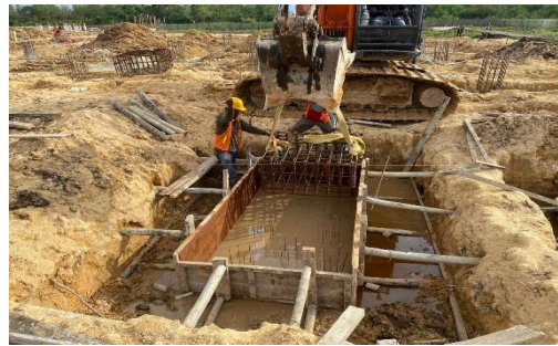
Gambar 3. 46. Pekerjaan pondasi tapak pile cap (Sumber : Dokumentasi Pribadi, 2024)
