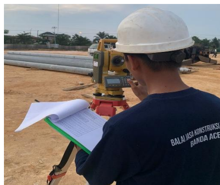
Gambar 3. 39. Pengukuran titik koordinat tiang pancang
