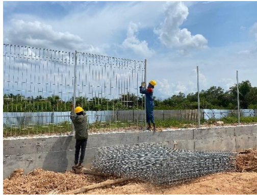
Gambar 3. 58. Pemasangan pagar type-b BRC (Sumber : Dokumentasi Pribadi, 2024)
