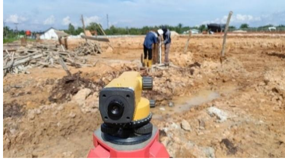
Gambar 3. 74. Pekerjaan pengukuran elevasi top cor Sloof (Sumber : Dokumentasi Proyek, 2024)
