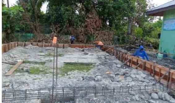
Gambar 3. 9 Pemasangan Bekisting Sloof
