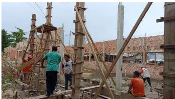
Gambar 3. 16 Pemasangan Bekisting Kolom Praktis
