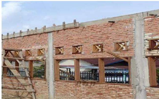
Gambar 3. 18 Pemasangan Bekisting Balok
