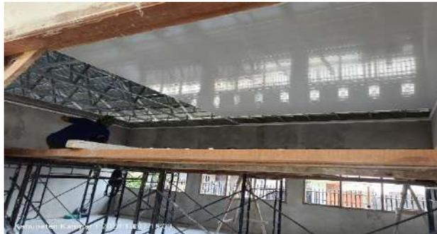
Gambar 3. 49 Pemasangan Plafon PVC
