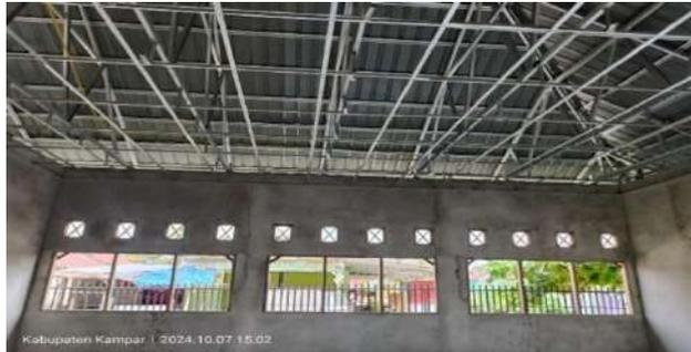
Gambar 3. 48 Pemasangan Rangka Hollow
