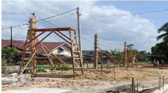
Gambar 3. 14 Pengecoran Kolom
