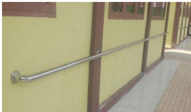
Gambar 3. 27 Pemasangan Handrail
