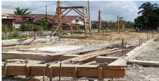
Gambar 3. 12 Pemasangan Bekisting Kolom
