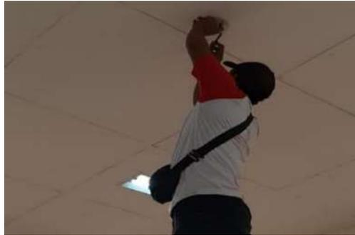
Gambar 3. 56 Pemasangan Lampu Down Light
