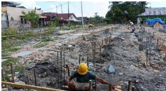
Gambar 3. 5 Pemasangan Pondasi Rollag
