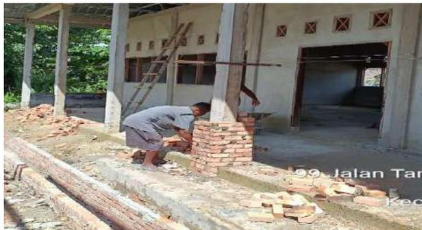
Gambar 3. 23 Pemasangan Bata Kolom
