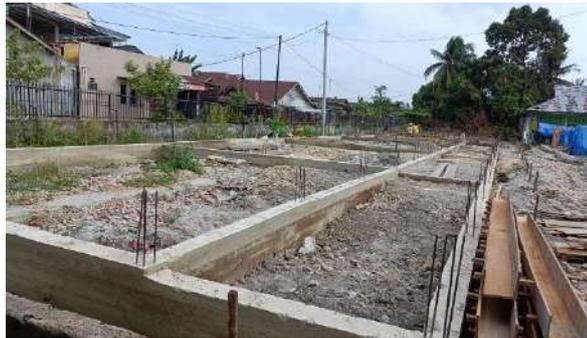
Gambar 3. 11 Pembongkaran Bekisting
