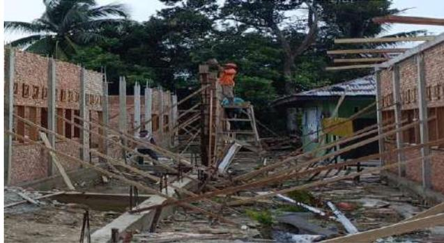
Gambar 3. 17 Pengecoran Kolom Praktis
