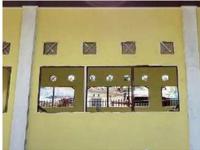
Gambar 3. 33 Pemasangan Ventilasi Jendela
