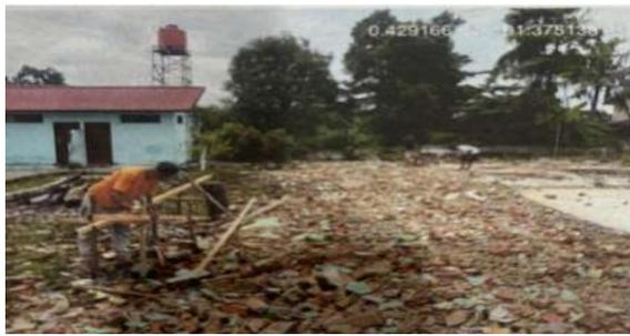
Gambar 3. 1 Pemasangan Bowplank
