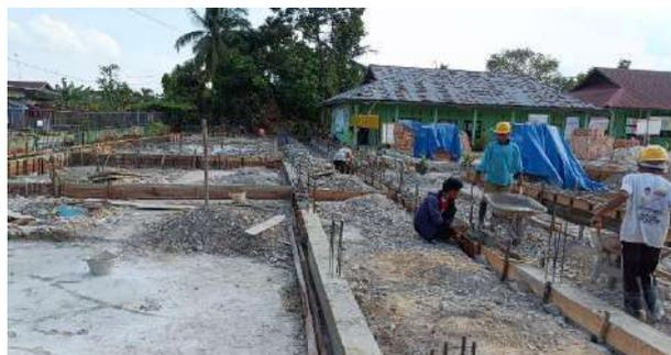
Gambar 3. 10 Pengecoran Sloof
