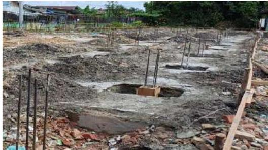
Gambar 3. 6 Pemasangan Bekisting Kolom Pedestal
