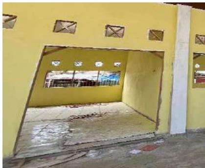
Gambar 3. 34 Pemasangan Ventilasi Pintu
