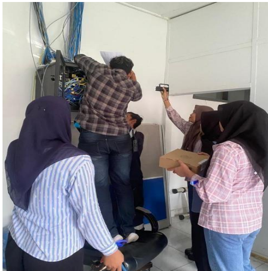
Gambar 3. 5 Perawatan dan Perapihan Horizontal cabling di Rak Server IT
