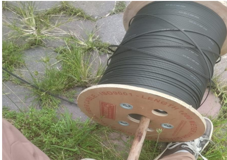
Gambar 3.2 Proses Pemasangan dan Penataan Kabel Fiber Optik (FO)
