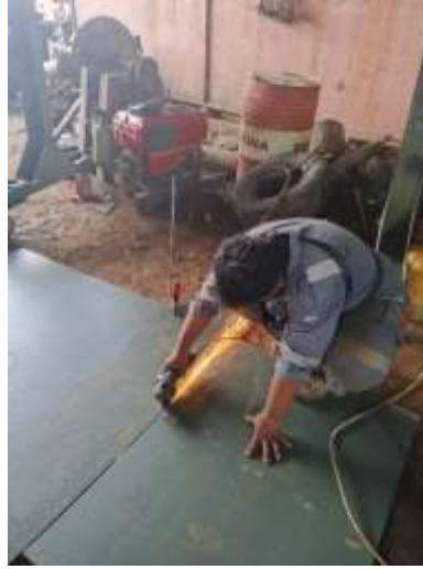
Gambar 3. 32 Pemasangan Lantai Atas Ruangan Mess
