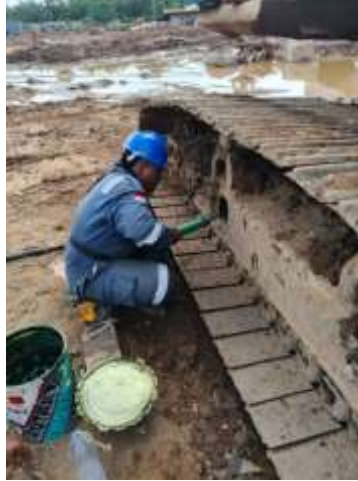
Gambar 3. 3 Mempisot trek excavator
