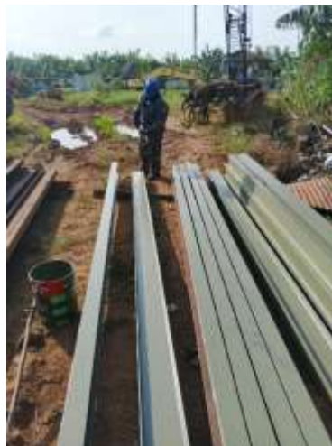
Gambar 3. 15 Pengecatan Besi H
