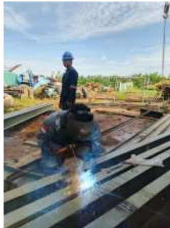
Gambar 3. 25 Pengelasan Penyambungan Besi H-beam
