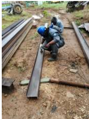
Gambar 3. 13 Membersihkan Besi H Beam
