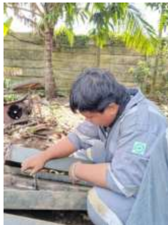
Gambar 3. 29 Membersihkan Slag (Kerak Las)
