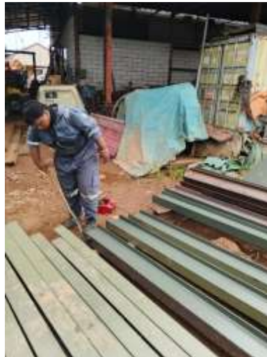
Gambar 3. 17 Mengecat Besi H-beam
