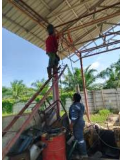
Gambar 3. 22 Pemasangan Bracket
