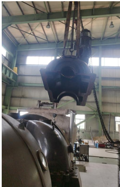
Gambar 3. 4 Proses membuka casing turbin Sumber: dokumentasi pribadi
