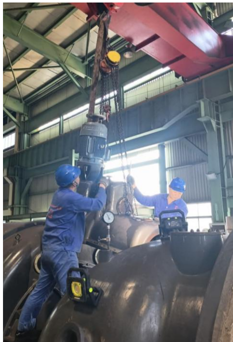
Gambar 3. 11 Proses penutupan casing turbin Sumber: dokumentasi pribadi
