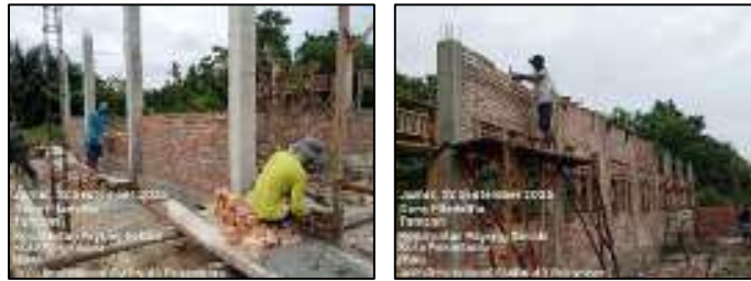
Gambar 3.159 Pemasangan dinding batu bata
