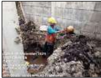
Gambar 3.236 Penggalian tanah tangki septictank (Sumber : Dokumentasi KP, 2025)
