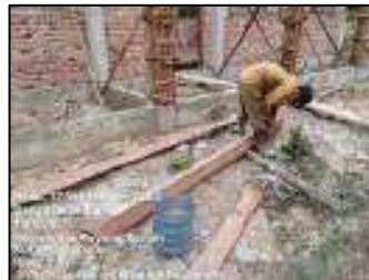
Gambar 3.165 Pembuatan bekisting ring balok (Sumber : Dokumentasi KP, 2025)
