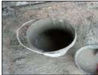
Gambar 3.74 Acian mortar (Sumber : Dokumentasi KP, 2025)
