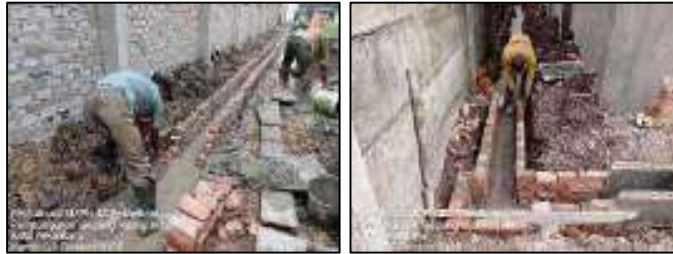
Gambar 3.215 Pemasangan batu bata saluran keliling bangunan (Sumber : Dokumentasi KP, 2025)
