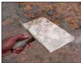
Gambar 3.34 Tatakan semen (Sumber : Dokumentasi KP,2025)
