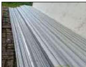
Gambar 3.81 Reng tera R.30 dan rangka canal atap (Sumber : Dokumentasi KP, 2025)
