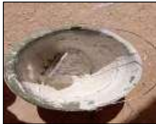
Gambar 3.119 Acian Dempul (Sumber : Dokumentasi KP, 2025)
