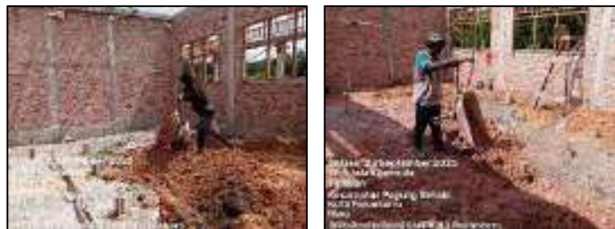
Gambar 3.187 Penimbunan tanah timbun (Sumber : Dokumentasi KP, 2025)
