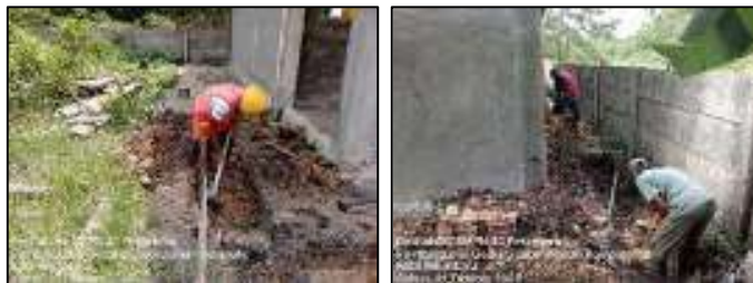
Gambar 3.213 Penggalian tanah untuk saluran keliling (Sumber : Dokumentasi KP, 2025)
