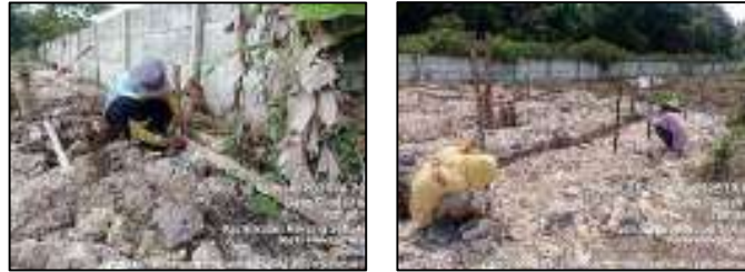
Gambar 3.134 Pekerjaan pemasangan bowplank (Sumber : Dokumentasi KP, 2025)
