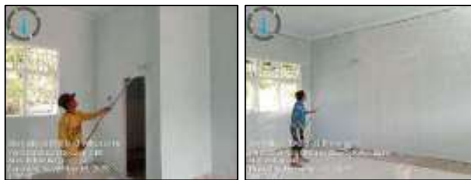
Gambar 3.223 Pengecatan dinding interior (Sumber : Dokumentasi KP, 2025)
