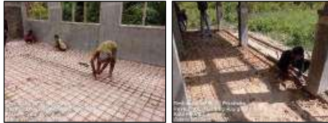
Gambar 3.192 Pemasangan besi wiremesh M8 (Sumber : Dokumentasi KP, 2025)
