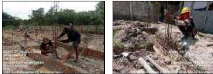
Gambar 3.155 Pemasangan tulangan kolom utama dan kolom selasar (Sumber : Dokumentasi KP, 2025)
