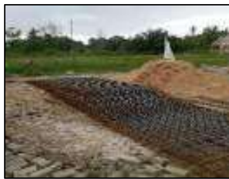
Gambar 3.68 Besi wiremesh M8 (Sumber : Dokumentasi KP, 2025)
