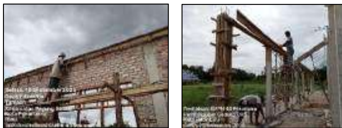
Gambar 3.166 Pemasangan bekisting ring balok (Sumber : Dokumentasi KP, 2025)
