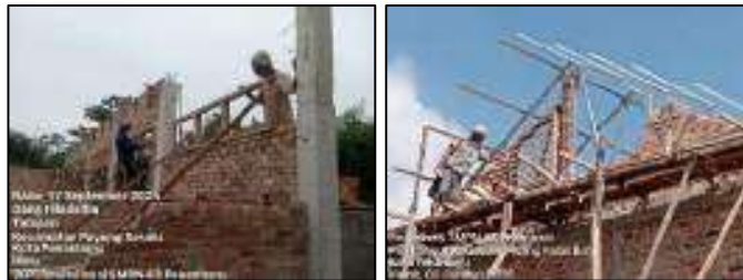
Gambar 3.163 Pemasangan kusen angin-angin atau jalusi kayu (Sumber : Dokumentasi KP, 2025)
