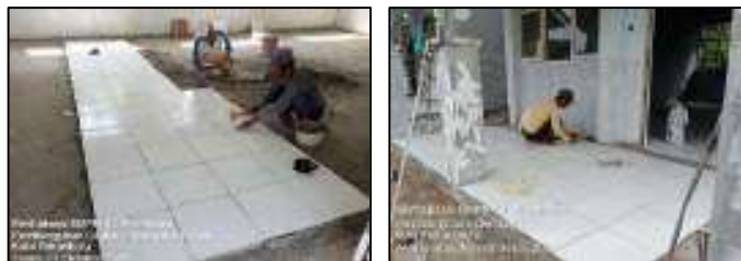
Gambar 3.208 Pemasangan keramik lantai interior dan eksterior (Sumber : Dokumentasi KP, 2025)
