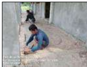
Gambar 3.190 Pematokan ketebalan coran (Sumber : Dokumentasi KP, 2025)
