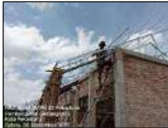
Gambar 3.175 Pemasangan tulangan Ring balok miring (Sumber : Dokumentasi KP, 2025)
