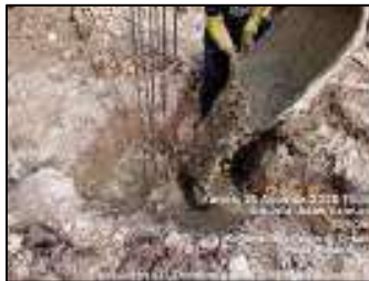
Gambar 3.147 Pengecoran pondasi tapak (Sumber : Dokumentasi KP, 2025)
