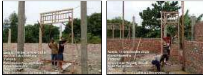
Gambar 3.161 pemasangan kusen pintu kayu (Sumber : Dokumentasi KP, 2025)
