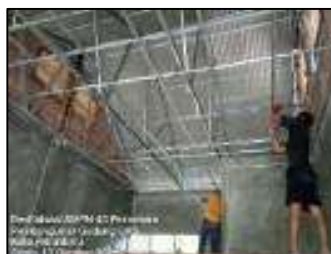
Gambar 3.201 Pemasangan rangka hollow plafond (Sumber : Dokumentasi KP, 2025)
