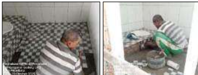
Gambar 3.219 Pemasangan batu bata saluran keliling bangunan (Sumber : Dokumentasi KP, 2025)
