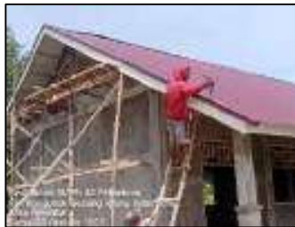
Gambar 3.185 Pemasangan nok tepi atap (Sumber : Dokumentasi KP, 2025)
