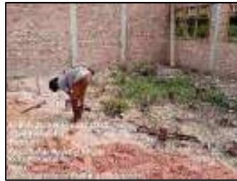
Gambar 3.186 Pematokan ketinggian tanah timbunan (Sumber : Dokumentasi KP, 2025)
