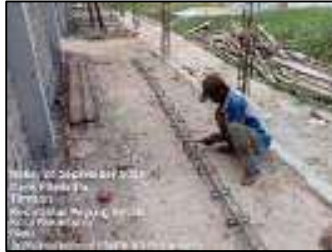
Gambar 3.174 Perakitan tulangan Ring balok miring (Sumber : Dokumentasi KP, 2025)
