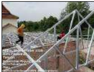
Gambar 3.181 Pemasangan rangka atap baja ringan (Sumber : Dokumentasi KP, 2025)
