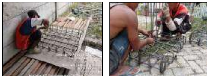
Gambar 3.143 Perakitan tulangan pondasi tapak (Sumber : Dokumentasi KP, 2025)
