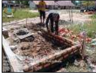
Gambar 3.231 Pemasangan pondasi rolag bata hand railing (Sumber : Dokumentasi KP, 2025)
