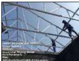
Gambar 3.182 Pemasangan reng atap baja ringan (Sumber : Dokumentasi KP, 2025)
