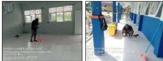
Gambar 3.241 Pembersihan interior bangunan (Sumber : Dokumentasi KP, 2025)
