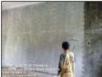
Gambar 3.222 Pengecatan plamir dinding (Sumber : Dokumentasi KP, 2025)
