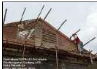
Gambar 3.177 Pemasangan bekisting Ring balok miring (Sumber : Dokumentasi KP, 2025)
