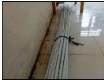
Gambar 3.103 Pipa kabel PVC 5/8" (Sumber : Dokumentasi KP, 2025)
