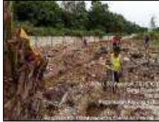
Gambar 3.135 Pekerjaan galian tanah pondasi (Sumber : Dokumentasi KP, 2025)
