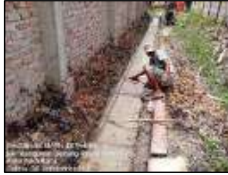
Gambar 3.214 Pengecoran lantai kerja (Sumber : Dokumentasi KP, 2025)
