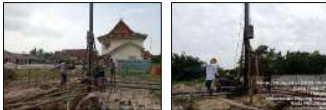
Gambar 3.136 Pemancangan kayu cerucuk pondasi (Sumber : Dokumentasi KP,2025)
