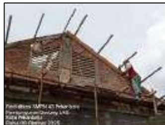
Gambar 3.176 Pembuatan bekisting Ring balok miring (Sumber : Dokumentasi KP, 2025)
