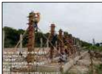
Gambar 3.157 Pemasangan bekisting kolom (Sumber : Dokumentasi KP, 2025)
