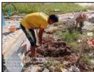
Gambar 3.230 Penggalan tanah untuk jalur hand railing (Sumber : Dokumentasi KP, 2025)
