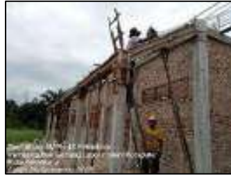
Gambar 3.173 Pengecoran balok gantung (Sumber : Dokumentasi KP, 2025)
