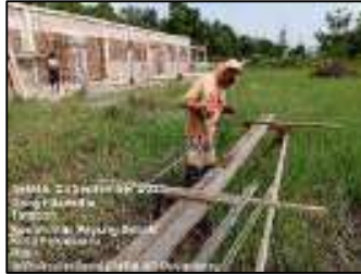
Gambar 3.168 Perakitan tulangan balok gantung (Sumber : Dokumentasi KP, 2025)
