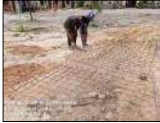
Gambar 3.191 Pemotongan besi wiremesh (Sumber : Dokumentasi KP, 2025)
