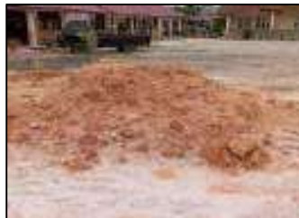
Gambar 3.63 Tanah urug (Sumber : Dokumentasi KP, 2025)
