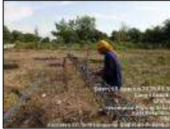
Gambar 3.164 Perakitan tulangan ring balok (Sumber : Dokumentasi KP, 2025)
