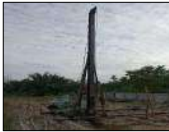
Gambar 3.28 Drop Hammer machine / alat pancang kayu cerucuk (Sumber : Dokumentasi KP, 2025)
