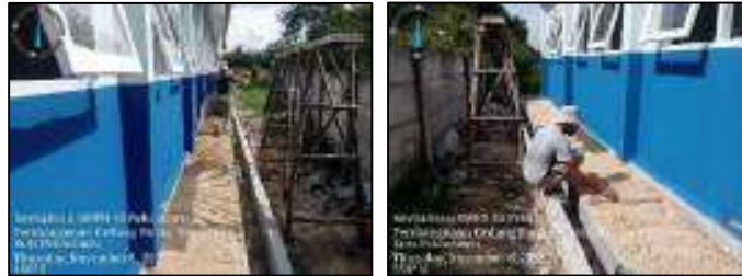
Gambar 3.227 Pengurugan pasir urug bawah paving block (Sumber : Dokumentasi KP, 2025)
