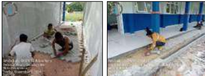
Gambar 3.228 Pemasangan paving block (Sumber : Dokumentasi KP, 2025)
