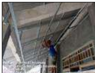
Gambar 3.204 Pemasangan rangka hollow plafond (Sumber : Dokumentasi KP, 2025)
