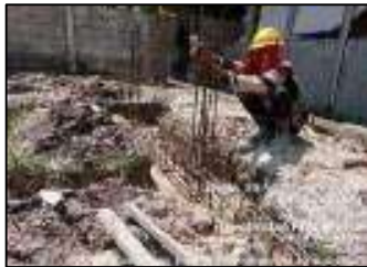
Gambar 3.150 Pemasangan tulangan sloof pondasi (Sumber : Dokumentasi KP, 2025)
