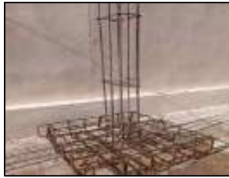
Gambar 3.78 Tulangan pondasi tapak (Sumber : Dokumentasi KP, 2025)
