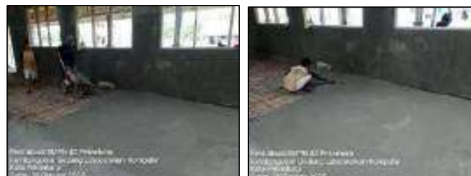
Gambar 3.194 Pengecoran lantai kerja (Sumber : Dokumentasi KP, 2025)
