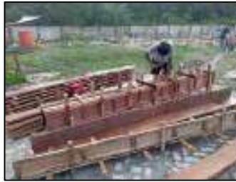
Gambar 3.156 Pembuatan bekisting kolom (Sumber : Dokumentasi KP, 2025)
