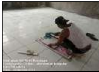
Gambar 3.207 Pemotongan keramik (Sumber : Dokumentasi KP, 2025)
