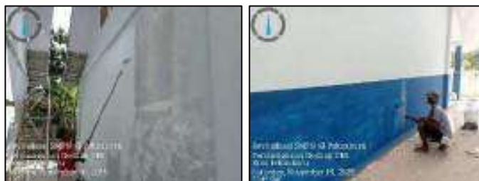
Gambar 3.224 Pengecatan dinding eksterior (Sumber : Dokumentasi KP, 2025)
