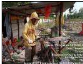
Gambar 3.142 Pembengkokan besi tulangan utama dan pembuatan tulangan begel (Sumber : Dokumentasi KP, 2025)
