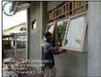
Gambar 3.212 Pemasangan angin-angin (Sumber : Dokumentasi KP, 2025)
