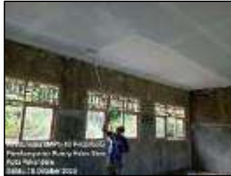
Gambar 3.221 Pengecatan plafond gypsum (Sumber : Dokumentasi KP, 2025)
