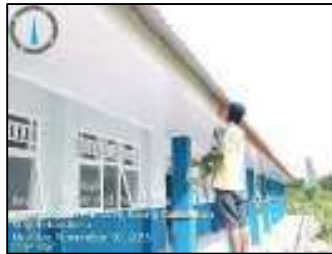
Gambar 3.226 Pengecatan listplank GRC (Sumber : Dokumentasi KP, 2025)
