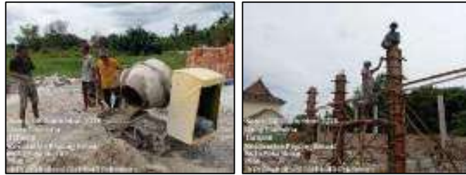
Gambar 3.158 Pengecoran kolom (Sumber : Dokumentasi KP, 2025)
