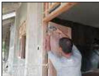
Gambar 3.209 Pemasangan daun pintu (Sumber : Dokumentasi KP, 2025)
