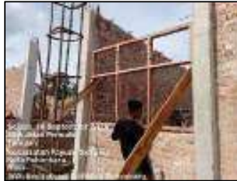
Gambar 3.97 Kusen jendela kayu (Sumber : Dokumentasi KP, 2025)
