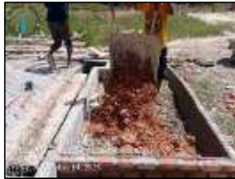
Gambar 3.232 Pengurukan tanah urug untuk jalur hand railing (Sumber : Dokumentasi KP, 2025)
