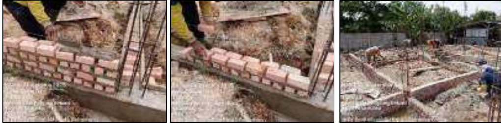
Gambar 3.153 Pemasangan pondasi batu bata rolag (Sumber : Dokumentasi KP, 2025)
