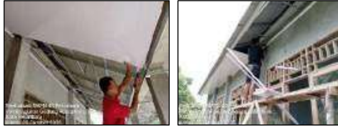
Gambar 3.205 Pemasangan plafond gypsum dan list plafond PVC (Sumber : Dokumentasi KP, 2025)
