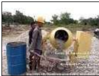
Gambar 3.146 Pengadukan beton dengan molen (Sumber : Dokumentasi KP, 2025)
