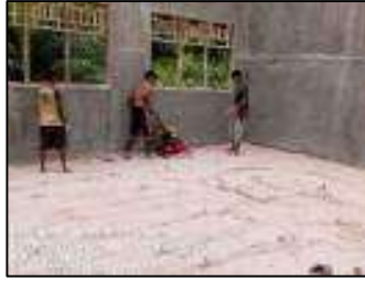
Gambar 3.189 Pemadatan tanah timbunan (Sumber : Dokumentasi KP, 2025)
