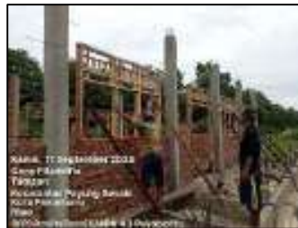
Gambar 3.162 Pemasangan kusen jendela kayu (Sumber : Dokumentasi KP, 2025)
