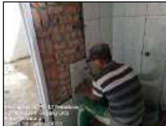
Gambar 3.218 Pemasangan keramik dinding (Sumber : Dokumentasi KP, 2025)
