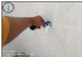
Gambar 3.220 Pemasangan kran air bersih dan wastafel (Sumber : Dokumentasi KP, 2025)
