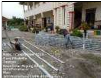
Gambar 3.180 Perakitan rangka atap baja ringan (Sumber : Dokumentasi KP, 2025)
