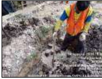
Gambar 3.139 Pengecekan ketebalan urugan pasir bawah pondasi (Sumber : Dokumentasi KP, 2025)
