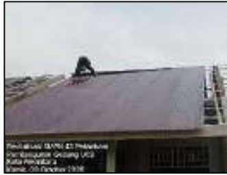
Gambar 3.184 Pemasangan rabung atap (Sumber : Dokumentasi KP, 2025)
