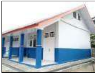
Gambar 3.252 Tampak depan UKS (Sumber : Dokumentasi KP, 2025)
