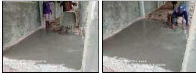
Gambar 3.195 Pengecoran lantai kerja selasar (Sumber : Dokumentasi KP, 2025)
