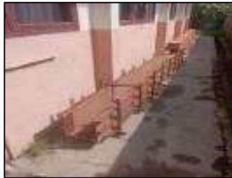
Gambar 3.80 Bekisting multiplek (Sumber : Dokumentasi KP, 2025)
