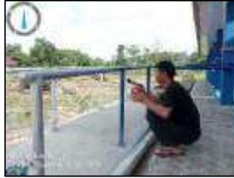
Gambar 3.235 Pengecatan hand railing (Sumber : Dokumentasi KP, 2025)
