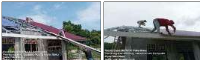
Gambar 3.183 Pemasangan penutup atap spandek (Sumber : Dokumentasi KP, 2025)
