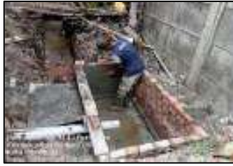
Gambar 3.239 Pemplasteran dinding bata septictank (Sumber : Dokumentasi KP, 2025)
