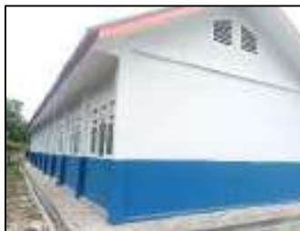
Gambar 3.247 Tampak belakang RKB (Sumber : Dokumentasi KP, 2025)
