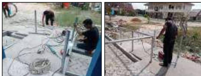
Gambar 3.234 Pengelasan tiang dan pegangan hand railing (Sumber : Dokumentasi KP, 2025)
