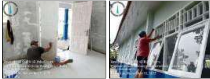
Gambar 3.225 Pengecatan kusen (Sumber : Dokumentasi KP, 2025)
