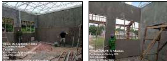
Gambar 3.196 Pekerjaan plasteran dan acian dinding dalam (Sumber : Dokumentasi KP, 2025)
