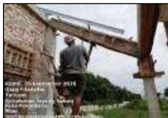
Gambar 3.172 Pemasangan bekisting balok gantung. (Sumber : Dokumentasi KP, 2025)
