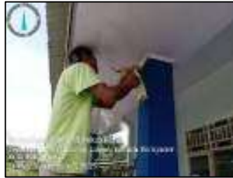
Gambar 3.206 Penutupan sambungan plafond PVC (Sumber : Dokumentasi KP, 2025)
