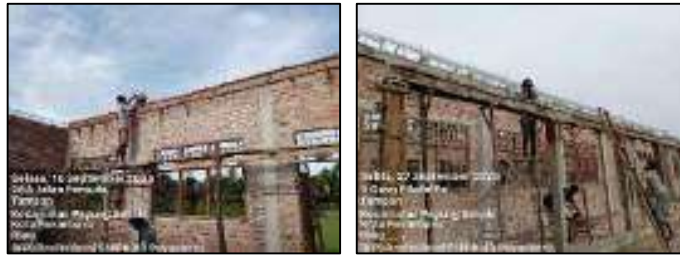
Gambar 3.167 Pengecoran ring balok (Sumber : Dokumentasi KP, 2025)
