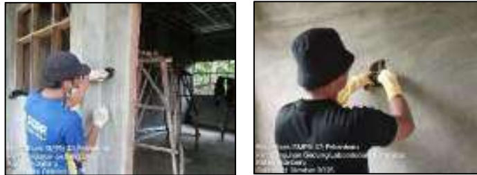
Gambar 3.198 Pemasangan rumah saklar dan stop kontak (Sumber : Dokumentasi KP, 2025)
