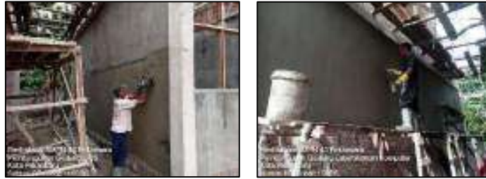
Gambar 3.197 Pekerjaan plasteran dan acian dinding luar (Sumber : Dokumentasi KP, 2025)
