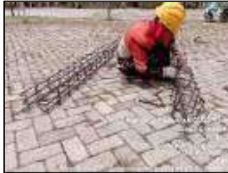
Gambar 3.154 Perakitan tulangan elemen struktur kolom (Sumber : Dokumentasi KP, 2025)
