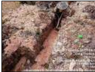
Gambar 3.137 Pengurungan pasir bawah pondasi lajur (Sumber : Dokumentasi KP, 2025)
