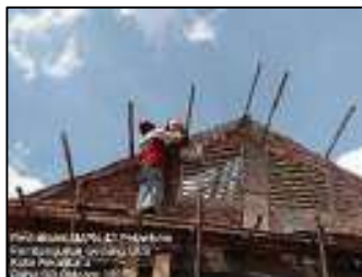
Gambar 3.178 Pengecoran Ring balok miring (Sumber : Dokumentasi KP, 2025)
