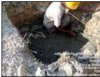
Gambar 3.145 Pengecoran lantai kerja pondasi tapak (Sumber : Dokumentasi KP, 2025)
