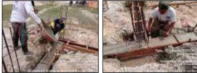
Gambar 3.152 Pengecoran sloof pondasi (Sumber : Dokumentasi KP, 2025)
