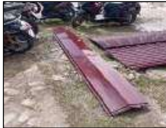
Gambar 3.83 Nok penutup atap spandek / rabung galvalum 0,3mm (Sumber : Dokumentasi KP, 2025)
