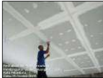
Gambar 3.203 Penutupan sambungan plafond gypsum (Sumber : Dokumentasi KP, 2025)
