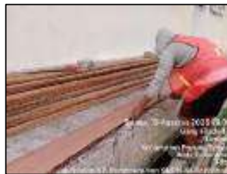
Gambar 3.170 Pembuatan bekisting balok gantung (Sumber : Dokumentasi KP, 2025)
