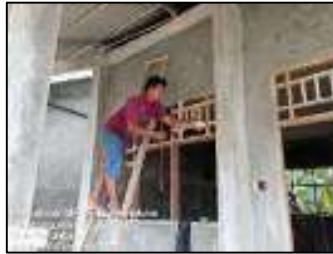
Gambar 3.211 Pemasangan angin-angin (Sumber : Dokumentasi KP, 2025)
