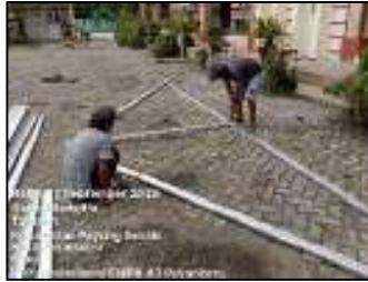
Gambar 3.179 Pengukuran dan desain rangka atap baja ringan (Sumber : Dokumentasi KP, 2025)
