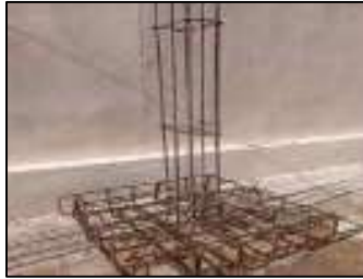
Gambar 3.144 Hasil perakitan pondasi tapak (Sumber : Dokumentasi KP, 2025)
