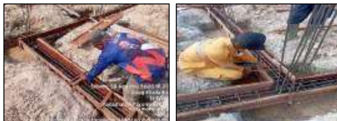
Gambar 3.152 Pemasangan bekisting sloof pondasi (Sumber : Dokumentasi KP, 2025)
