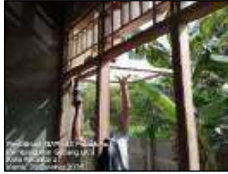
Gambar 3.210 Pemasangan daun jendela (Sumber : Dokumentasi KP, 2025)
