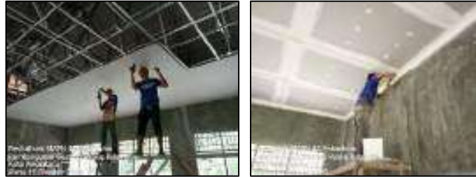
Gambar 3.202 Pemasangan plafond gypsum dan list plafond gypsum (Sumber : Dokumentasi KP, 2025)
