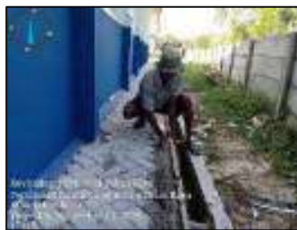
Gambar 3.229 Penguncian paving block (Sumber : Dokumentasi KP, 2025)
