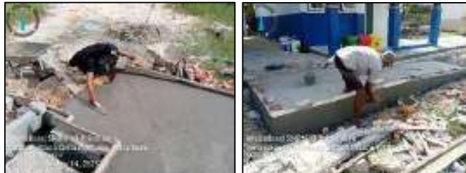
Gambar 3.233 Pengecoran dan plasteran lantai kerja hand railing (Sumber : Dokumentasi KP, 2025)
