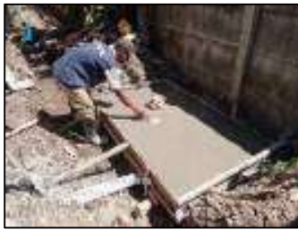
Gambar 3.240 Pengecoran penutup septictank (Sumber : Dokumentasi KP, 2025)
