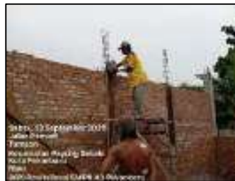
Gambar 3.160 Pengecoran kolom praktis (Sumber : Dokumentasi KP, 2025)
