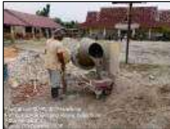
Gambar 3.193 Pengadukan campuran beton coran (Sumber : Dokumentasi KP, 2025)
