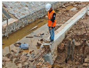
Gambar 1.1 Kemiringan pada kanal Sumber : Dokumentasi lapangan, 2025
