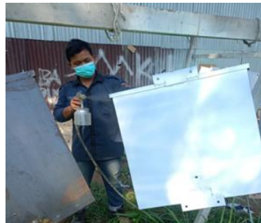
Gambar 3. 51 Pengecatan pada Junction Box Sumber: Pribadi
