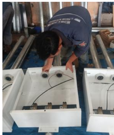
Gambar 3. 53 Proses pemasangan bagian dalam Junction Box Sumber: Pribadi
