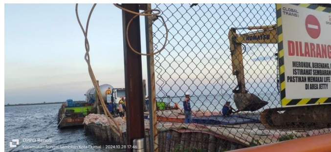
Gambar 3. 40 Pemasangan Ramp Door
