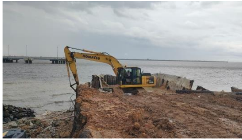
Gambar 3. 45 Pembongkaran Jetty
