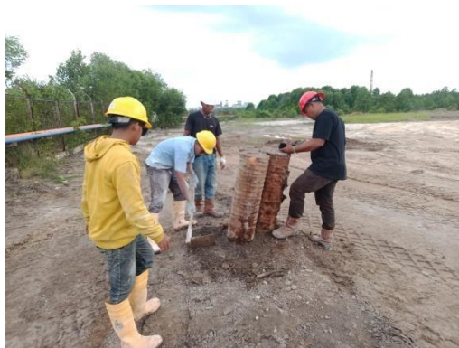
Gambar 3. 41 Pemasangan Bollard
