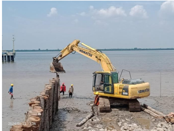
Gambar 3. 20 Pemancangan Batang Kelapa
