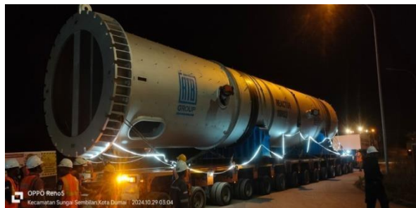
Gambar 3. 44 Penempatan Vessels Reactor
