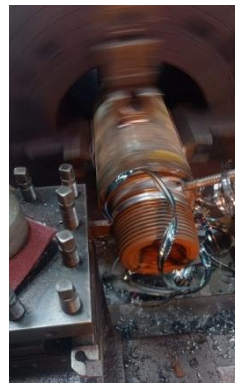
Gambar 4 4 Proses pemotongan connection lama Sumber : Dokumentasi
