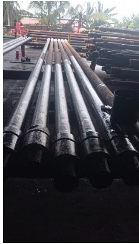
Lampiran 1 Proses coating pada pipa
