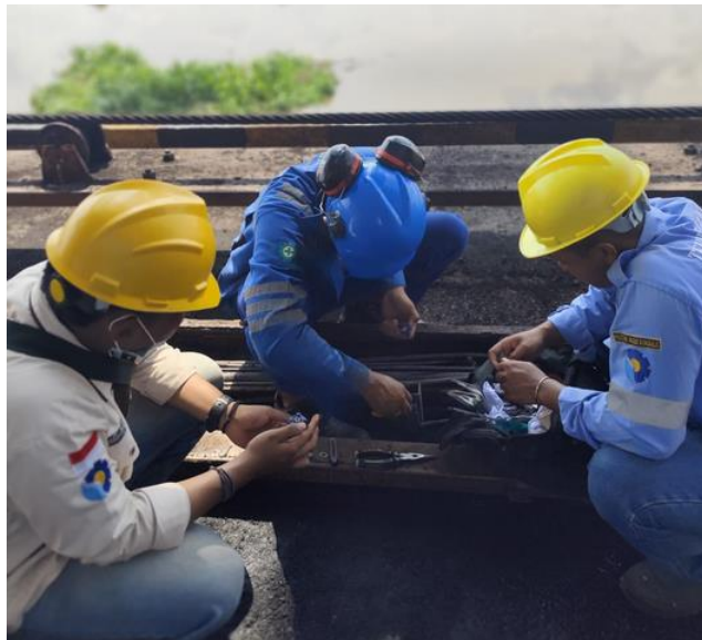
Gambar 2. 14 penggantian Limit Switch
