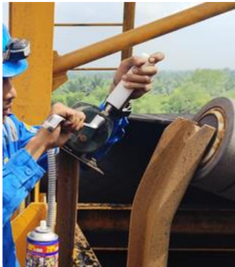
Gambar 2. 13 Perbaikan Sensor Belt Sway
