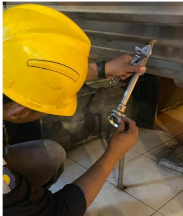
Gambar 2. 4 Penggantian Sensor Rod-Type
