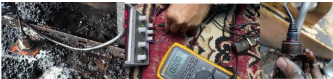
Gambar 3. 19 Pengecekan Kondisi Fisik, Kabel, dan Tegangan Pada Sensor
