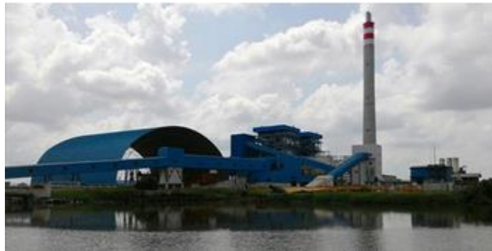
Gambar 1. 4 PT PLN NUSANTARA POWER UP TENAYAN Dari Belakang
