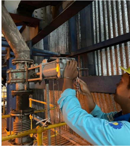
Gambar 2. 17 penggantian valve outlet
