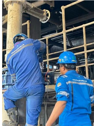
Gambar 2. 1 Mengatasi Kemacetan Pada Pneumatik Valve
