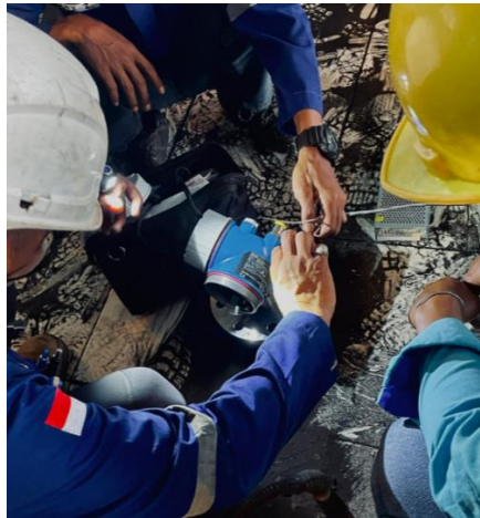
Gambar 2. 8 Penggantian Sensor Ultrasonik
