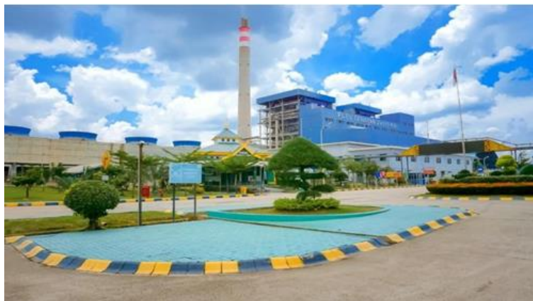
Gambar 1. 3 PT PLN NUSANTARA POWER UP TENAYAN Dari Depan
