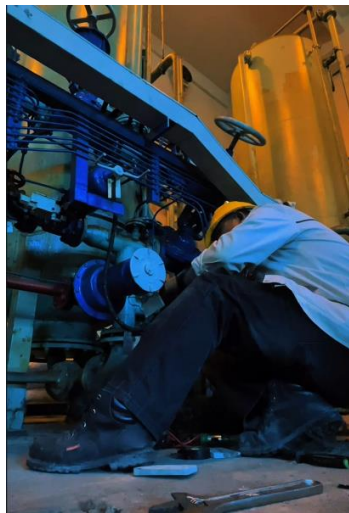
Gambar 2. 10 Perbaikan Kabel Limit Switch Valve
