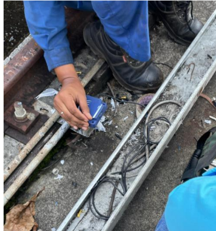
Gambar 2. 5 Perbaikan Kabel Sensor Proximity
