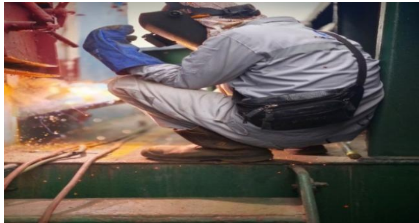
Gambar 4.30 Proses Pengelasan Pelat Bottom Kanan Tengah
