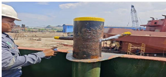
Gambar 4.9 Proses Pemarkingan Tanduk Single Border
