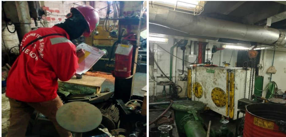
Gambar 4.58 Pemeriksaan Kondisi Area Kerja Sebelum Proses Hot Work
