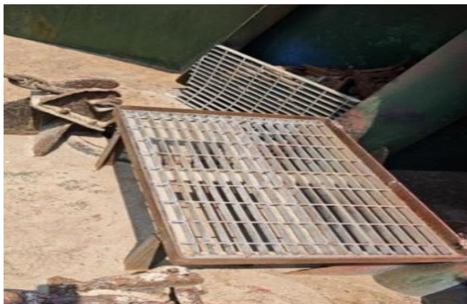
Gambar 4.63 Hasil Pekerjaan Repair Panggung Twin Bolder Menampilkan pelat penyangga berlubang ( grating board ) untuk platform pijakan Twin Bolder yang telah disatukan dan kokoh terpasang.
