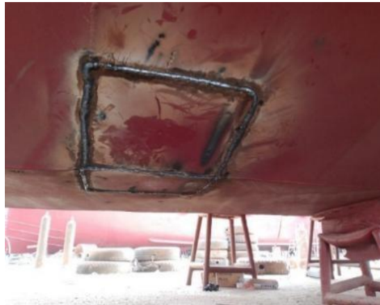
Gambar 4.60 Hasil Pekerjaan Repair Pelat Bottom
