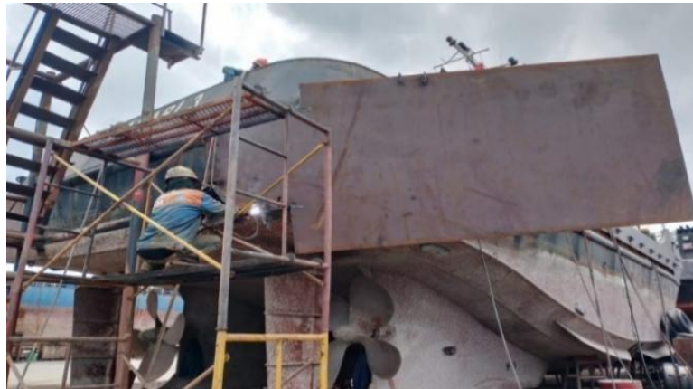
Gambar 4.24 Proses Fit Up Pelat Corner Kanan Belakang
