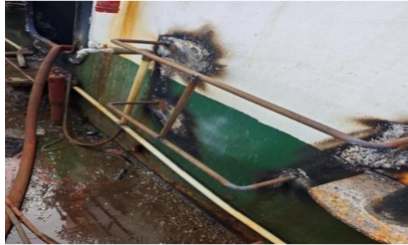
Gambar 4.65 Hasil Pekerjaan Dudukan Lifebuoy
