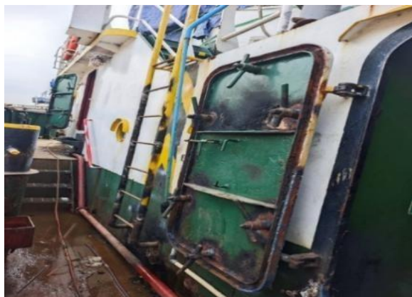
Gambar 4.61 Hasil Pekerjaan Pergantian List Pintu
