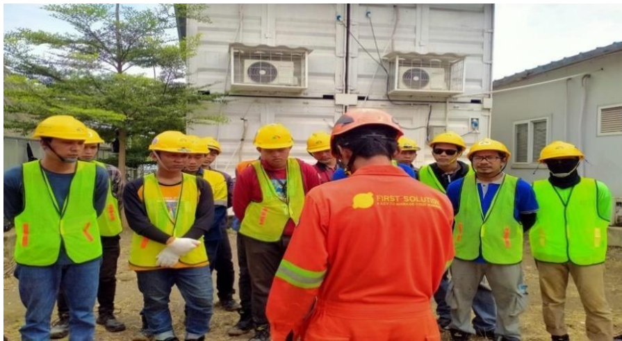
Gambar 4.46 Pemeriksaan dan Penggunaan APD Sebelum Pekerjaan Replating
