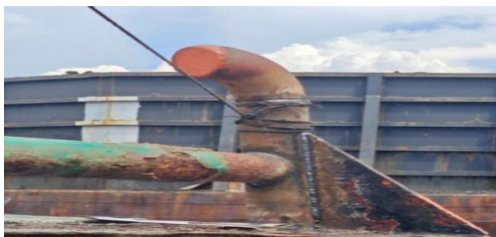
Gambar 4.64 Hasil Pekerjaan Repair Tanduk Safety Towwing
