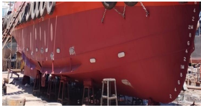
Gambar 4.66 Hasil Pekerjaan Pemasangan Anti Karat Baru
