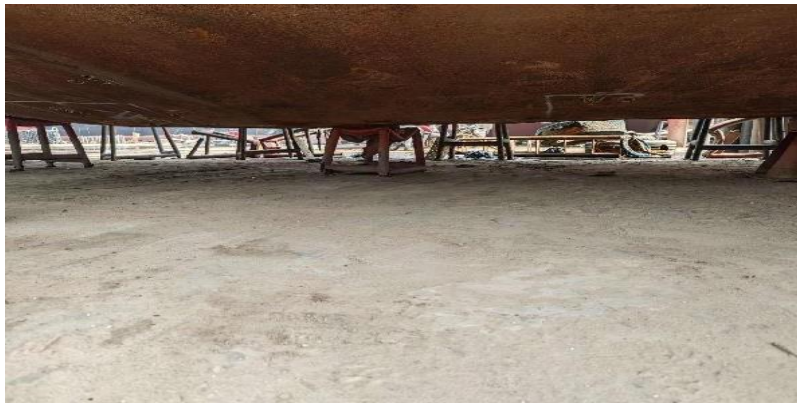
Gambar 4.7 Proses Pemarkingan Pada Area Bottom 2
