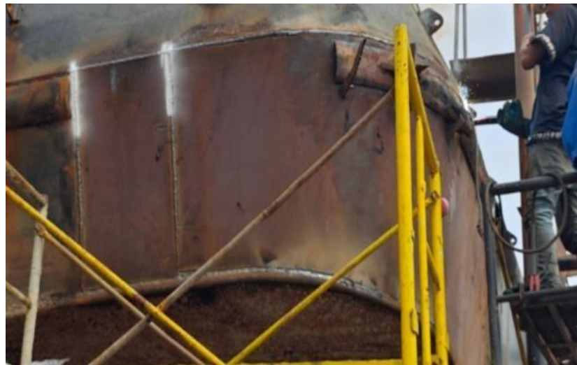
Gambar 4.37 Hasil Pengelasan Pelat Corner
