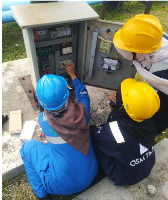
Gambar 3.5 Perbaiki Jaringan Vidiotron Di Gerbang Kantor Kilang
