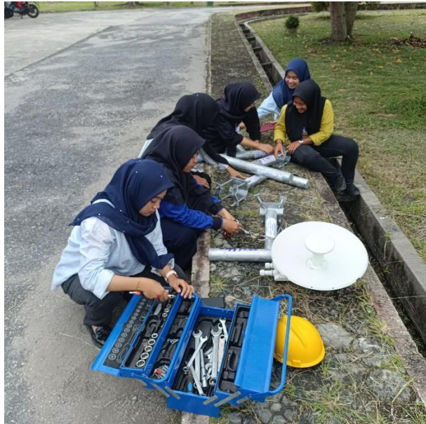
Gambar 3.3 Pemasangan Antena Di Tiang Tower Kantor IT
