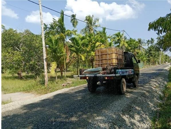
GAMBAR 3. 27 Pekerjaan Penyiraman Air Pada Base A
