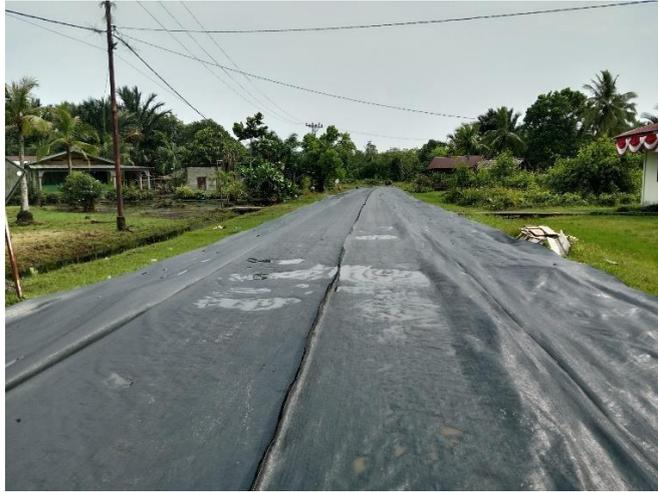
*GAMBAR 3. 14 Pemasangan Geotextile STA 00+000-00+150
