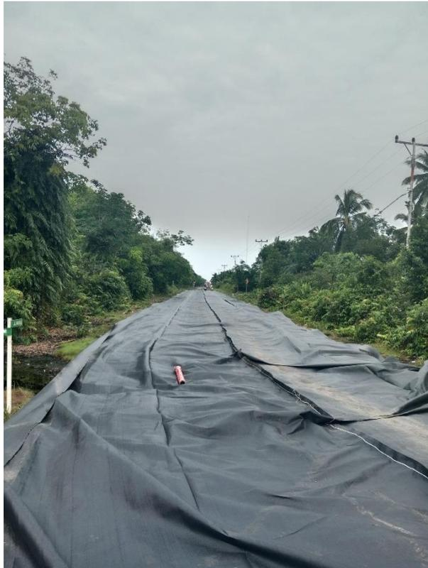
*GAMBAR 3. 15 Pemasangan Geotextile STA 00+150-00+250
