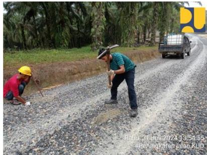
(Gambar 4. 8 Menggali lubang pada Base A)
