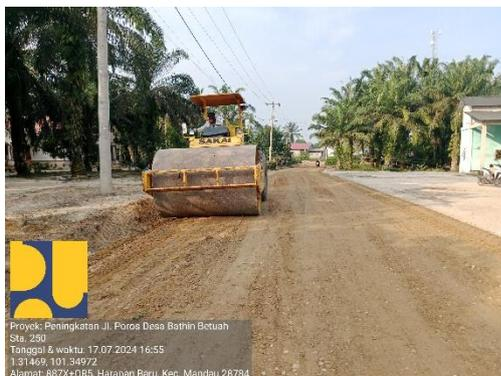
Setelah dilakukan penghamparan material Base B kemudian diratakan menggunakan alat berat *Motor Grader*. Dilanjutkan dengan pemadatan sementara menggunakan alat berat *Vibratory Roller*.
