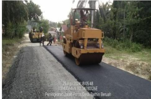
(Gambar 3. 30 Pemadatan AC-BC dengan Tandem Roller)
