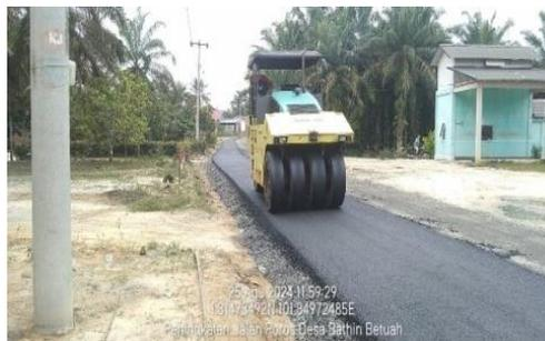
(Gambar 3. 31 Pemadatan akhir dengan Pneumatic Tired Roller)
