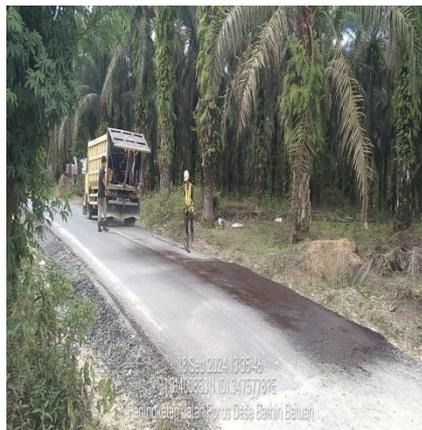
(Gambar 3. 28 Penyiraman Prime Coat)
