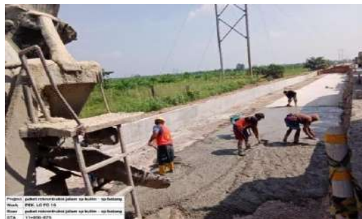
Gambar 3. 14 Pekerjaan pengecoran LC
