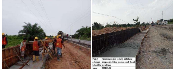
Gambar 3. 13 Pekerjaan pengecoran DPT
