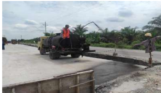
Gambar 3. 23 Pekerjaan penyemprotan perekat
