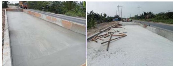
Gambar 3. 20 Lokasi yang sudah dilakukan pengecoran
