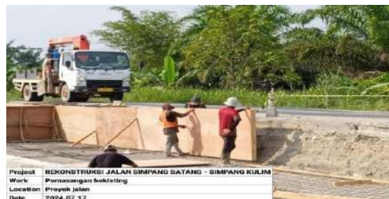
Gambar 3. 12 Pekerjaan pemasangan bekisting
