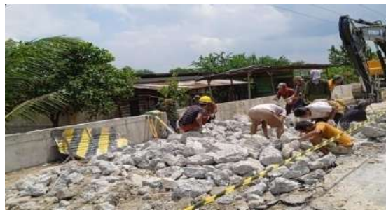
Gambar 3. 10 Pekerjaan pembongkaran beton lama
