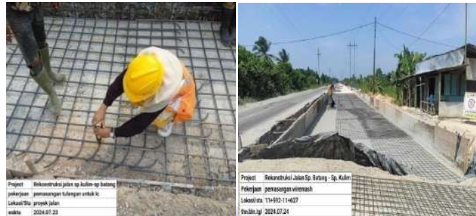
Gambar 3. 15 Pekerjaan pemasangan wiremesh
