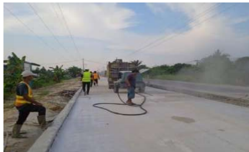
Gambar 3. 22 Pekerjaan pembersihan badan jalan
