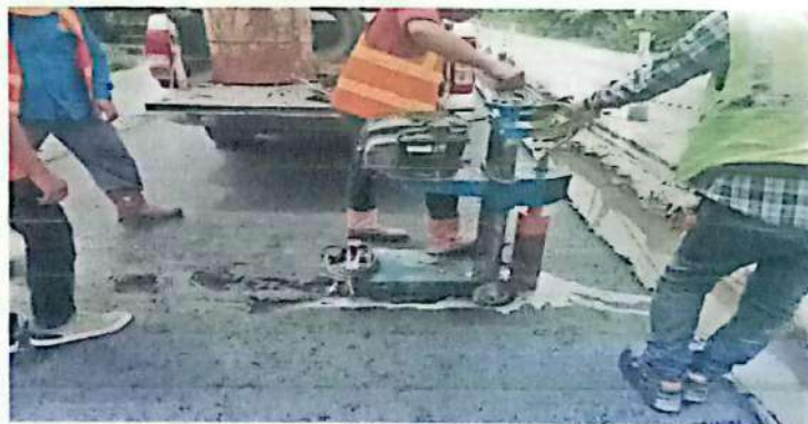
Melihat pekerjaan core dril bertujuan untuk mengetahui ketebalan aspal
