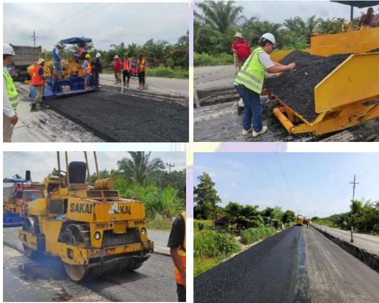
Gambar 3. 24 Pekerjaan Aspal
