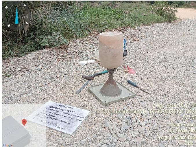
Gambar 3.14 (Pengujian Sandcone) Sumber : Dokumentasi Lapangan, 2024
