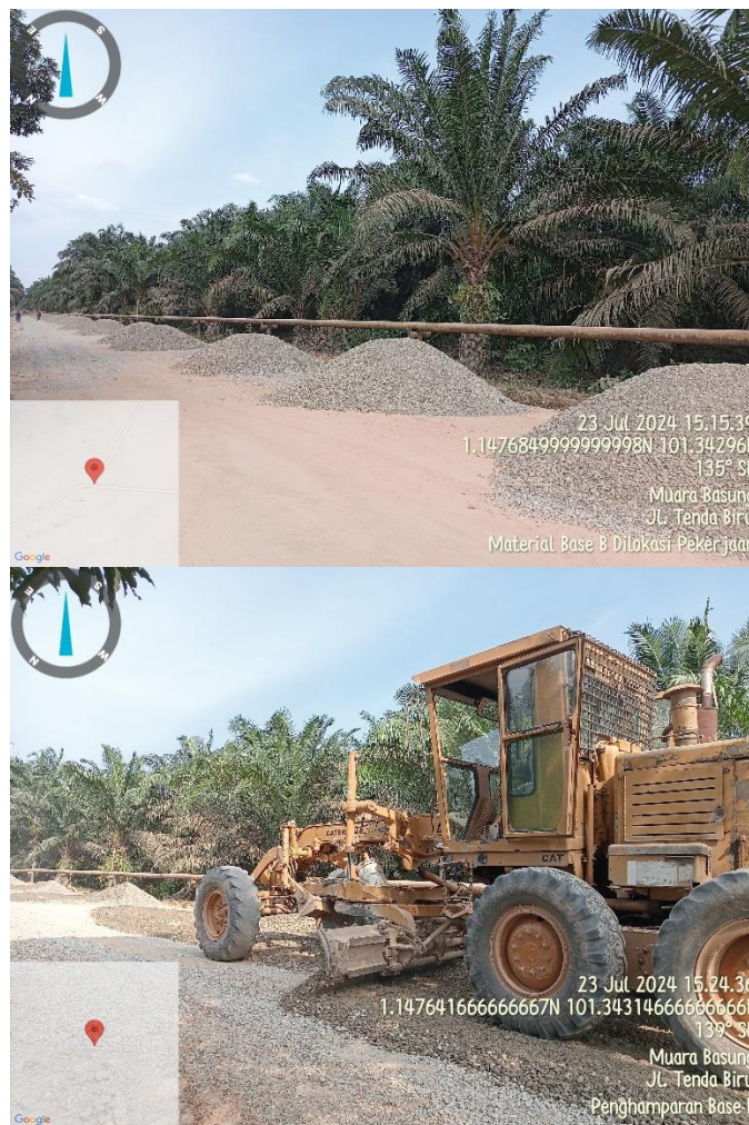
Gambar 3.12 (Pekerjaan Penghamparan Base B Menggunakan Motor Greder) Sumber : Dokumentasi Lapangan, 2024
