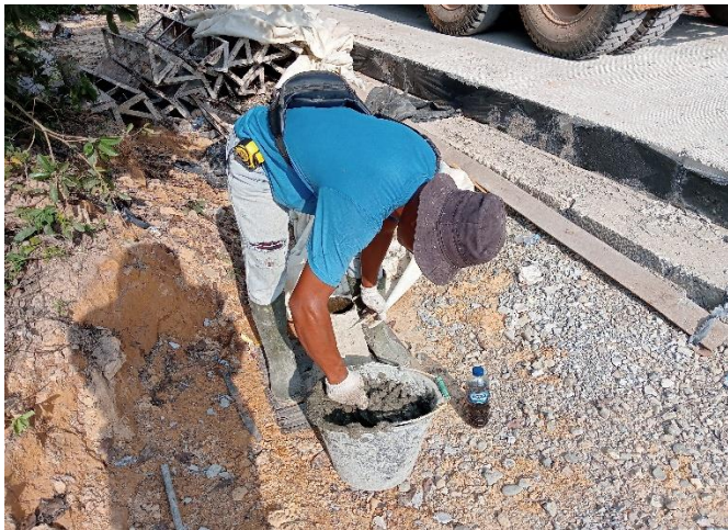
Gambar 4.1 (Pengujian Slump) Sumber : Dokumentasi Lapangan, 2024
