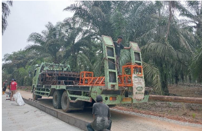
Gambar 3.10 (Mobilisasi Material) Sumber : Dokumentasi Lapangan,2024
