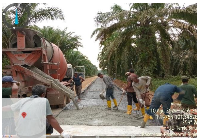
Gambar 4.9 (Pengecoran Beton Rigid) Sumber : Dokumentasi Lapangan,2024
