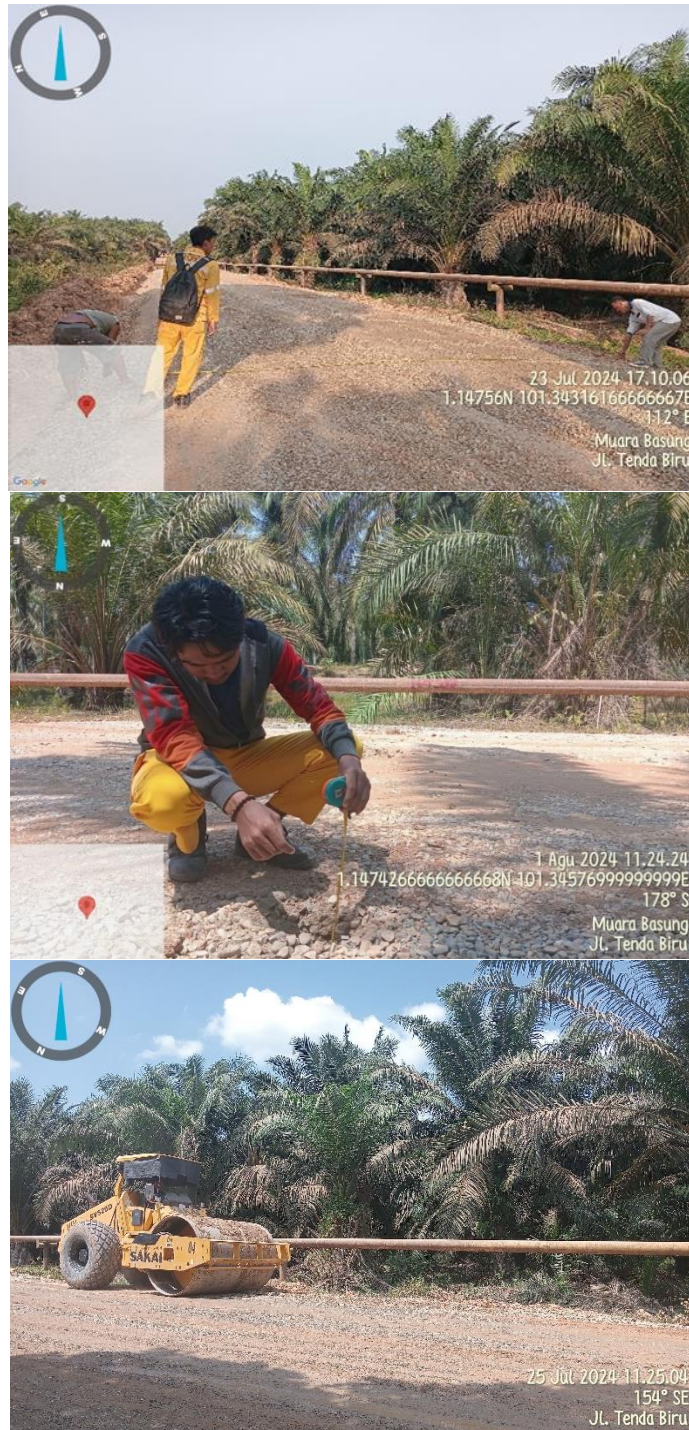
Gambar 3.13 (Pekerjaan Penyiapan Badan Jalan & Pemadatan Base B) Sumber : Dokumentasi Lapangan, 2024
