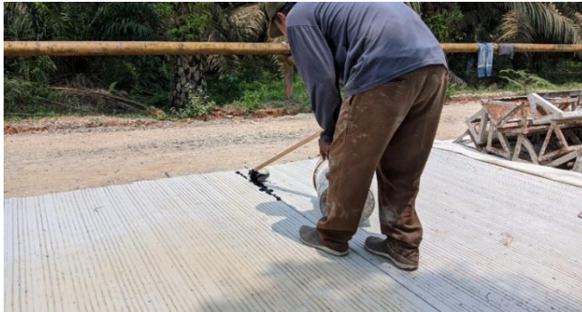
gambar 4.23 (Pekerjaan Joint Sealent) Sumber : Dokumentasi Lapangan, 2024
