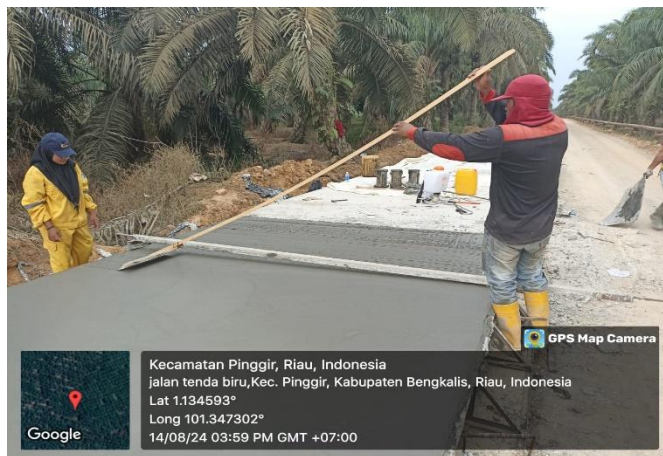
Gambar 4.18 (Proses Grooving) Sumber : Dokumentasi Lapangan, 2024
