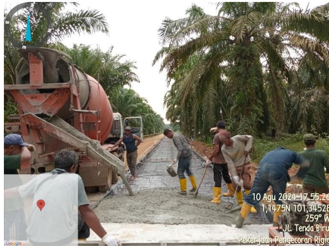
Gambar 4.14 (Penuangan Campuran Beton) Sumber : Dokumentasi Lapangan, 2024
