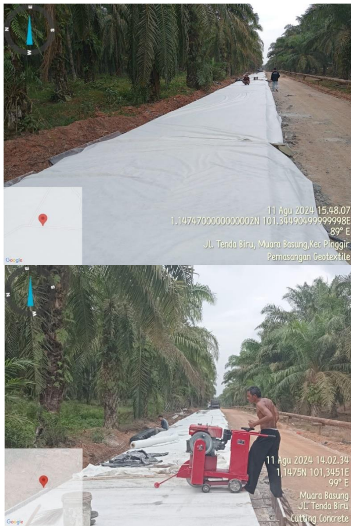
Gambar 3.28 (Penutupan Jalan Dengan Geotextile & Cutting Concrete) Sumber : Dokumentasi Lapangan, 2024
