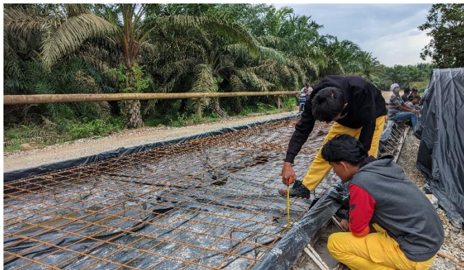
Gambar 4.8 (Opname Sebelum Pengecoran) Sumber : Dokumentasi Lapangan, 2024
