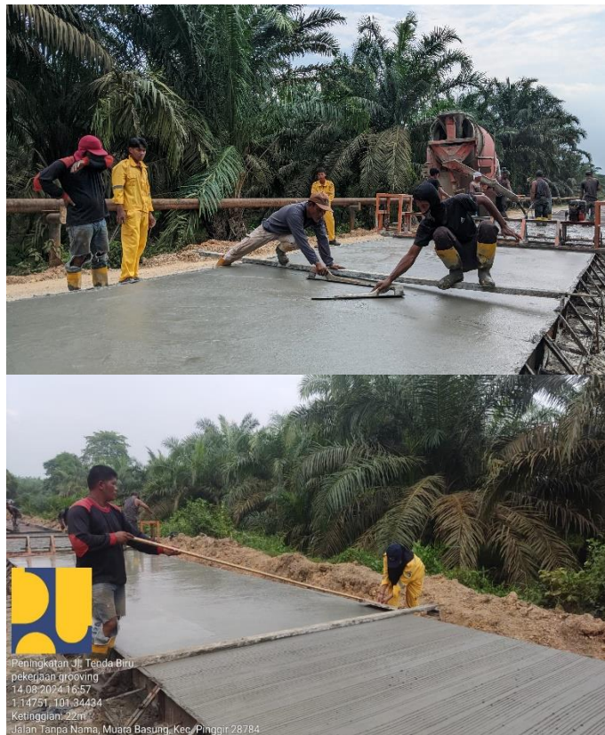
Gambar 3.27 (Pekerjaan Tulangan Rigid,Pengecoran & Grooving) Sumber : Dokumentasi Lapangan,2024
