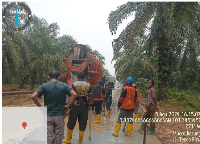
Gambar 3.36 (Hujan Saat Pengecoran) Sumber : Dokumentasi Lapangan,2024
