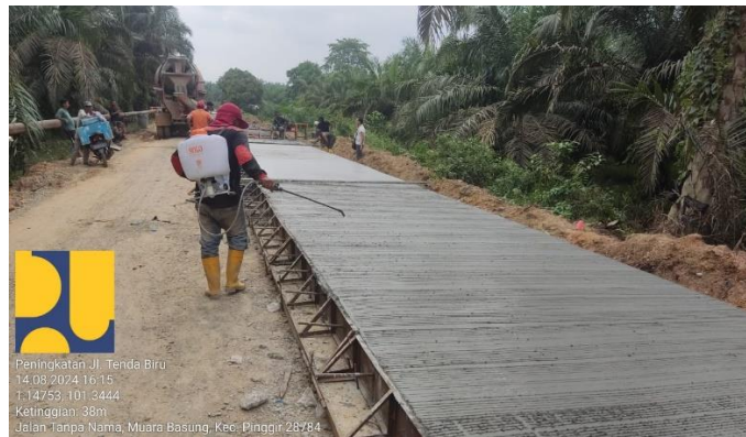
Gambar 4.19 (Proses Penyemprotan Compound) Sumber : Dokumentasi Lapangan,2024
