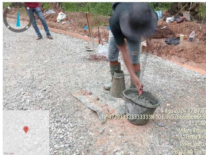
Gambar 3.16 (Pengujian Slump) Sumber : Dokumentasi Lapangan, 2024
