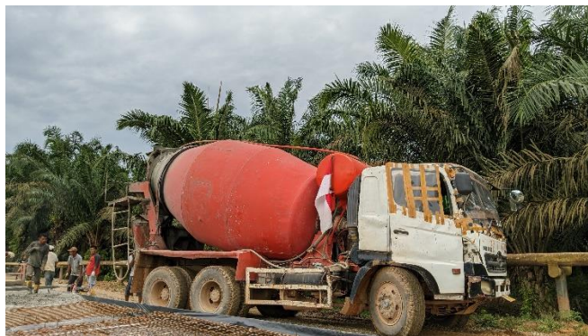
Gambar 4.10 (Truck Mixer di Lokasi Pengecoran) Sumber : Dokumentasi Lapangan,2024
