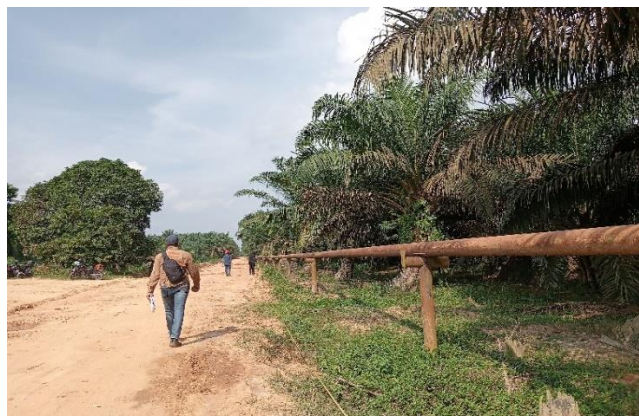
Gambar 3.11 (Pematokan Per STA) Sumber : Dokumentasi Lapangan,2024
