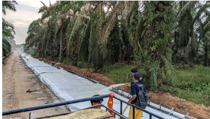
Gambar 4.21 (Pekerjaan Curring Beton) Sumber : Dokumentasi Lapangan, 2024
