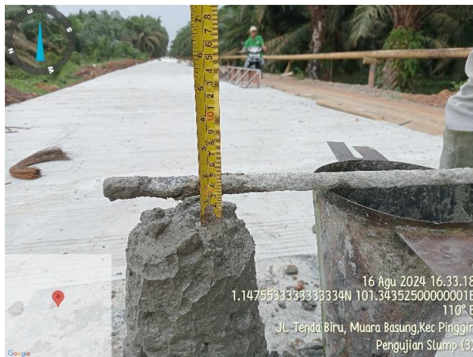
Gambar 4.12 (Pengujian Slump) Sumber : Dokumentasi Lapangan, 2024
