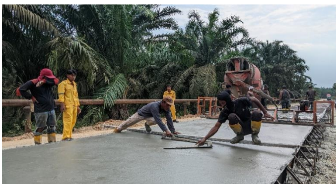
Gambar 4.17 (Proses Finishing) Sumber : Dokumentasi Lapangan, 2024
