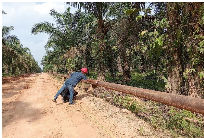
Gambar 3.1 (Pekerjaan Pengukuran & Pematokan) Sumber : Dokumentasi Lapangan, 2024
