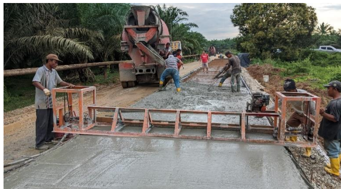
Gambar 4.16 (Proses Perataan Permukaan Beton Rigid) Sumber : Dokumentasi Lapangan, 2024
