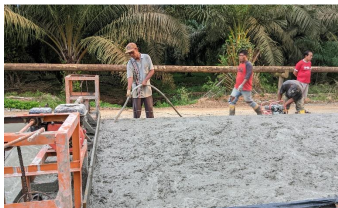
Gambar 4.15 (Proses Pemadatan Beton) Sumber : Dokumentasi Lapangan, 2024
