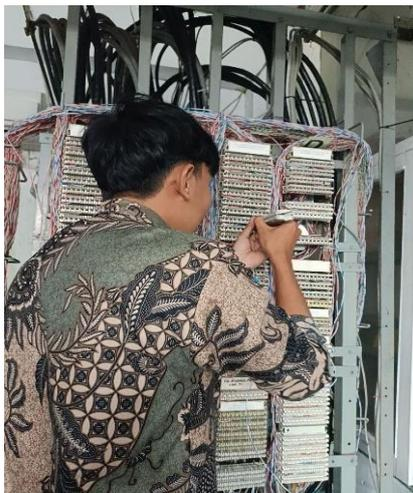
Gambar 3. 1 Instalasi Jaringan Intranet Pada Perangkat Main Distribution Frame
