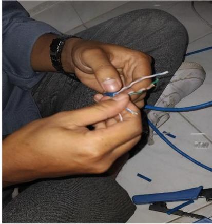
Gambar 3. 4 Perakitan Kabel Jaringan Untuk CCTV
