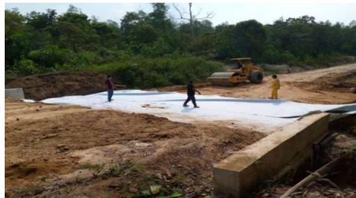
**Gambar 3.12** Pekerjaan Pemasangan Geotextile
