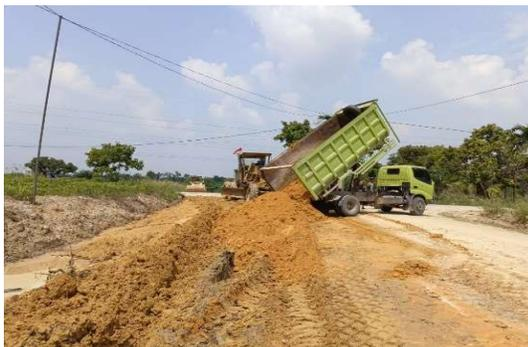
**Gambar 3.8** Pekerjaan Penghamparan Tanah Timbunan
