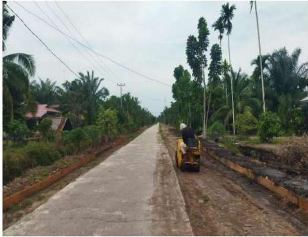
Melakukan pekerjaan pemadatan dan meratakan pada tanah dasar ini agar tanah tersebut lebih padat lagi dan lebih rata lagi sebelum melakukan timbunan, alat yang di gunakan yaitu *Baby Roller*.
