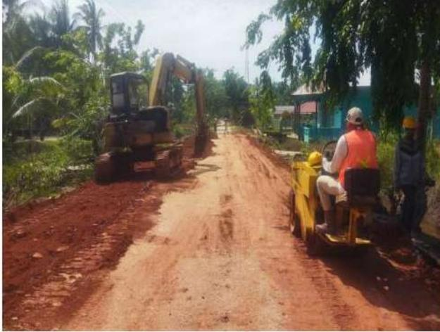
Pekerjaan penghambaran tanah timbunan pilihan dengan alat *excavator* dan pemadatan tanah dengan *Baby Roller*.
