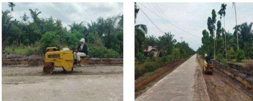
**Gambar 3. 21 Pekerjaan Pemadatan Tanah Timbunan Asli**
