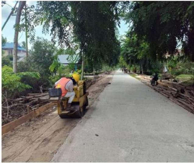
Pekerjaan Pemasangan Dilakukan dengan menggunakan Alat Berat *Baby Roller*. Agar struktur tanah menjadi padat dan rata.
