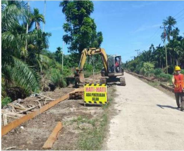
Melakukan pekerjaan penusukan kayu pada papan Mal dengan menggunakan alat berat *Excavator*, agar kayu tersebut dapat masuk ke dalam tanah untuk menahan pada papan Mal tersebut. Pemasangan mulai dari STA 0+000 – 0+200
