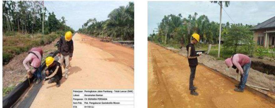
**Gambar 3. 26 Pekerjaan Pengukuran Geotextile Yang Berlebih**
