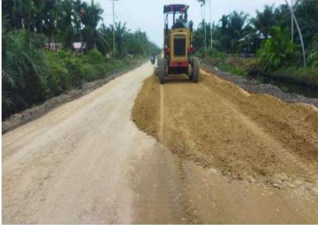
Pekerjaan penghampanan base B dengan Alat Berat *greder* dan pemadatan dengan mesin *vibro Roller*
