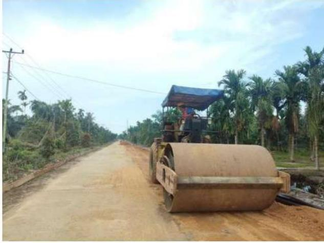
Pekerjaan pemadatan dan penghamparan tanah timbunan pilihan dengan alat *excavator* dan *vibro Roller*
