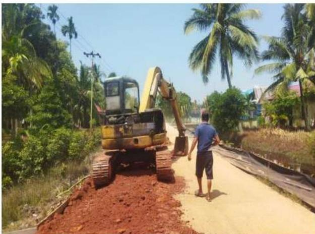
Pekerjaan penghamparan tanah timbunan pilihan dengan menggunakan alat berat *excavator* disebelah kiri jalan.
