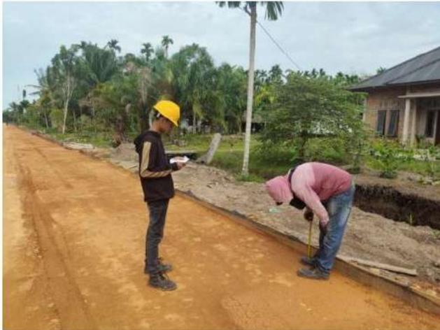
Melakukan Pengukuran Volume Ketinggian tanah Timbunan Pilihan ,ini bertujuan untuk mengetahui berapa batas tinggi tanah timbunan pada papan Mal. menentukan kebutuhan Volume tanah yang digunakan dan anggaran biaya yang dibutuhkan.
