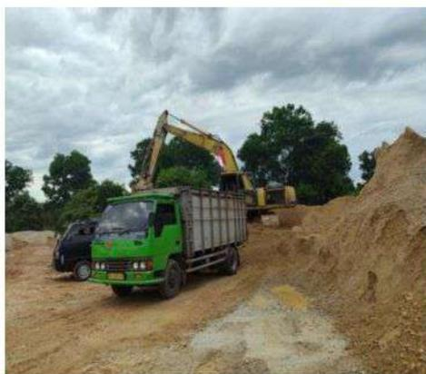
**Gambar 3. 14 Lapis Pondasi agregat kelas Base B**
