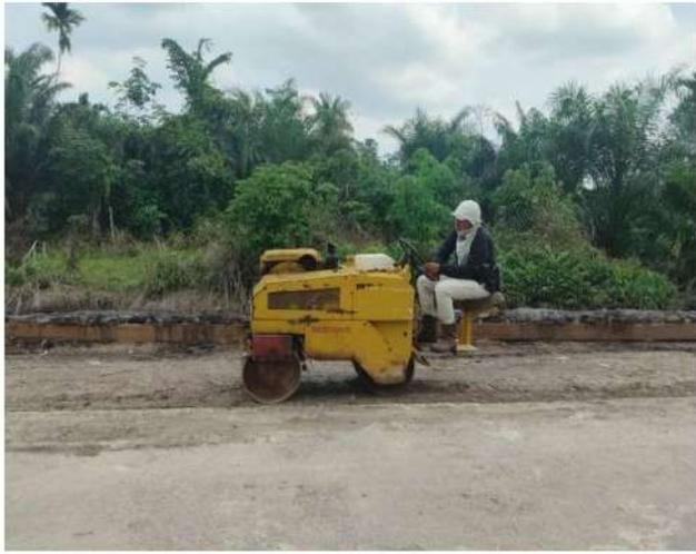
Melakukan pekerjaan pemadatan dengan Alat Berat *Baby Roller* , pekerjaan dilakukan agar struktur Tanah Asli menjadi padat.
