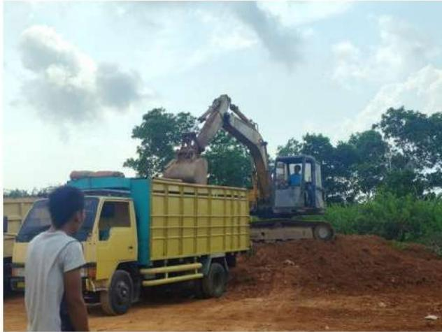
Proses pengambilan bahan tanah dasar di *batching plant* menggunakan alat excavator ,dan menuju ke lokasi pekerjaan.
