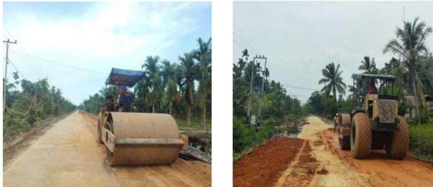
**Gambar 3. 25 Pekerjaan Pemadatan Tanah Timbunan Pilihan**
