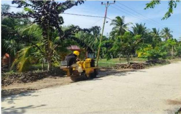
Melakukan pekerjaan pemadatan dan meratakan tanah dasar ini agar tanah tersebut lebih padat lagi dan lebih rata lagi sebelum melakukan timbunan, alat yang di gunakan yaitu *Baby Roller* dan *Vibro Roller*.
