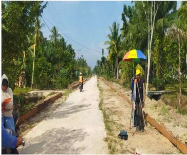
Pekerjaan dilakukan mulai dari STA 0+000 Dengan Bantuan anak – anak Magang dari SMK. Setelah mendapatkan ketinggian Tanah Timbunan Pilihan Maka di beritanda Dengan Cat semprot agar tidak hilang.
