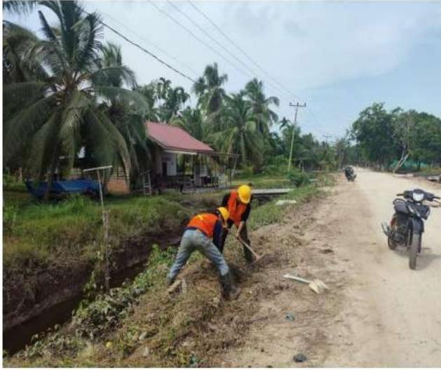
Pekerjaan pembersihan lahan di lakukan di area bahu jalan yang mengganggu saat akan di pasang dinding mall, menggunakan alat sekop dan cangkul. Dilakukan secara manual menggunakan tenaga manusia.
