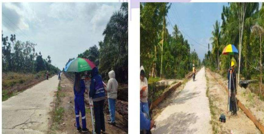
**Gambar 3. 23 Pekerjaan Survei Volume Tanah Timbunan**
