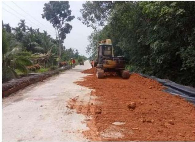
Pekerjaan meratakan dan memadatkan tanah dengan menggunakan Alat Berat *Excavator* dan *Vibro Roller* pada STA 0+000 s/d 0+175.
