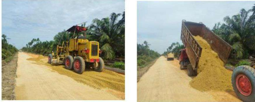
**Gambar 3. 29 Pekerjaan Agregat Kelas B**
