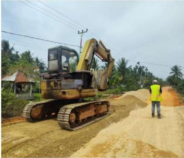
Pekerjaan penghambaran base B dengan *excavator* dan pepadatan dengan mesin *vibro Roller*
