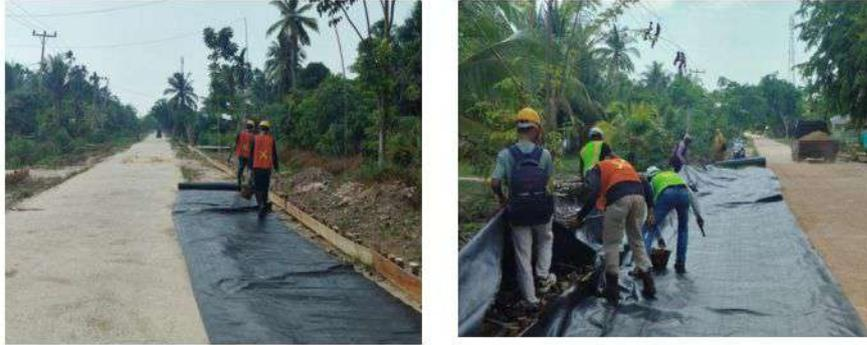
Gambar 3. 22 Pekerjaan Pemasangan Geotextile merk Woven
