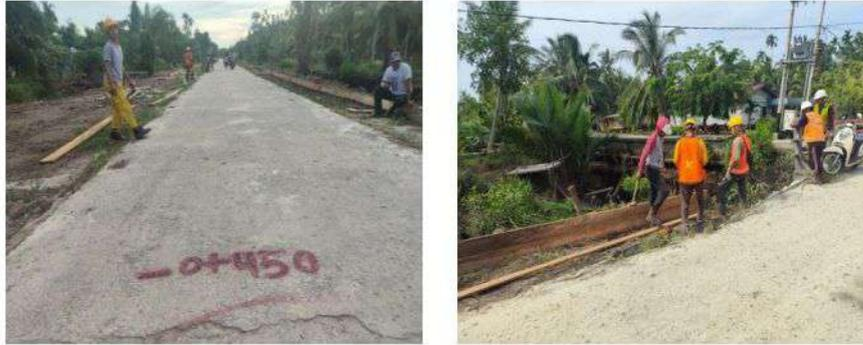
**Gambar 3. 20 Pekerjaan Pemasangan Dinding Turap Mall**
