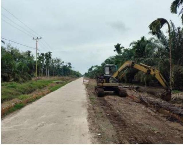
Melakukan pekerjaan penusukan kayu pada papan Mal dengan menggunakan alat berat *Excavator* agar kayu tersebut dapat masuk ke dalam tanah untuk menahan pada papan Mal tersebut. Pemasangan mulai dari STA 0+000 – 0+200
