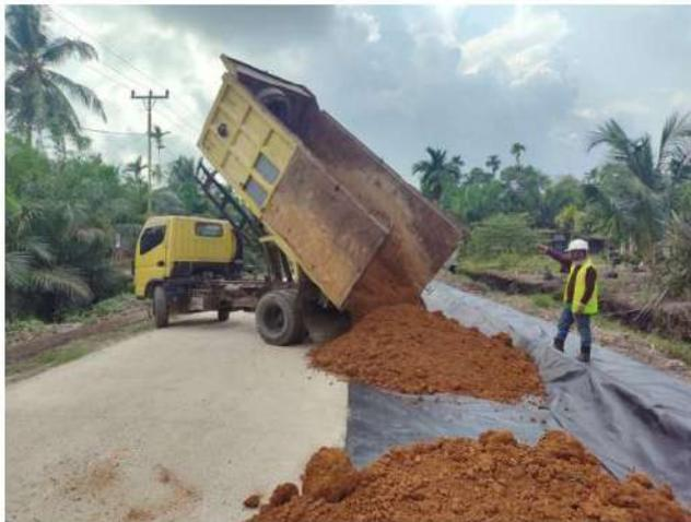
Proses mendatangkan bahan tanah timbunan pilihan pada sebelah kanan jalan dari batching plant
