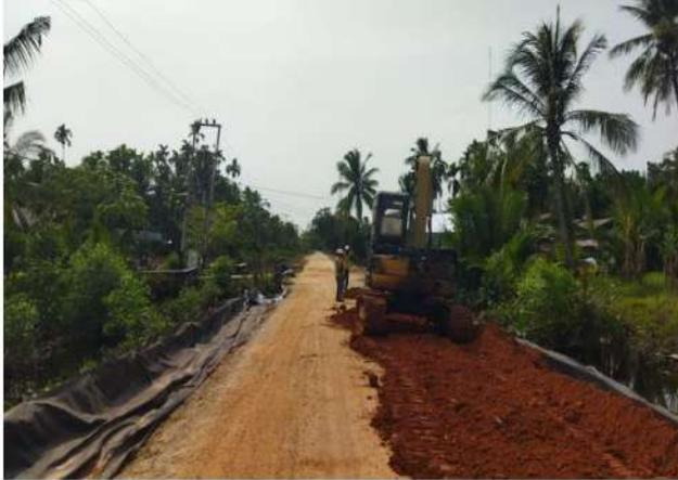
Pekerjaan meratakan tanah timbunan pilihan dengan menggunakan alat berat *Excavator* dan *vibro Roller* untuk pemadatan dan penghamparan
