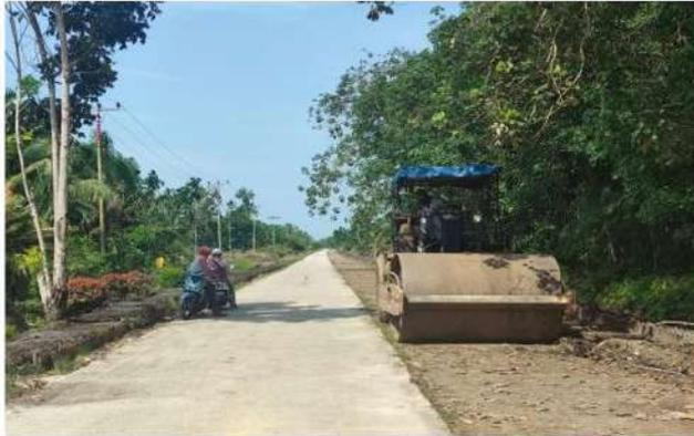
Melakukan pekerjaan pemadatan dan meratakan pada tanah dasar ini agar tanah tersebut lebih padat lagi dan lebih rata lagi sebelum melakukan timbunan, alat yang di gunakan yaitu *Baby Roller* dan *Vibro Roller*.
