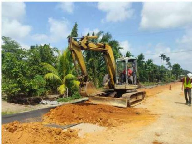
Pekerjaan penghamparan tanah timbunan pilihan dengan alat *Excavator*.
