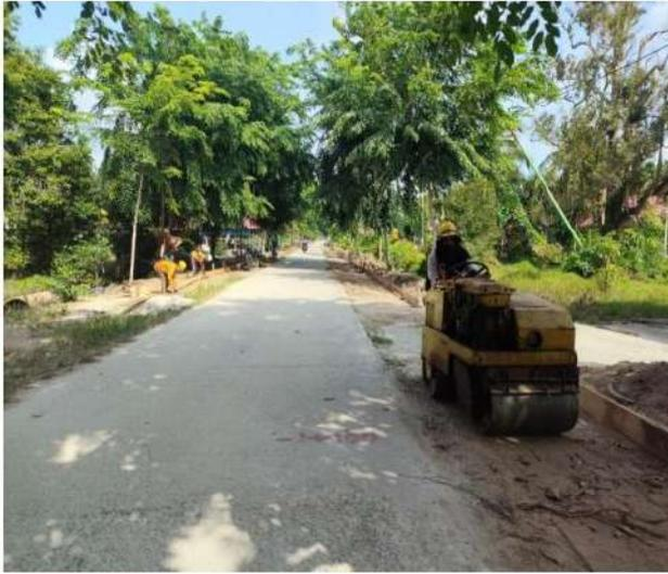
Pekerjaan pemadatan tanah asli di sebelah kiri jalan ,sebelum penimbunan tanah pilihan agar tanah struktur tanah menjadi padat.
