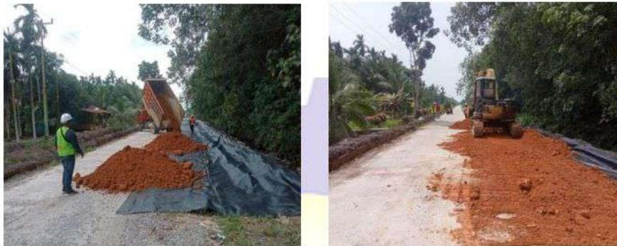
**Gambar 3. 24 Pekerjaan Timbunan Tanah Pilihan**
