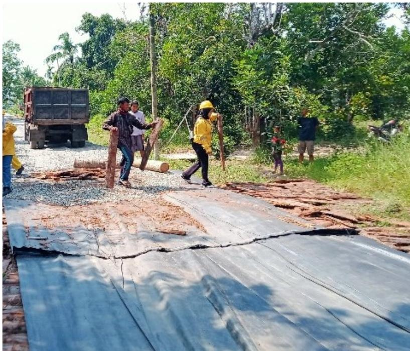
Gambar 3. 2 Pemasangan Geotextile
