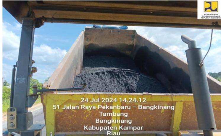
**Gambar 3.11 Pekerjaan Penghamparan AC-WC Menggunakan Finisher Asphalt**
