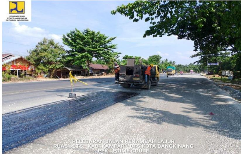
**Gambar 3.8 Penyemprotan Prime Coat**
