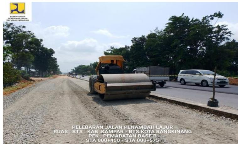
**Gambar 3.3 Pekerjaan pemadatan menggunakan vibro roller**
