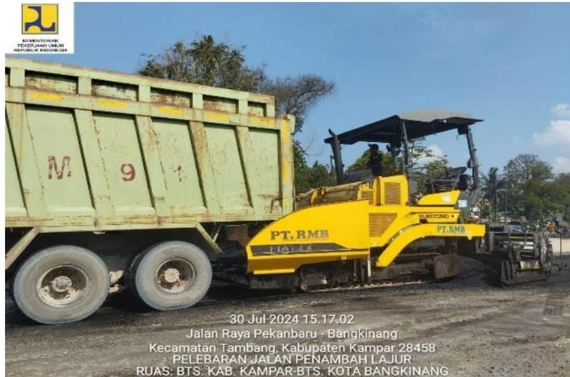
**Gambar 3.9 Pekerjaan Penghamparan Menggunakan Finisher Aspal**
