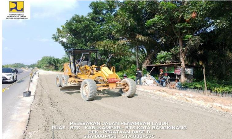
**Gambar 3.2 Pekerjaan perataan menggunakan motor grader**
