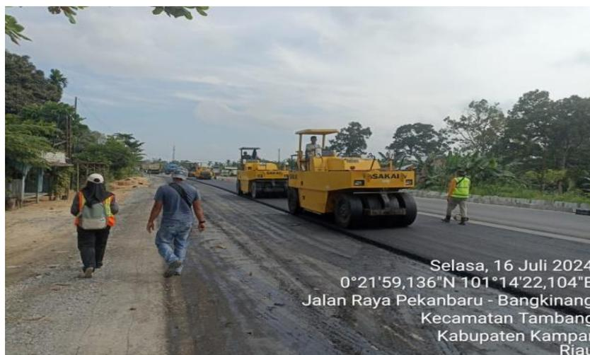
**Gambar 3.10 Pekerjaan Pemadatan Menggunakan Tandem Roller**
