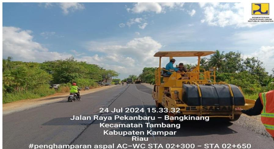
Gambar 3.12 Pekerjaan Pemadatan Menggunakan Tandem Roller
