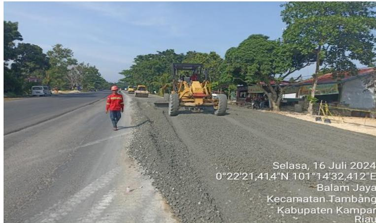
**Gambar 3.5 Pekerjaan perataan menggunakan motor grader**
