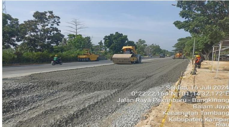
**Gambar 3.6 Pekerjaan Pematatan Menggunakan Vibro Roller**
