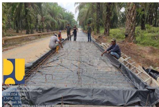
Gambar 3. 24 Pemasangan Wiremesh M8 Sumber : Dokumentasi Lapangan
