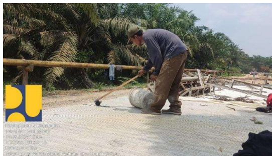
Gambar 3. 33 Penuangan Joint Sealent Sumber : Dokumentasi Lapangan
