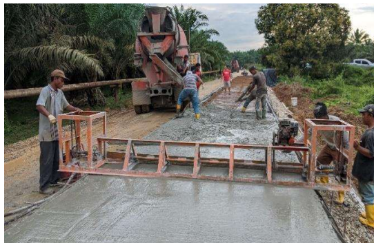
Gambar 3. 28 Proses Pemadatan Beton Sumber : Dokumentasi Lapangan
