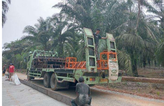
Gambar 3. 11 Mobilisasi Material Sumber : Dokumentasi Lapangan
