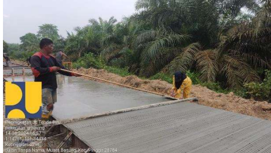
Gambar 3. 29 Pembuatan Tekstur (Grooving) Sumber : Dokumentasi Lapangan
