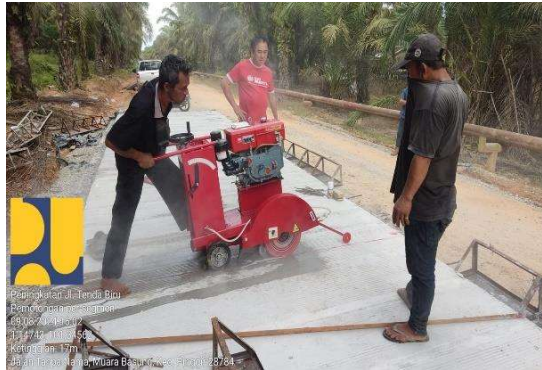
Gambar 3. 32 Pemotongan Beton (Cutting) Sumber : Dokumentasi Lapangan
