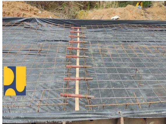
Gambar 4. 3 Pemasangan Besi Dowel Sumber : Dokumentasi Lapangan
