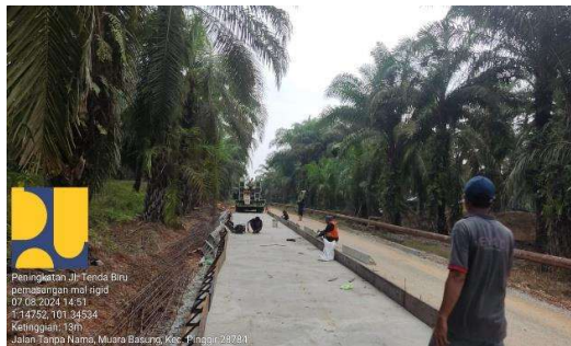
Gambar 3. 19 Pemasangan Bekisting Rigid Sumber : Dokumentasi Lapangan
