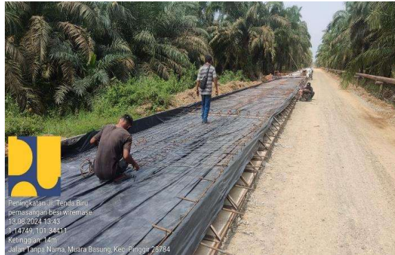
Gambar 4. 4 Pemasangan Besi Wiremesh Sumber : Dokumentasi Lapangan
