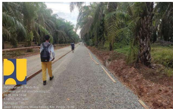
Gambar 3. 18 Pemasangan Bekisting Lean Concrete Sumber : Dokumentasi Lapangan
