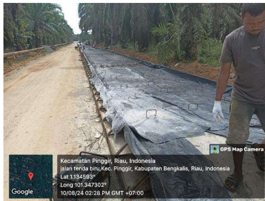
Gambar 3. 23 Pemasangan Dudukan Sumber : Dokumentasi Lapangan
