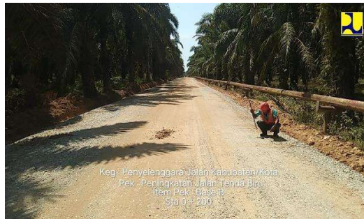
Gambar 3. 15 Penggalan base B Sumber : Dokumentasi Lapangan
