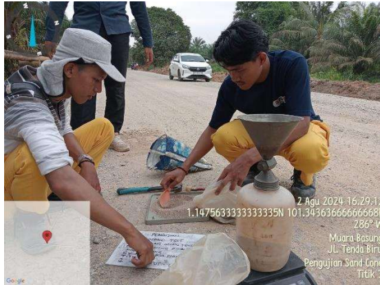
Gambar 3. 17 Pengujian sandcone Sumber : Dokumentasi Lapangan
