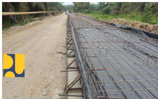
Gambar 3. 26 Pemasangan Tie Bars Sumber : Dokumentasi Lapangan
