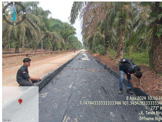
Gambar 3. 21 Pemasangan Plastik Alas Sumber : Dokumentasi Lapangan
