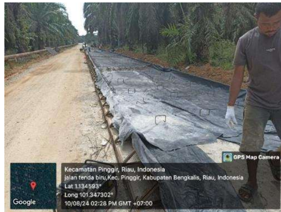
Gambar 4. 2 Pemasangan Dudukan Wiremesh Sumber : Dokumentasi Lapangan
