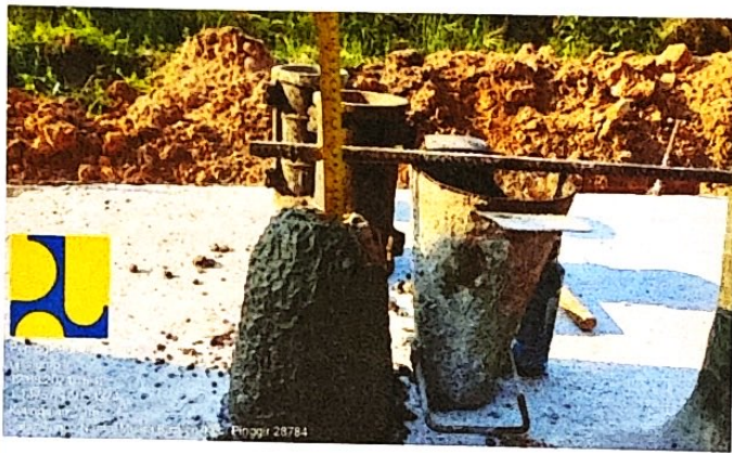
Uji slump dilakukan untuk mengetahui nilai kekentalan campuran beton
