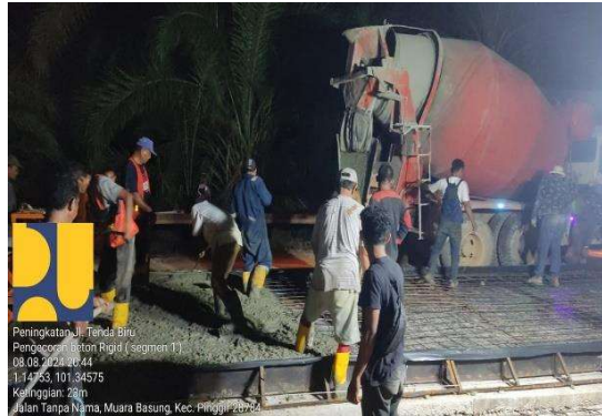
Gambar 3. 27 Proses Pengecoran Beton Sumber : Dokumentasi Lapangan
