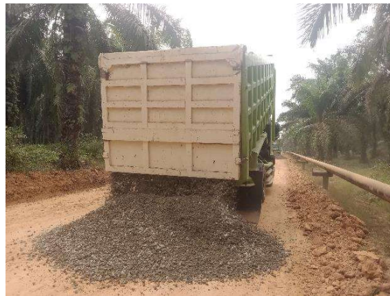
Gambar 3. 12 Penghamparan Base B Sumber : Dokumentasi Lapangan
