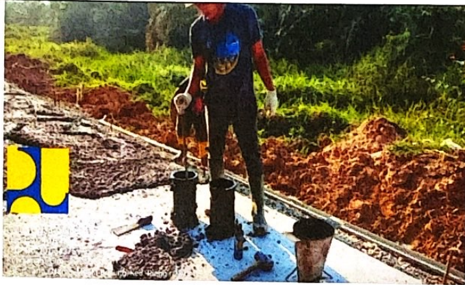
Pengambilan sampel silinder lc
