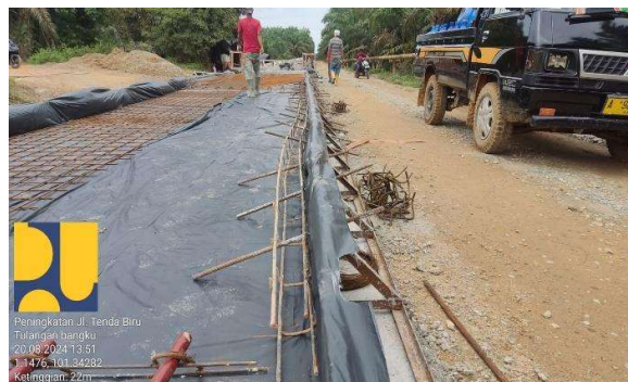
Gambar 4. 1 Pemasangan Tulangan Bangku Sumber : Dokumentasi Lapangan
