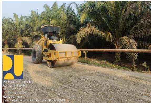
Gambar 3. 14 Pemadatan Base B Sumber : Dokumentasi Lapangan
