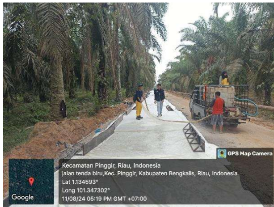
Gambar 3. 31 Proses Penyiraman Beton Rigid Sumber : Dokumentasi Lapangan
