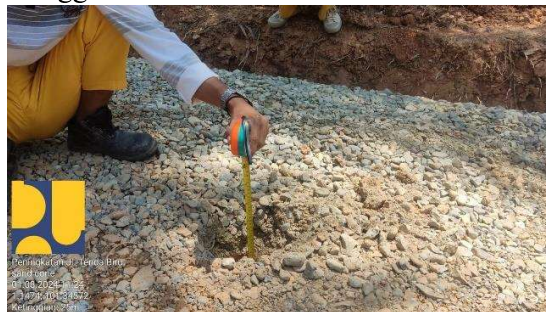
Gambar 3. 16 Pengukuran kedalaman Base B Sumber : Dokumentasi Lapangan
