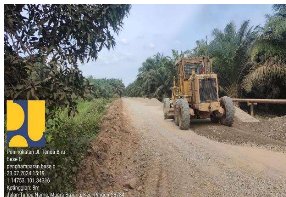
Gambar 3. 13 Perataan Base B Menggunakan Motor Grader Sumber : Dokumentasi Lapangan
