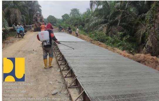
Gambar 3. 30 Penyemprotan Curing Compound Sumber : Dokumentasi Lapangan
