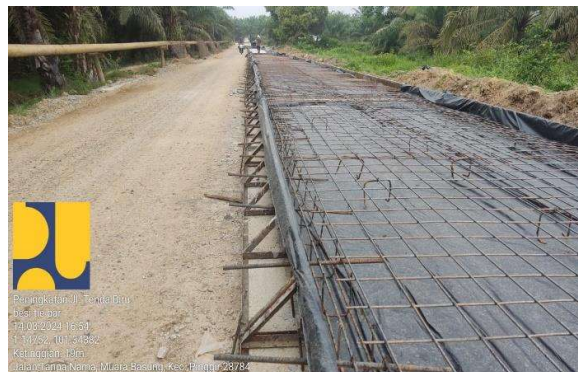
Gambar 4. 5 Pemasangan Besi Tie Bars Sumber : Dokumentasi Lapangan
