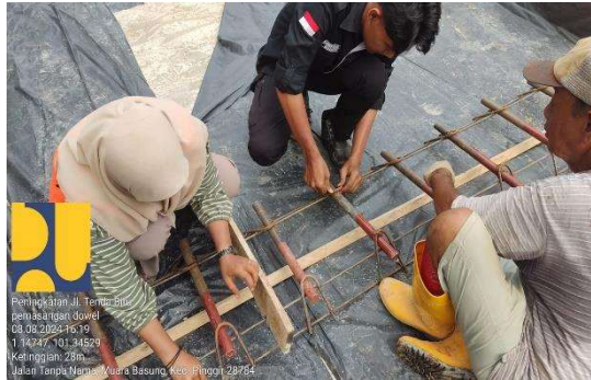
Gambar 3. 25 Pemasangan Besi Dowel Sumber : Dokumentasi Lapangan
