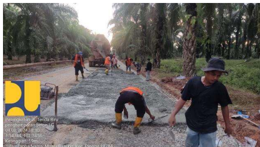
Gambar 3. 20 Proses Pengecoran Lean Concrete Sumber : Dokumentasi Lapangan
