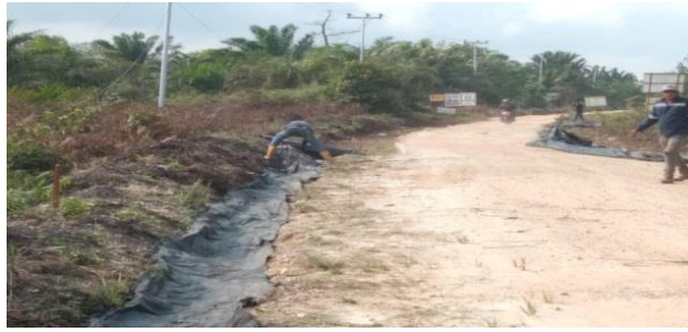
Gambar 3. 6 Pembentangan Geotextile
