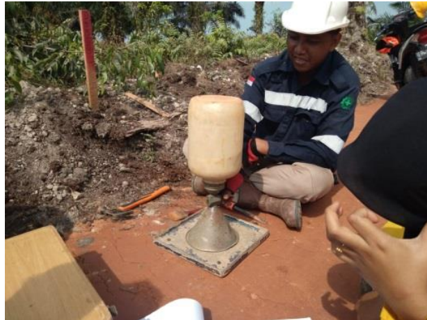
Gambar 3. 10 Uji Sand Cone Sumber : Dokumentasi lapangan 2024
