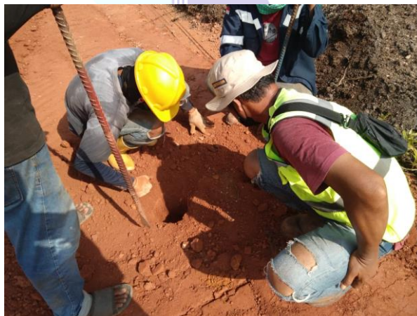
Gambar 3. 9 Pekerjaan Core Tanah Timbunan
