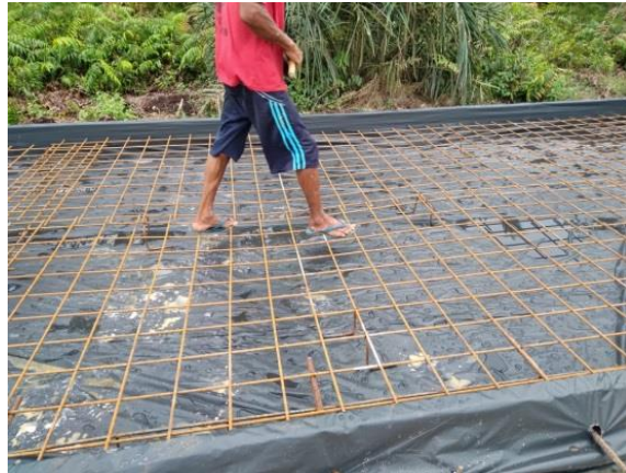
Gambar 3. 20 Pemasangan Tulangan Sumber : Dokumentasi lapangan 2024
