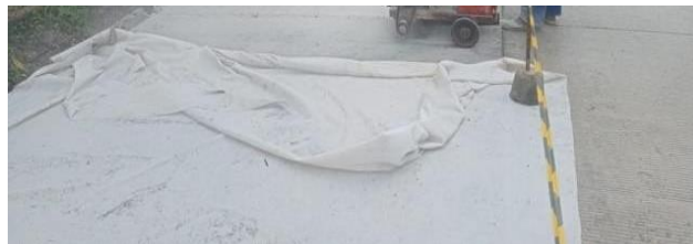
Gambar 4. 8 Membran Curing sumber: pekerjaan dilapangan
