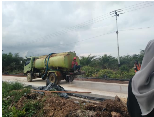
Gambar 4. 7 Proses Curing sumber: pekerjaan dilapangan
