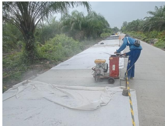
Gambar 3. 27 Pekerjaan Cutting
