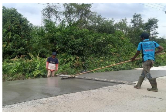
Gambar 3. 24 Pekerjaan Grooving
