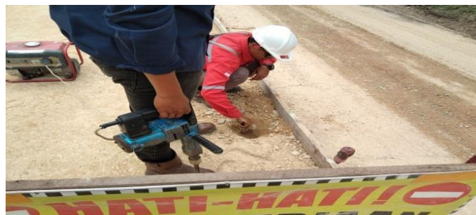
Gambar 3. 13 Pekerjaan Core Base Sumber : Dokumentasi lapangan 2024
