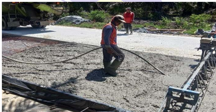
Gambar 3. 22 Pemadatan Beton Menggunakan Vibrator Sumber : Dokumentasi lapangan 2024
