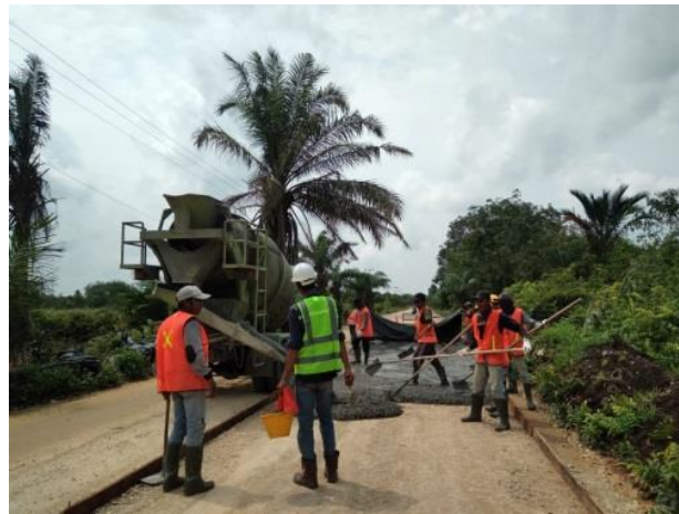
Gambar 3. 16 Pengecoran Lc Sumber : Dokumentasi lapangan 2024
