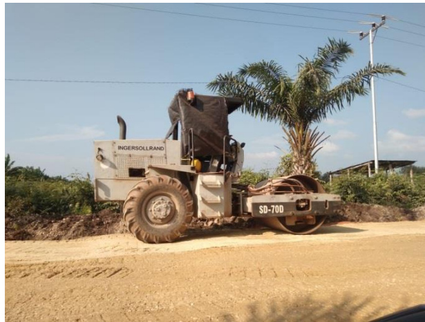
Gambar 3. 12 Pemadatan Base Sumber : Dokumentasi lapangan 2024
