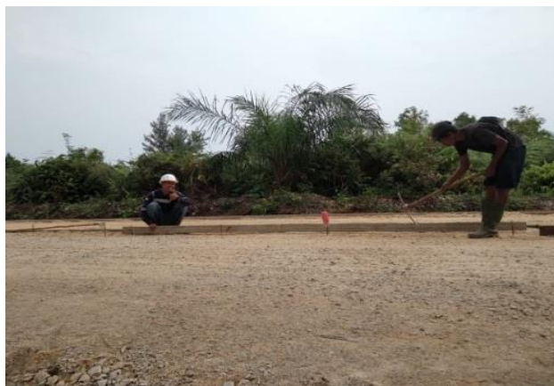
Gambar 3. 15 Pemasangan Mal LC Sumber : Dokumentasi lapangan 2024
