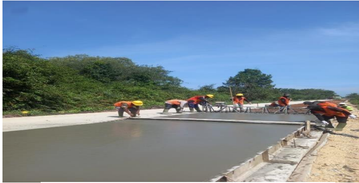
Gambar 3. 21 Pengecoran Rigid Sumber : Dokumentasi lapangan 2024
