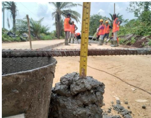
Gambar 3. 17 Uji Slump Lc Sumber : Dokumentasi lapangan 2024
