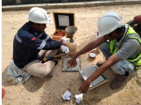
Gambar 3. 14 Pengujian Sand Cone Sumber : Dokumentasi lapangan 2024
