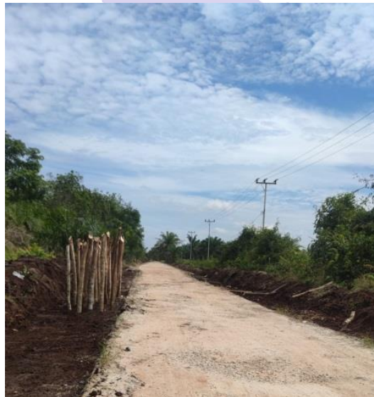
Gambar 3. 5 Pemancangan Kayu Cerucuk
