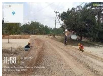
Gambar 4.1 pengukuran lebar base B
