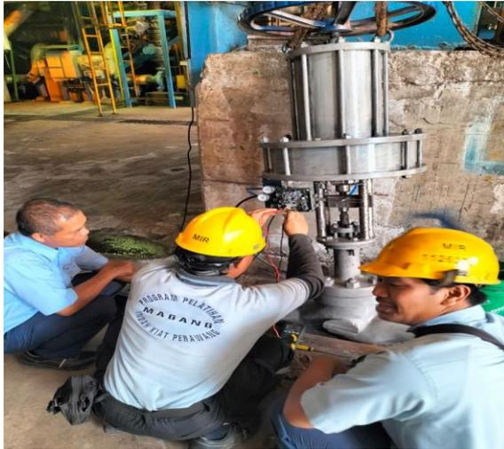
Gambar 2. 8 melakukan service dan kalibrasi positioner kemudian repair tubing supply SAF bocor.
