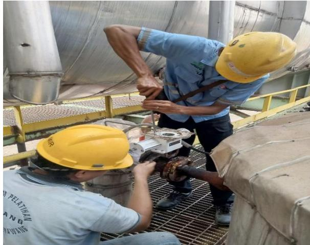
Gambar 2. 5 ganti Mounting press dan cat ulang transmiter.
