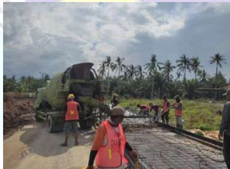
Gambar 3.8 pengecoran Rigid
