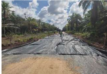
Gambar 3.14 Pemasangan Geotek
