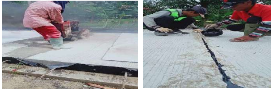
Gambar 3.9 pemotongan rigid sumber dokumentasi lapangan 2024
