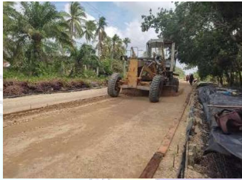
Gambar 3.2 Penghamparan Menggunakan Motor Grader
