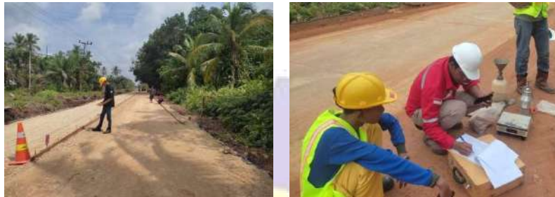
Gambar 3.5 pemasangan mal lc dan uji sandcone
