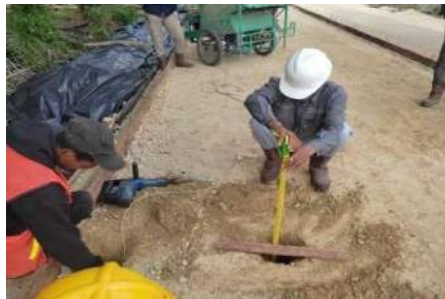
Gambar 3.4 core base dan pengukuran base B
