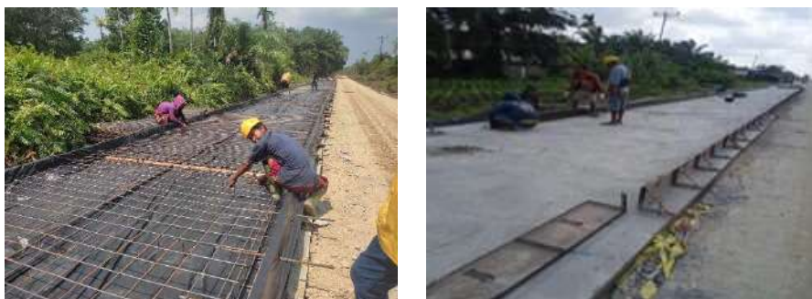
Gambar 3.7 Pekerjaan pemasangan mal rigid dan tulangan
