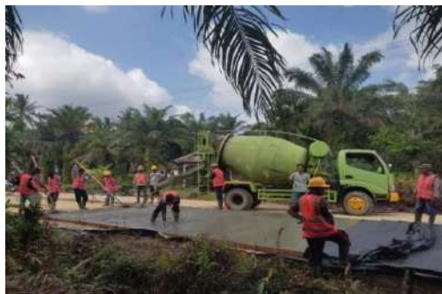
Gambar 3.6 pengecoran lc
