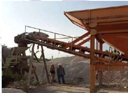
Gambar 3.3 Trial Mix untuk Lc dan bahu jalan.
