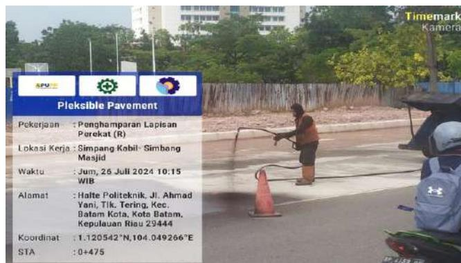
Gambar 4. 3 Pekerjaan Lapis Perekat menggunakan Hand Sprayer
