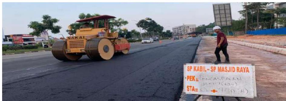
Gambar 4.8. Pemadatan Aspal dengan *Three wheel roller*
