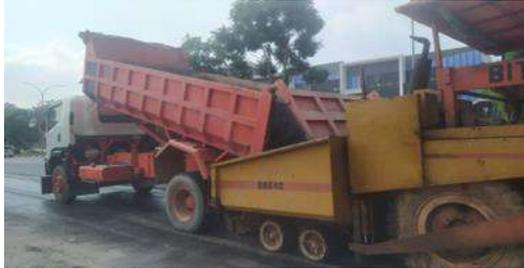
Gambar 4. 4 Penuangan Campuran Beraspal Kebak Mekanis
