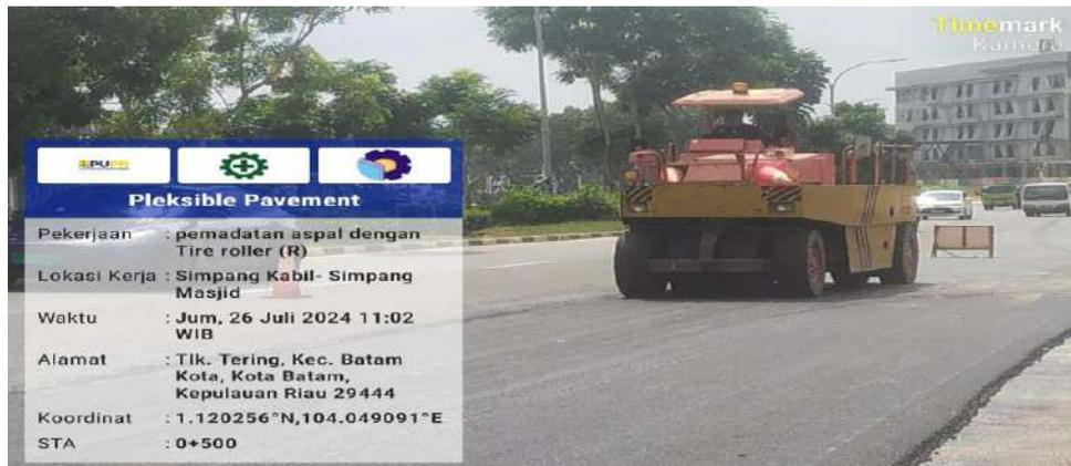
Gambar 4.9. Pematatan Aspal dengan *Tired Roller*
