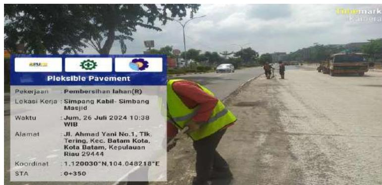
Gambar 4. 1 Pengerukan Kotoran Menggunakan Sekop
