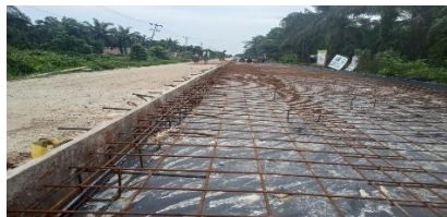
Gambar 3. 22 Penyusunan tulangan (Sumber) : Dokumen Lapangan, 2024
