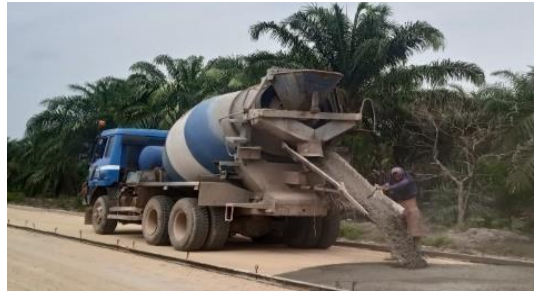
Gambar 3. 21 pengecoran LC (Sumber) : Dokumen Lapangan, 2024
