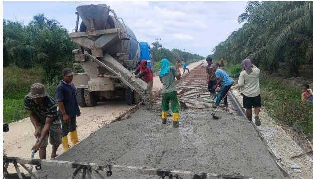
Gambar 4. 7 pekerjaan pengecoran beton fc 30 (k-300) (Sumber) dokumentasi lapangan 2024
