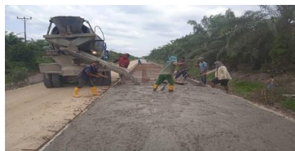
Gambar 3. 23 pengecoran beton (Sumber) : Dokumen Lapangan, 2024
