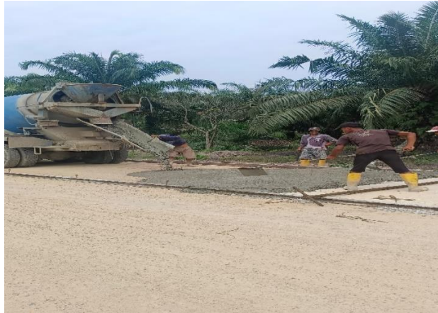
Gambar 4. 4 perataan permukaan beton lc 10 (sumber) dokumentasi lapangan , 2024
