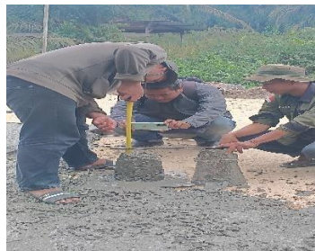
Gambar 3. 24 slump test (Sumber) : Dokumen Lapangan, 2024
