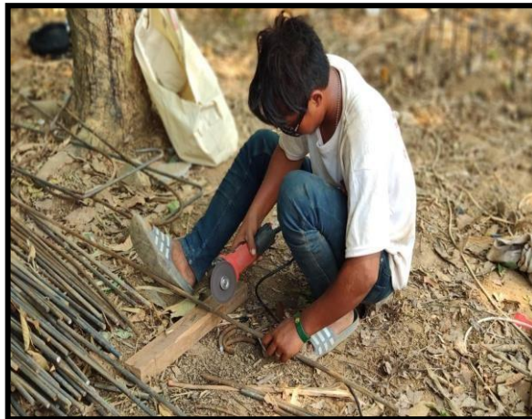
Gambar 4. 5 pemotongan baja tulangan (sumber) dokumentasi lapangan , 2024
