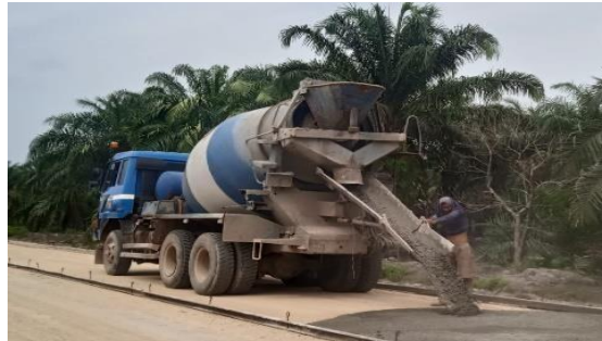
Gambar 3. 6 Mobil mixer (Sumber) : Dokumentasi Lapangan,
