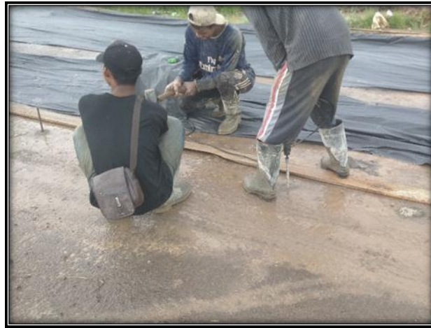
Gambar 4. 2 pemasangan bekisting lantai kerja (sumber) dokumentasi lapangan
