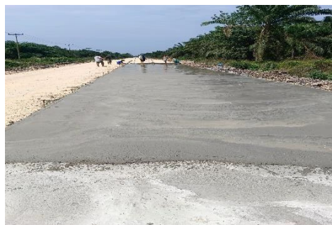
Gambar 3. 16 Beton K-300 (sumber) dokumentasi lapangan
