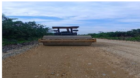
Gambar 3. 20 perataan dan pemadatan agregat b (Sumber) : Dokumen Lapangan, 2024
