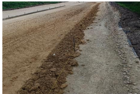
Gambar 3. 15 lapisan pondasi agregat kelas B (Sumber) : Dokumentasi Lapangan, 2024
