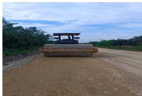
Gambar 3. 18 Pemadatan material (sumber) dokumentasi lapangan, 2024
