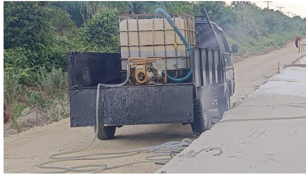
Gambar 4. 1 proses penyiraman air (sumber) dokumentasi lapangan , 2024
