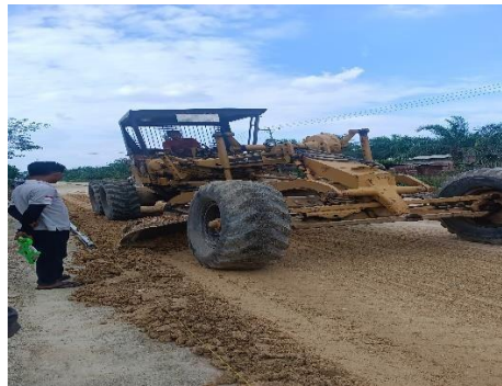
Gambar 3. 17 Pekerjaan penghamparan base B (Sumber) : Dokumentasi lapangan, 2024
