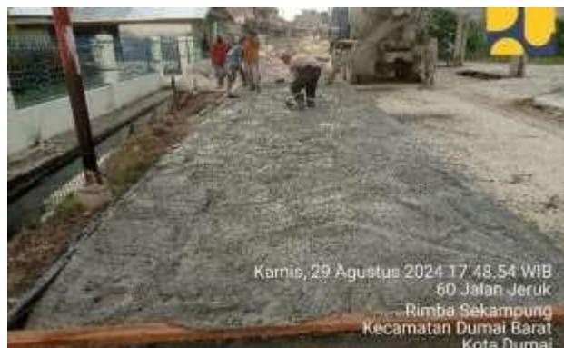
*Gambar 3. 29 Pengecoran Beton
