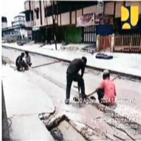
Pemasangan mall /bekisting pada bahu jalan bagian kiri
