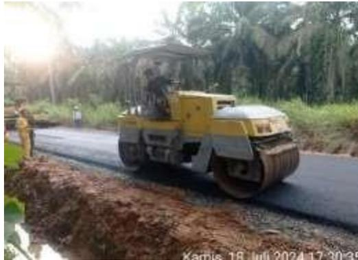
*Gambar 3. 11 Pekerjaan Pemadatan Menggunakan Tandem Roller
