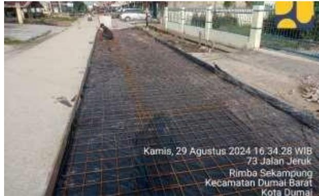
*Gambar 3. 27 Pemasangan Wiremase
