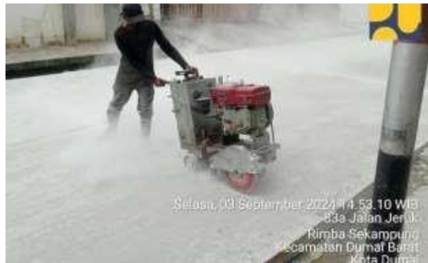
*Gambar 3. 32 Pekerjaan Cutting
