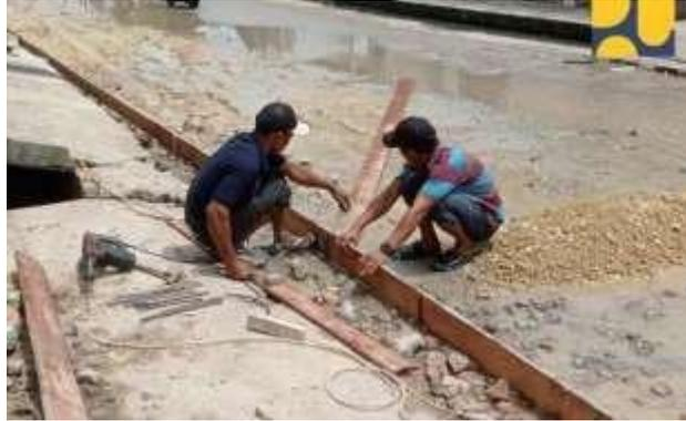
*Gambar 3. 25 Pemasangan Bekisting
