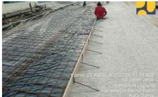
*Gambar 3. 28 Pemasangan Tiebar
