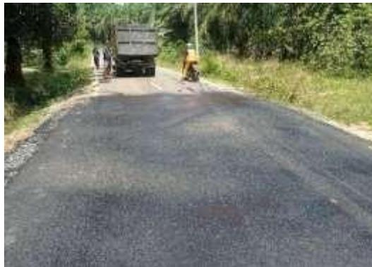
Gambar 3. 7 Pekerjaan Penyiraman Tcak Coat
