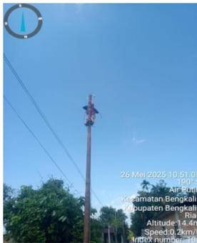
Gambar 3. 53 Menggantikan dan menyambungkan kabel SR ke pelanggan
