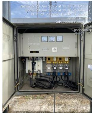
Gambar 4. 2 Membuka pintu gardu untuk pengukuran tegangan dan beban trafo
