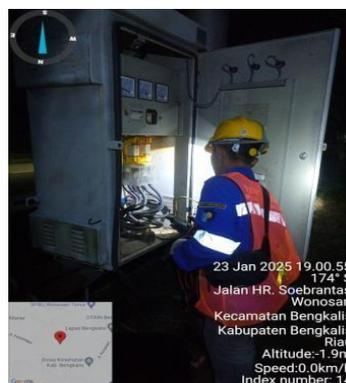
Gambar 3. 10 Pengukuran tegangan dan arus beban puncak/malam penyulang HR.Soebrantas
