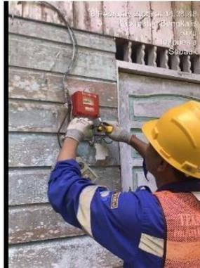
Gambar 3. 16 Penggantian kwh dummy sementara
