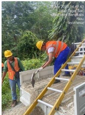
Gambar 3. 39 Pengecoran manset
