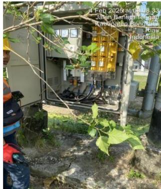
Gambar 3. 14 Pengukuran tegangan dan arus beban puncak/malam penyulang banten
