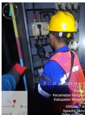
Gambar 3. 8 Pengukuran tegangan dan arus beban puncak/malam penyulang banten dan solo
