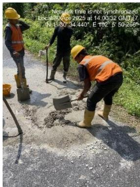
Gambar 3. 43 Pengecoran manset
