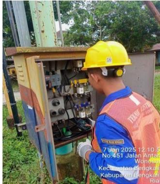
Gambar 3. 5 Pengukuran tegangan dan arus beban siang penyulang HR. Soebrantas
