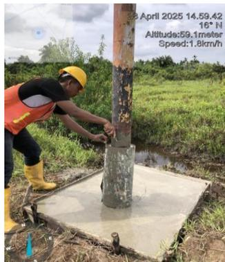
Gambar 3. 35 Pengecoran pada manset
