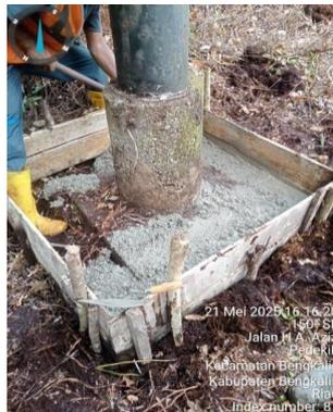
Gambar 3. 51 Pengecoran pada tiang
