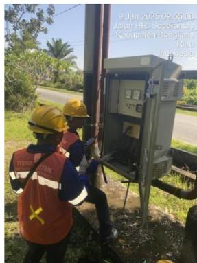
Gambar 3. 6 Pengukuran tegangan dan arus beban siang penyulang HR. Soebrantas
