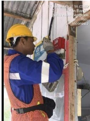
Gambar 3. 20 Penggantian kwh dummy sementara
