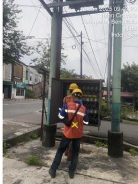
Gambar 3. 7 Pengukuran tegangan dan arus beban siang penyulang VIP
