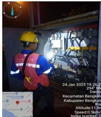
Gambar 3. 11 Pengukuran tegangan dan arus beban puncak/malam penyulang solo
