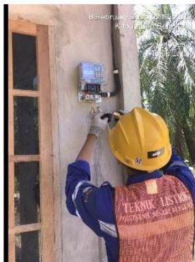
Gambar 3. 17 Perbaikan kabel aspan
