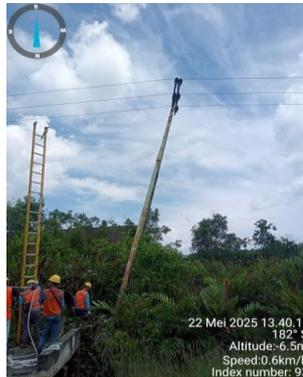
Gambar 3. 52 Memperbaiki tiang TM yang miring
