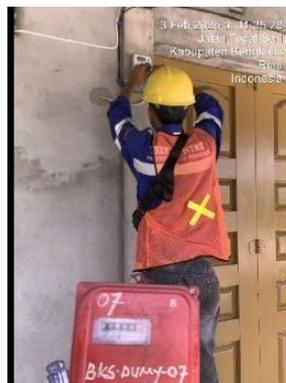
Gambar 3. 13 penggantian kwh dummy sementara
