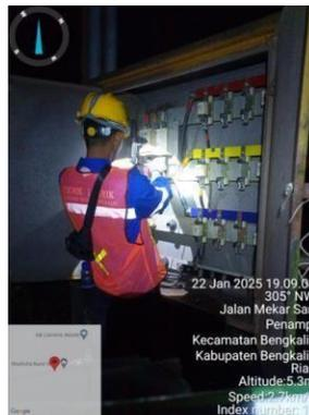
Gambar 3. 9 Pengukuran tegangan dan arus beban puncak/malam penyulang Sei Alam
