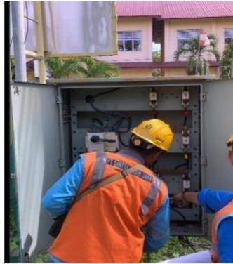
Gambar 3. 3 Pengukuran tegangan dan arus beban siang penyulang solo
