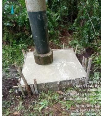
Gambar 3. 46 Pengecoran sebuah manset
