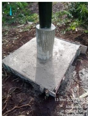
Gambar 3. 49 Pengecoran sebuah manset
