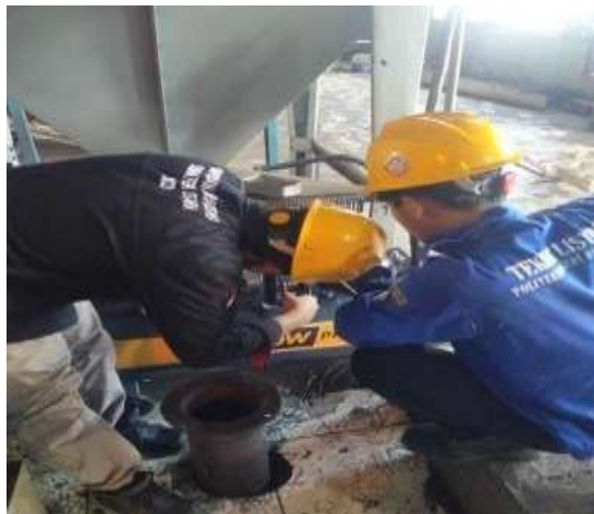
Gambar 3. 68 penggantian compressor
