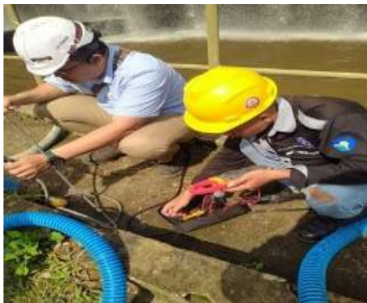
Gambar 3. 60 pemasangan satpam WTP
