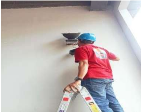
Gambar 3. 40 izat penggantian lampu ruang safety center
