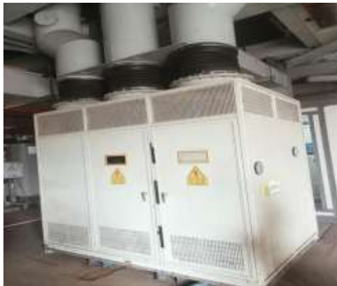
Gambar 4. 6 Trafo Exciter
