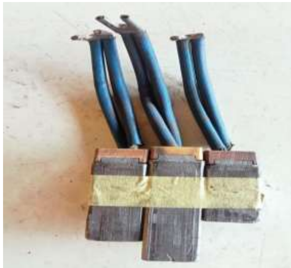
Gambar 4. 7 Carbon Brush pada Generator PLTU Tenayan
