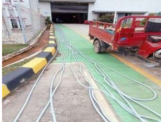
Gambar 3. 53 penarikan kabel UAT-Relay dan MT-RelaY
