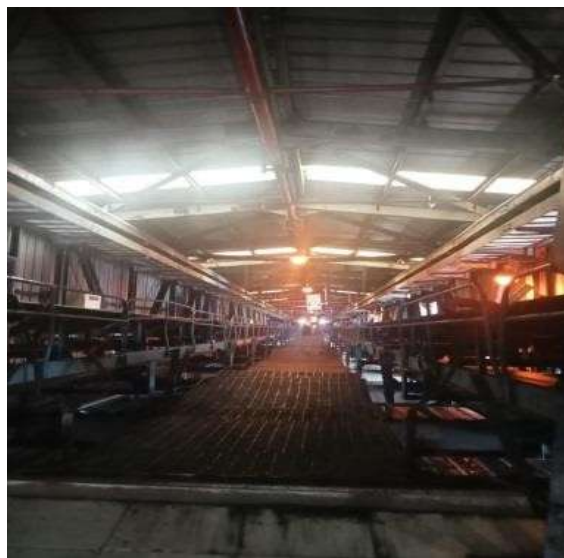
Gambar 3. 5 perbaikan line lampu C03
