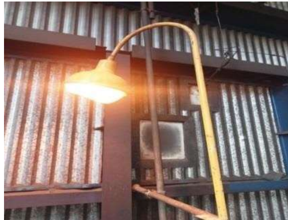
Gambar 3. 2 pengecekan lampu boiler
