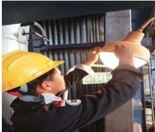
Gambar 3. 73 penggantian Lampu Son-T Menjadi Lampul ML
