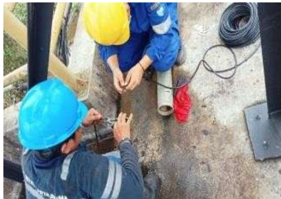
Gambar 3. 31 penarikan kabel power CCTV
