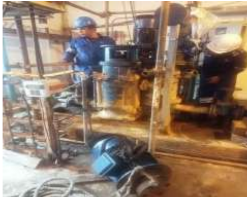
Gambar 3. 85 melakukan mobiltasy motor life water pump
