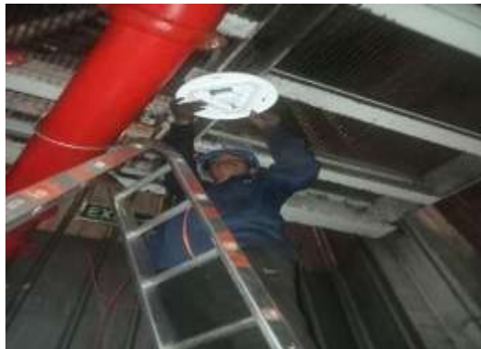
Gambar 3. 56 penggantian lampu tanggan C03
