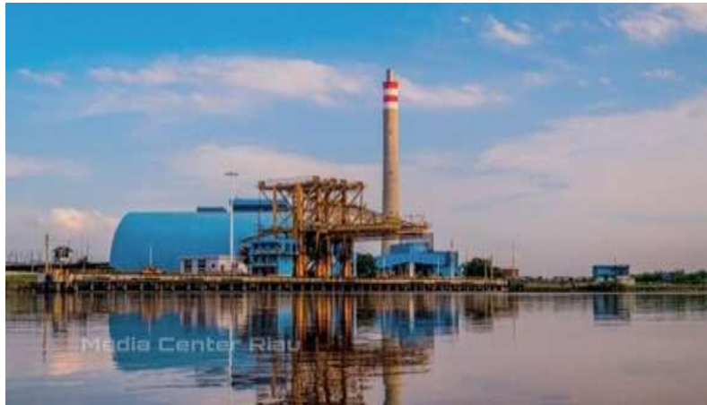
Gambar 2. 4 PLTU Tenayan Dari Belakang
