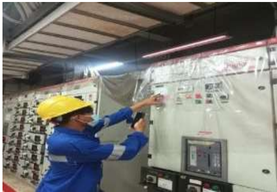
Gambar 3. 34 pendataan Panel MCC Unit 1 dan 2
