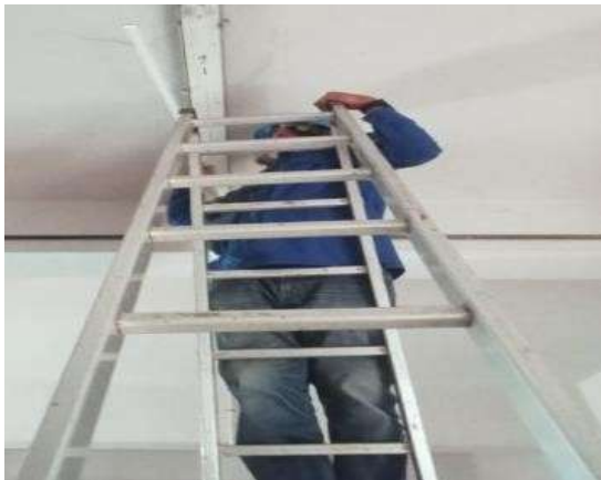
Gambar 3. 11 penggantian lampu ruang office kimia
