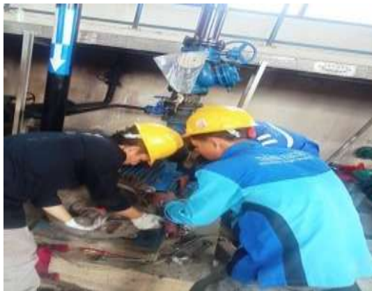
Gambar 3. 88 melakukan penggantian bearing motor reuse
