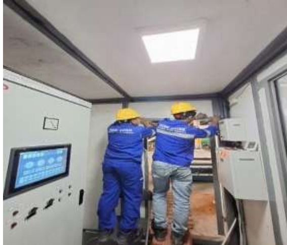
Gambar 3. 61 pemasangan smart door
