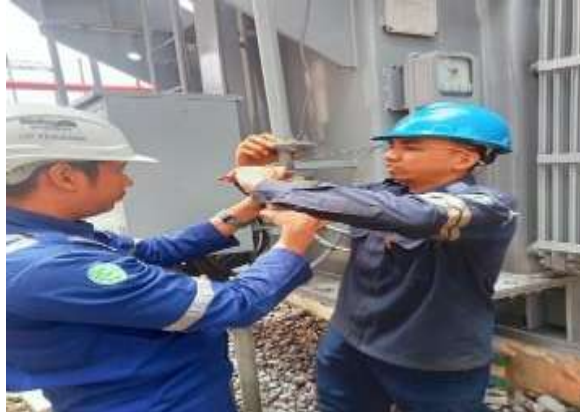
Gambar 3. 59 penggantian silica gel trafo step up
