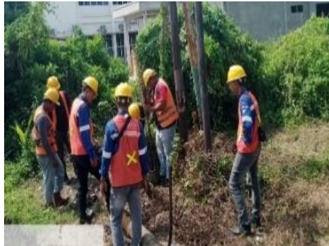
Gambar 3. 7 pemasangan tiang jtm.. (Sumber: Dokumentasi, 2025)
