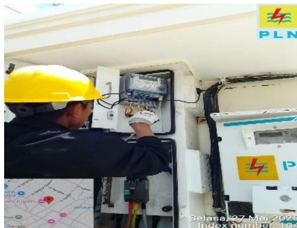
Gambar 3. 41 perbaikan fasa yang terbalik. (Sumber: Dokumentasi, 2025)
