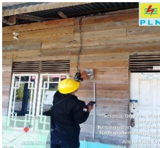
Gambar 3. 32 pemeriksaan Kwh meter pelanggan. (Sumber: Dokumentasi, 2025)
