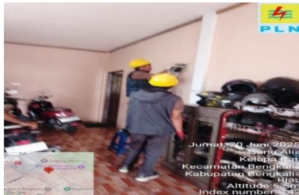
Gambar 3. 52 pemeriksaan Kwh meter pelanggan. (Sumber: Dokumentasi, 2025)
