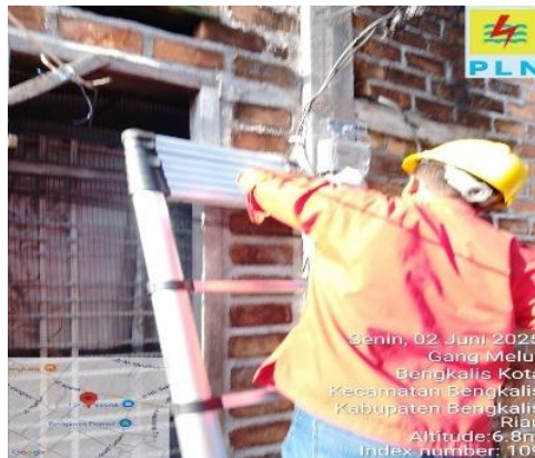
Gambar 3. 42 pergantian Kwh meter. (Sumber: Dokumentasi, 2025)
