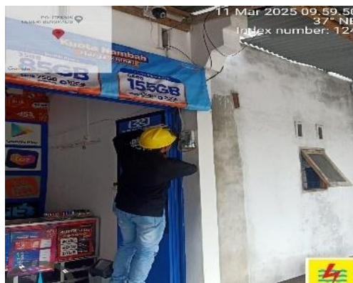
Gambar 3. 17 pemeriksaan Kwh meter pelanggan (Sumber: Dokumentasi, 2025)
