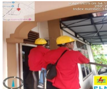
Gambar 3. 24 pemeriksaan Kwh meter pelanggan. (Sumber: Dokumentasi,2025)
