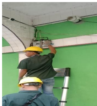
Gambar 3. 5 pengecekan Kwh meter pelanggan. (Sumber: Dokumentasi, 2025)
