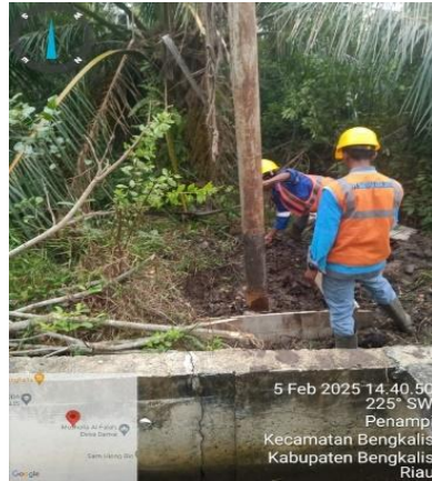
Gambar 3. 1 Pengecoran Tiang Jtm (Sumber: Dokumentasi 2025)
