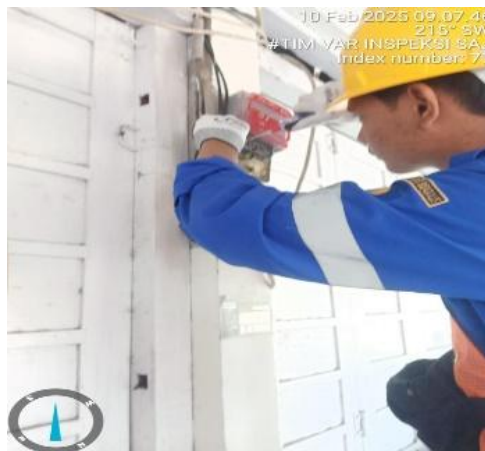
Gambar 3. 3 pergantian meter sementara (Sumber: Dokumentasi ,2025)
