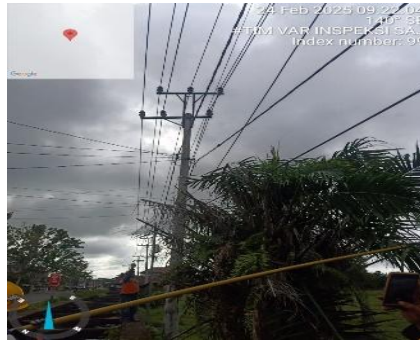
Gambar 3. 12 perbaikan gangguan jtm (Sumber: Dokumentasi, 2025)
