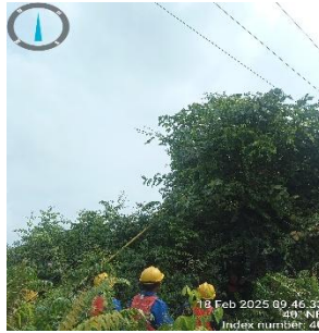
Gambar 3. 8 Pemangkasan pohon proteksi jtm. (Sumber: Dokumentasi,2025)
