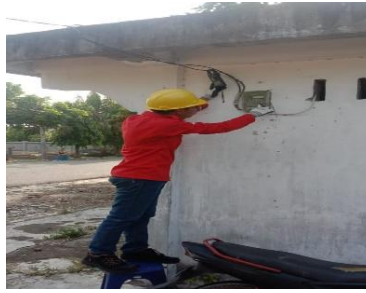
Gambar 3. 4 pengecekan Kwh meter pelanggan (Sumber: Dokumentasi, 2025)
