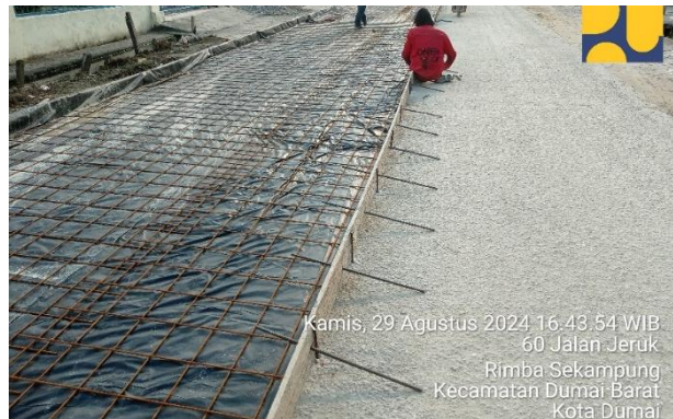
Gambar 3. 28 Pemasangan Tiebar (Sumber: Dokumentasi KP, 2024)
