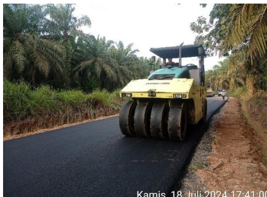
Gambar 3. 13 Pekerjaan Pemadatan Akhir
