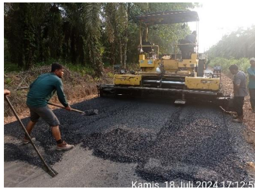
Gambar 3. 9 Pekerjaan Penghamparan Campuran Hotmix (Sumber: Dokumentasi KP, 2024)
