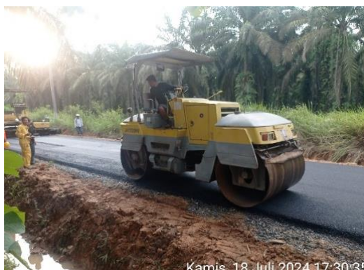
Gambar 3. 11 Pekerjaan Pemadatan Menggunakan Tandem Roller (Sumber: Dokumentasi KP, 2024)
