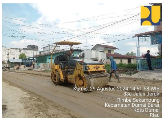
Gambar 3. 24 Pekerjaan Pemadatan (Sumber: Dokumentasi KP, 2024)
