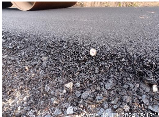
Gambar 3. 12 Pengecekan Suhu Pemadatan Awal (Sumber: Dokumentasi KP, 2024)
