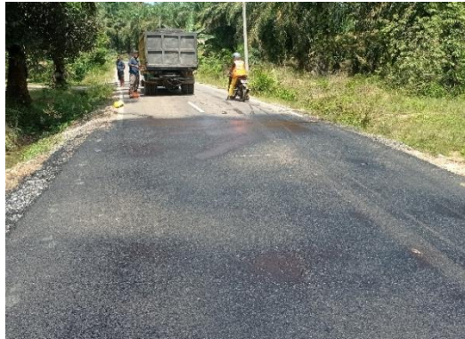
Gambar 3. 7 Pekerjaan Penyiraman Tcak Coat (Sumber: Dokumentasi KP, 2024)
