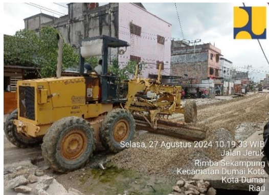
Gambar 3. 17 Motor Grader (Sumber: Dokumentasi KP, 2024)
