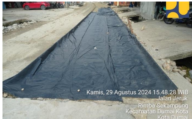
Gambar 3. 26 Pemasangan Plastik Alas (Sumber: Dokumentasi KP, 2024)
