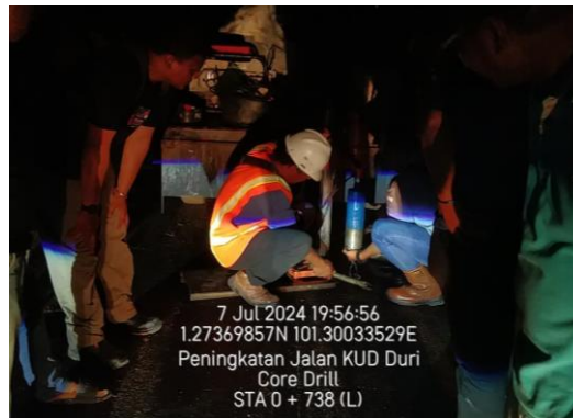
Gambar 3. 15 Pengujian Core Drill (Sumber: Dokumentasi KP, 2024)
