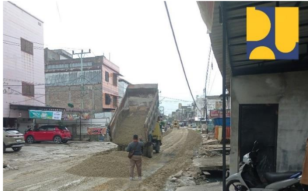
Gambar 3. 22 Base Diturunkan Dari Dump Truck (Sumber: Dokumentasi KP, 2024)
