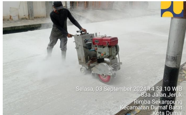
Gambar 3. 32 Pekerjaan Cutting (Sumber: Dokumentasi KP, 2024)
