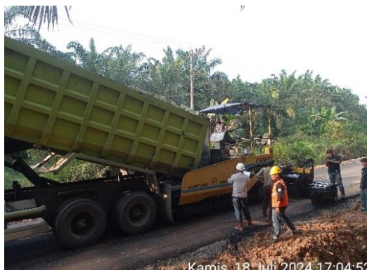
Gambar 3. 8 Pekerjaan MOBilisasi Campuran Hotmix (Sumber: Dokumentasi KP, 2024)
