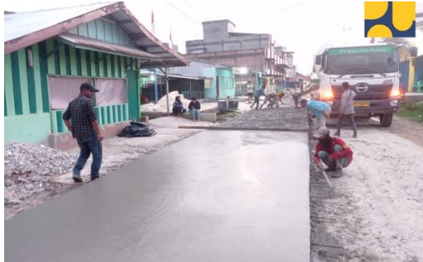
Gambar 3. 30 Pekerjaan Finishing (Sumber: Dokumentasi KP, 2024)
