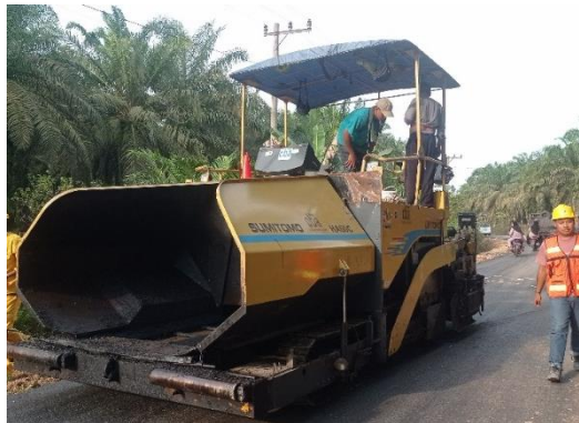
Gambar 3. 4 Asphalt Finisher (Sumber: Dokumentasi KP, 2024)
