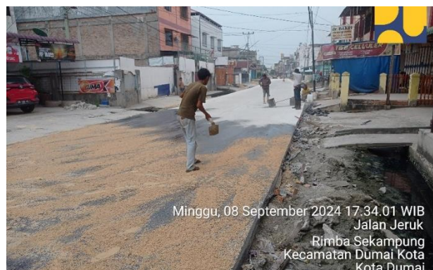
Gambar 3. 33 Pekerjaan Buras (Sumber: Dokumentasi KP, 2024)
