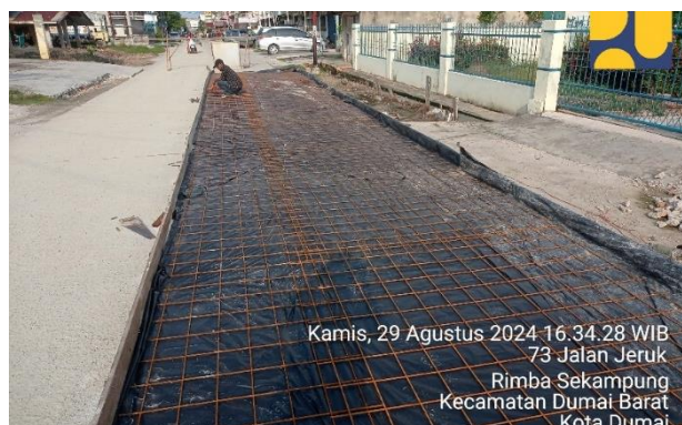
Gambar 3. 27 Pemasangan Wiremase (Sumber: Dokumentasi KP, 2024)
