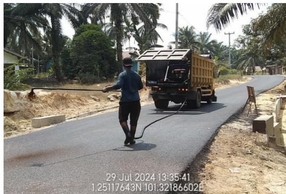
Gambar 3. 3 Asphalt Distributor (Sumber: Dokumentasi KP, 2024)
