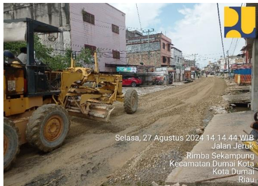
Gambar 3. 23 Pekerjaan Penghamparan Atau Perataan Agg Kelas B (Sumber: Dokumentasi KP, 2024)
