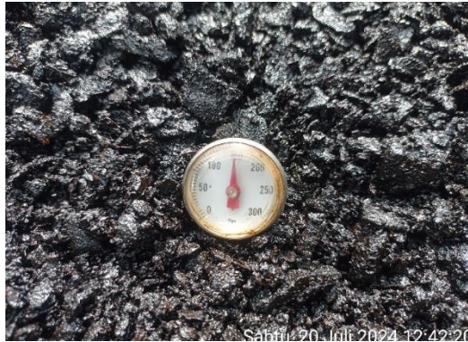
Gambar 3. 10 Pengecekan Suhu Penghamparan (Sumber: Dokumentasi KP, 2024)
