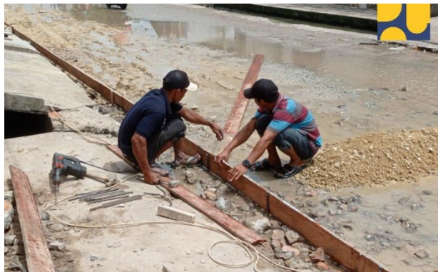
Gambar 3. 25 Pemasangan Bekisting (Sumber: Dokumentasi KP, 2024)
