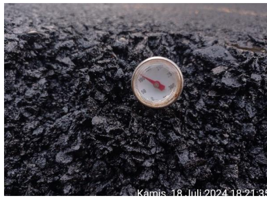
Gambar 3. 14 Pengecekan Suhu Akhir (Sumber: Dokumentasi KP, 2024)
