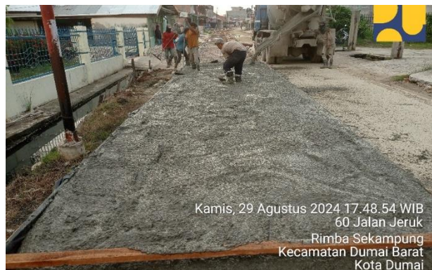
Gambar 3. 29 Pengecoran Beton (Sumber: Dokumentasi KP, 2024)
