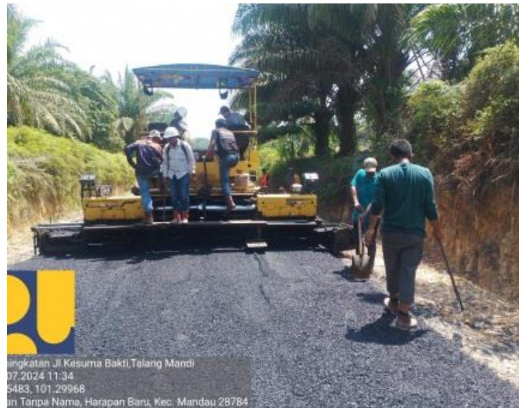
Gamabr 4. 3 Penghamparan AC-WC menggunakan Asphalt Finisher Sumber : dokumentasi lapangan
