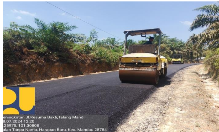
Gambar 3. 42 Pemadatan menggunakan Tandem Roller Sumber : dokumentasi lapangan, 2024
