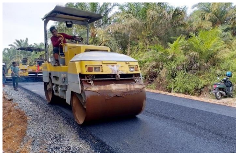
Gambar 3. 35 Pemadatan menggunakan Tandem Roller Sumber : dokumentasi lapangan, 2024
