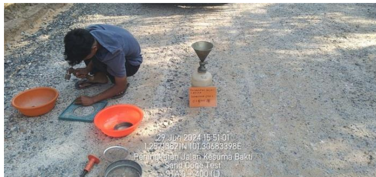
Gambar 3. 27 Pengujian Sand Cone Sumber : dokumentasi lapangan, 2024
