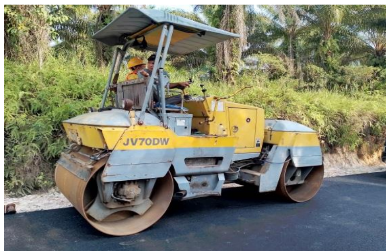
Gamabr 4. 7 pekerjaan pemdatan awal AC – WC menggunakan tandem roller Sumber : dokumentasi lapangan, 2024
