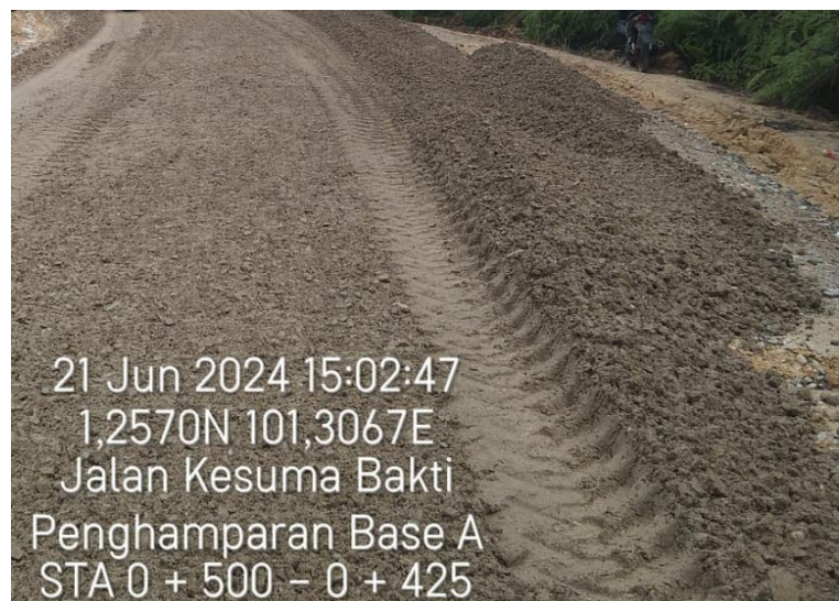
Gambar 3. 19 Material base A Sumber : dokumentasi lapangan, 2024
