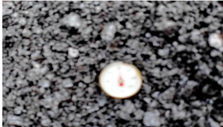
Gambar 3. 36 Pengecekan suhu pemadatan awal Sumber : dokumentasi lapangan, 2024
