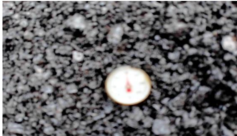
Gambar 3. 38 Pengeceka suhu pemadatan akhir Sumber : dokumentasi lapangan, 2024
