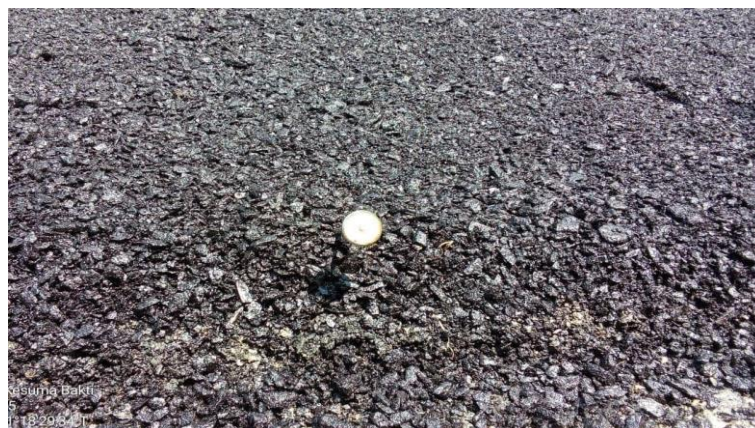
Gambar 3. 22 Aspal AC – BC sumber :dokumentasi lapangan, 2024
