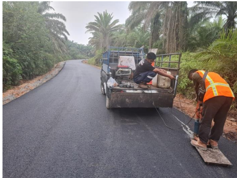
Gamabr 4. 9 pengujian Core Drill Sumber : dokumentasi lapangan, 2024
