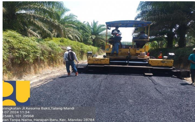
Gambar 3. 33 Penghamparan aspal menggunakan alat berat Asphalt Finisher Sumber : dokumentasi lapangan, 2024
