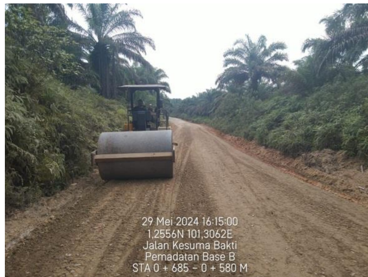
Gambar 3. 25 Pekerjaan pemadatan base B Sumber : dokumentasi lapangan, 2024
