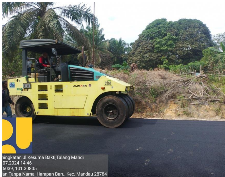
Gambar 3. 8 Pneumatic tire roller Sumber : dokumentasi lapangan, 2024
