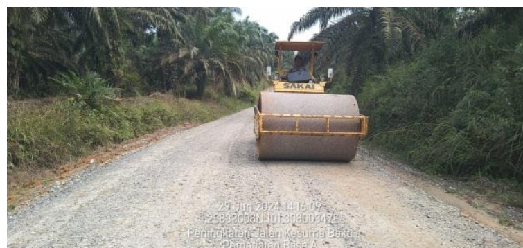
Gambar 3. 29 : Pekerjaan pemadatan base A Sumber : dokumentasi lapangan, 2024
