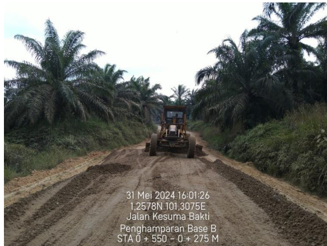
Gambar 3. 24 Pekerjaan penghamparan base B Sumber : dokumentasi lapangan, 2024
