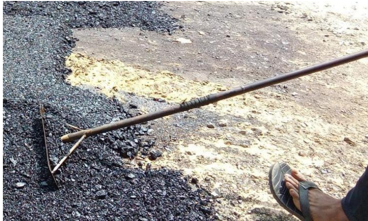
Gambar 3. 11 Asphalt Rakes sumber : Dokumentasi lapangan, 2024
