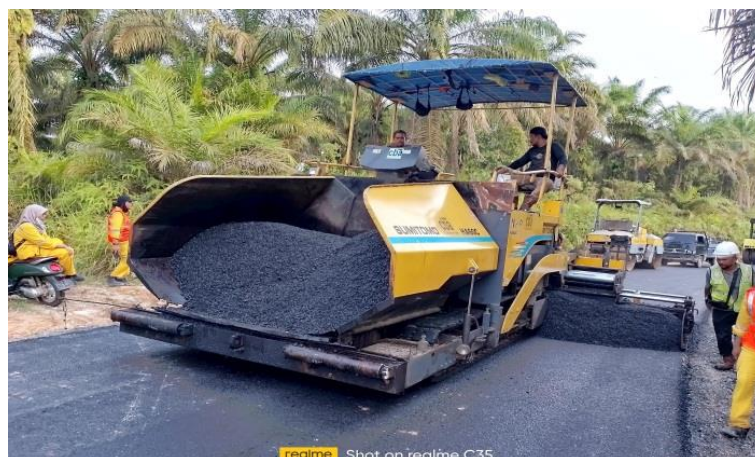
Gambar 3. 40 penghamparan AC – WC menggunakan Asphalt Finisher Sumber : dokumentasi lapangan, 2024
