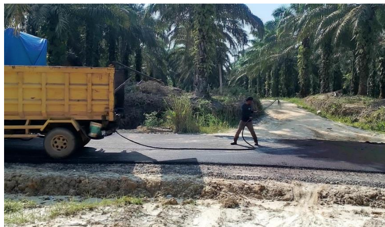
Gambar 3. 39 Pekerjaan Tack Coat Sumber : dokumentasi lapangan, 2024
