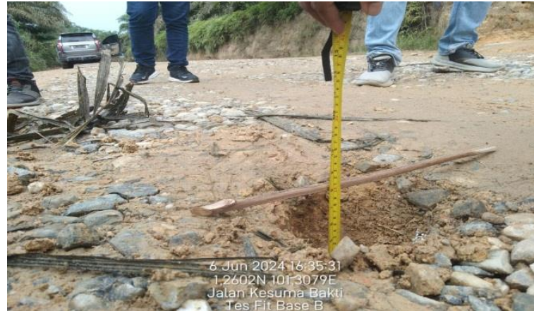
Gambar 3. 30 Pengujian test pit Sumber : dokumentasi lapangan, 2024
