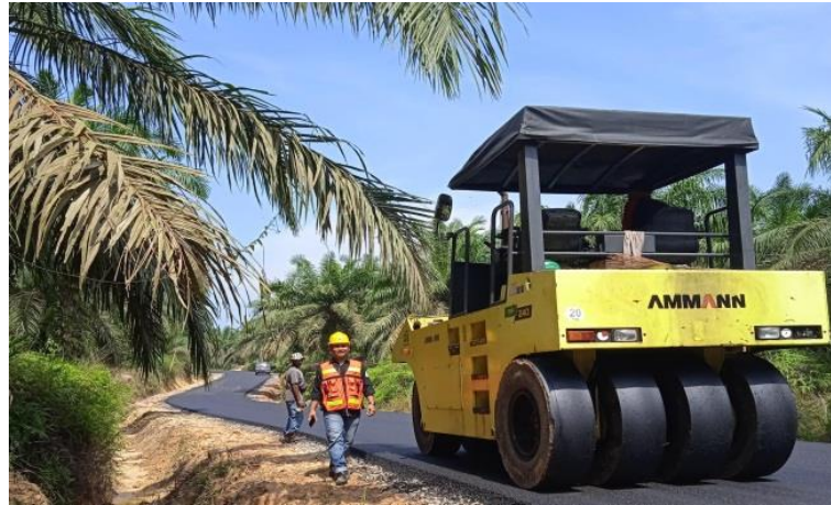
Gambar 3. 44 Pemadatan menggunakan Pneumatic Tire Roller Sumber : dokumentasi lapangan, 2024
