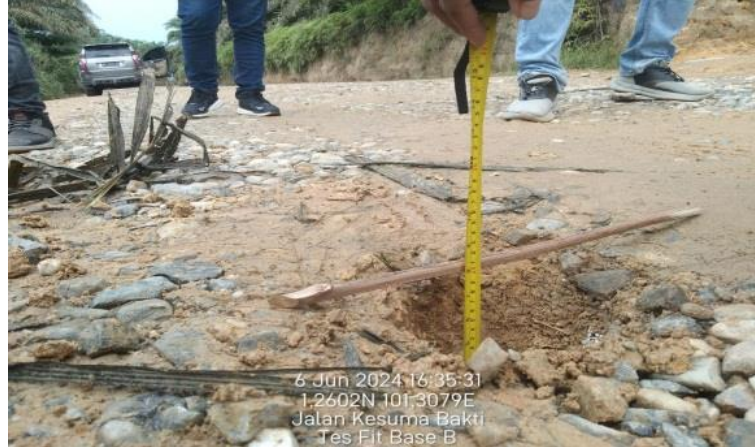
Gambar 3. 26 Test Pit Sumber : dokumentasi lapangan, 2024
