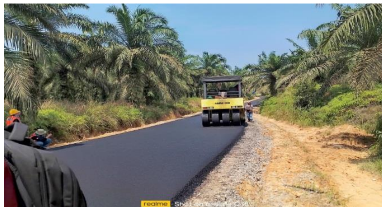
Gamabr 4. 8 pekerjaan pemadatan akhir aspal AC – WC menggunakan Sumber : dokumentasi lapangan, 2024
