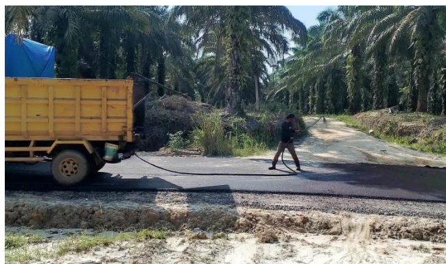
Gamabr 4. 2 Pekerjaan Tack coat Sumber : dokumentasi lapangan,2024
