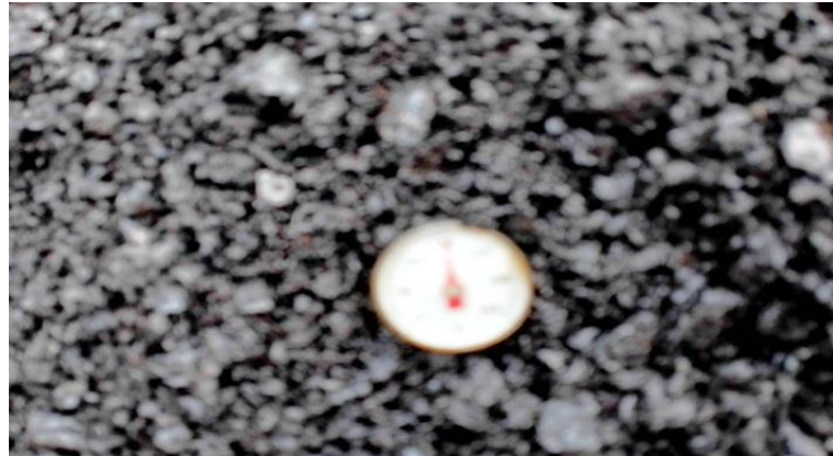
Gambar 3. 41 Pengecekan suhu penghamparan Sumber : dokumentasi lapangan, 2024
