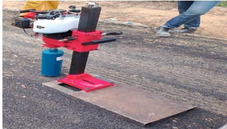
Gambar 3. 17 Mesin Core Drill aspal sumber : dokumentasi lapangan, 2024
