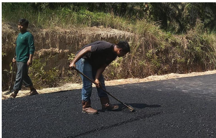
Gamabr 4. 5 pemerataan lapisan AC – WC menggunakan cheker Sumber : dokumentasi lapangan,2024
