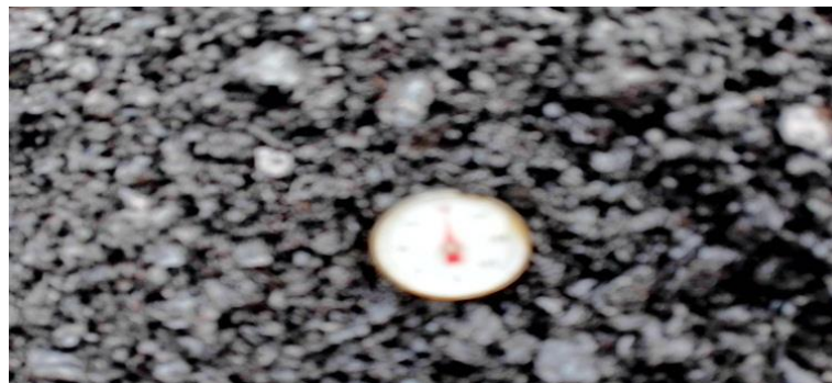
Gambar 3. 43 Pengecekan suhu pemadatan awal Sumber : dokumentasi lapangan, 2024
