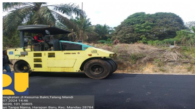
Gambar 3. 37 Pemadatan menggunakan Pneumatic Tire Roller Sumber : dokumentasi lapangan, 2024
