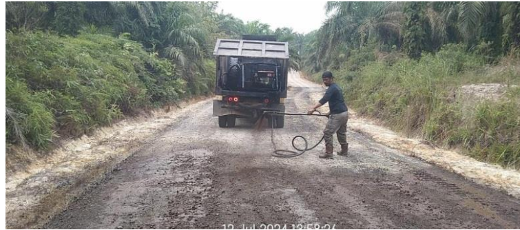
Gambar 3. 32 Pekerjaan Prime Coat Sumber : dokumentasi lapangan
