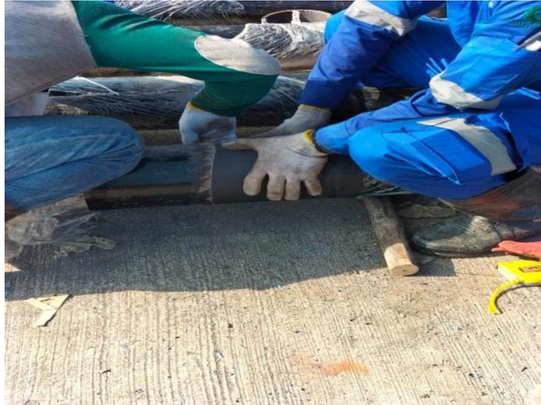
*Gambar 4. 6 Pengacuan garis pada pipa bracing sebelum pemotongan agar presisi*
