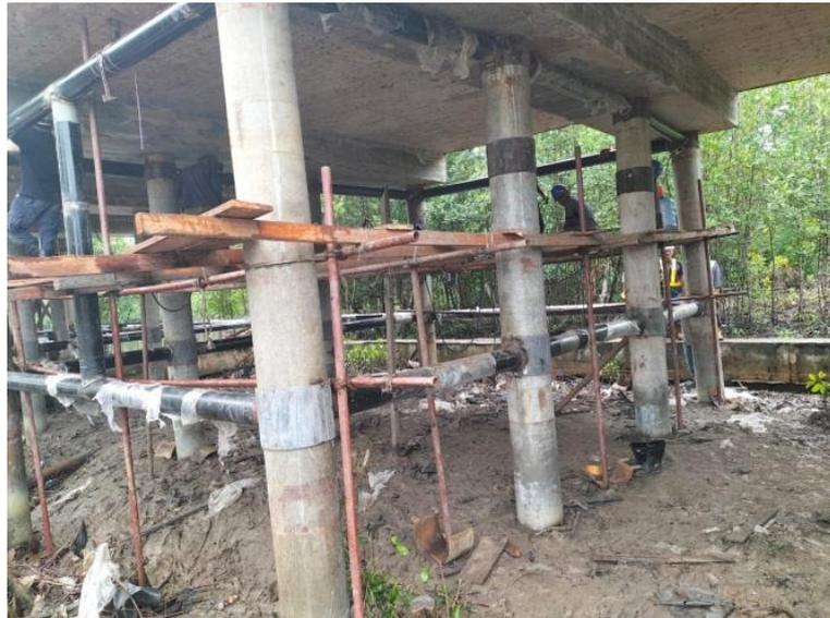
*Gambar 4. 8 Scaffolding yang di gunakan sebagai pijakan dan alas lantai untuk mempermudah proses pemasangan bracing*
