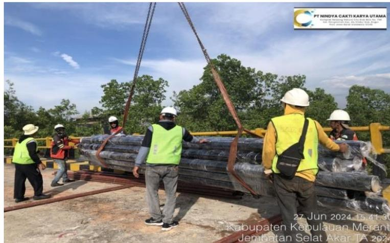
*Gambar 4. 2 Memindah kan material bracing menggunakan crane*
