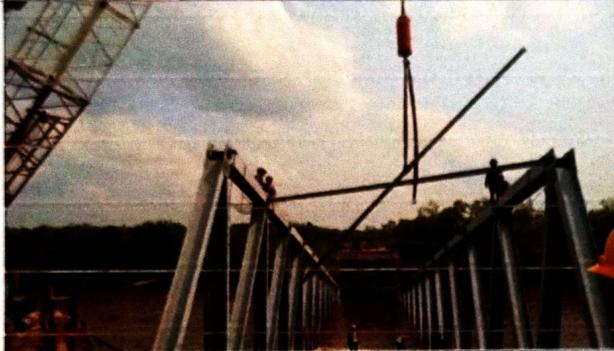
Pembongkaran rangka baja jembatan menggunakan kunci pas dan kunci impact untuk membuka baut satu persatu dan crane untuk mengangkat rangka.
