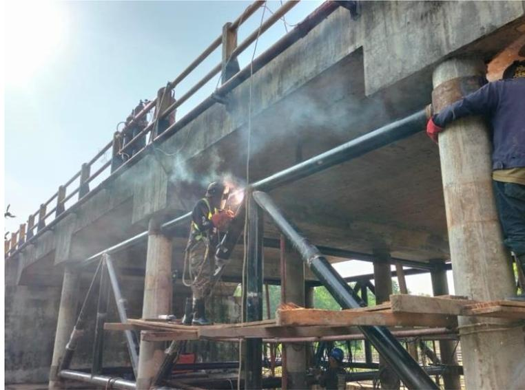
*Gambar 4. 15 Pengelasan pipa bracing menggunakan las listrik*
