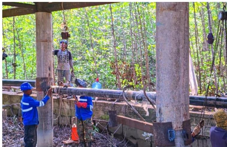
Gambar 4. 14 Penurunan pipa bracing menggunakan catrol dan tali
