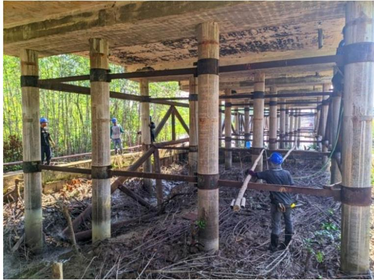
*Gambar 4. 4 Pembongkaran bracing lama yang sudah rusak*
