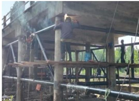
*Gambar 4. 10 proses pemasangan bracing menggunakan sambungan las listrik
