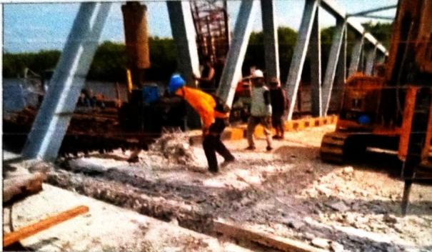
Pembongkaran lantai beton pada rangka baja jembatan dengan cara dibobok persegmen, menggunakan jack hammer dan excavator pc 75 lalu di angkat menggunakan crane.
