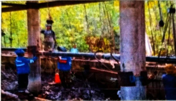
Pemasangan Bracing arah belitung berfungsi untuk penguat struktur jembatan. Sebelum melakukan pembongkaran.
