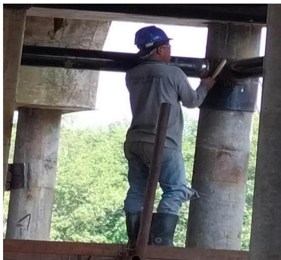
*Gambar 4. 20 Pembersihan sambungan las menggunakan sikat besi*
