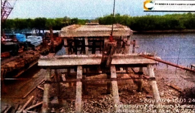
Pembongkaran segmen 4 tanjung padang menggunakan cutting torch untuk memotong tulangan dan crane untuk menghancurkan beton dan tiang pancang beserta pile slabnya.
