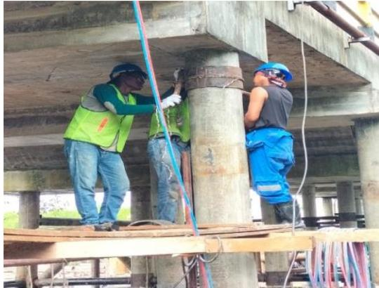
*Gambar 4. 9 Pemasangan klem pada tiang jembatan
