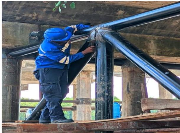
*Gambar 4. 19 Pembersihan kerak las menggunakan palu*
