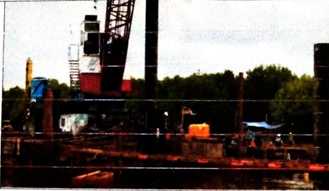
Pemasangan tiang pancang baja yang di angkat menggunakan crane ke titik untuk pemancangan
