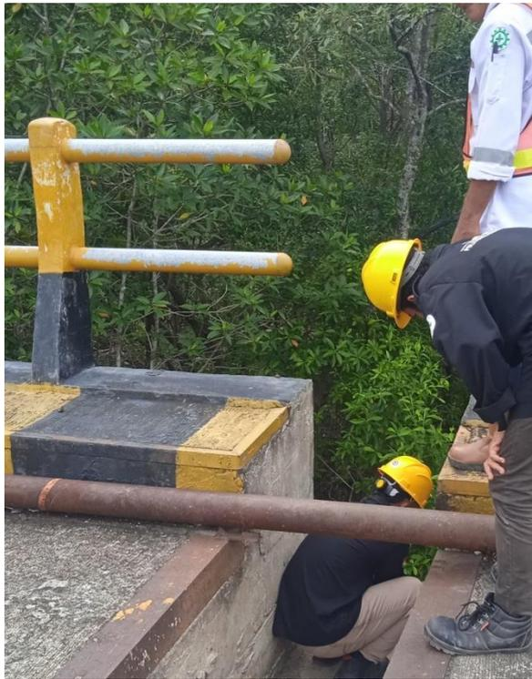
*gambar 3. 3 survei pengukuran dimensi pile slab dan pier head*
