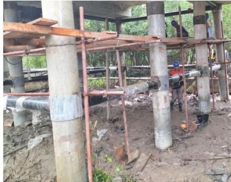
*Gambar 4. 24 Scaffolding yang digunakan untuk membantu sebagai pijakan saat pemasangan bracing*
