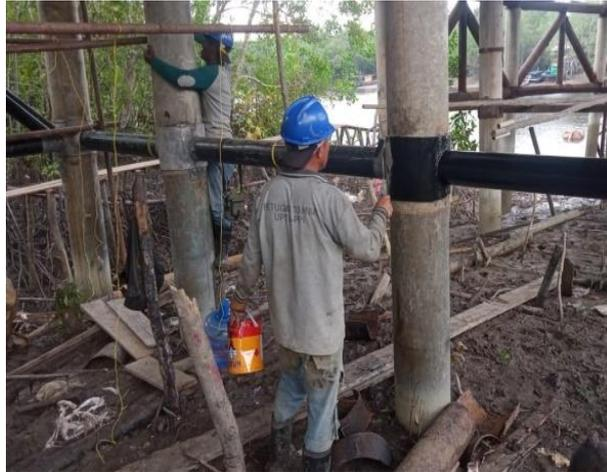
Gambar 4. 21 Pengecatan sambungan lasan pipa bracing menggunakan kuas roll dan cat minyak
