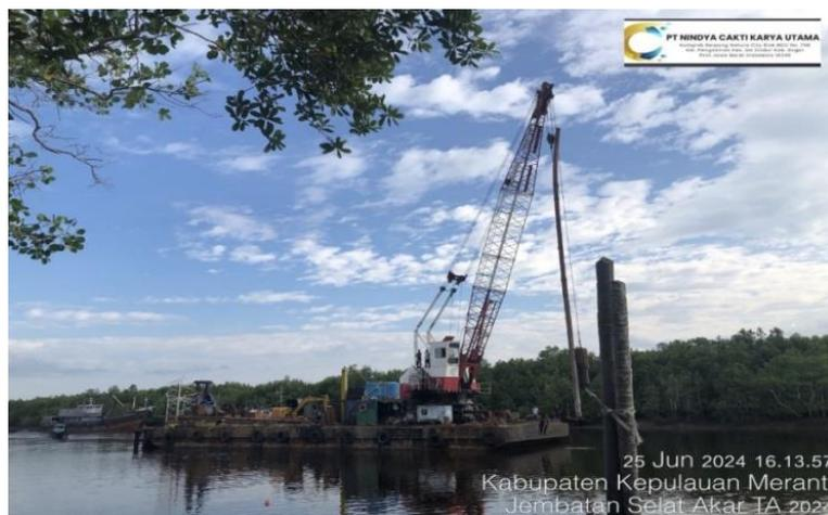
*Gambar 4. 3 crane dan ponton yang digunakan untuk mobilisasi alat dan material*
