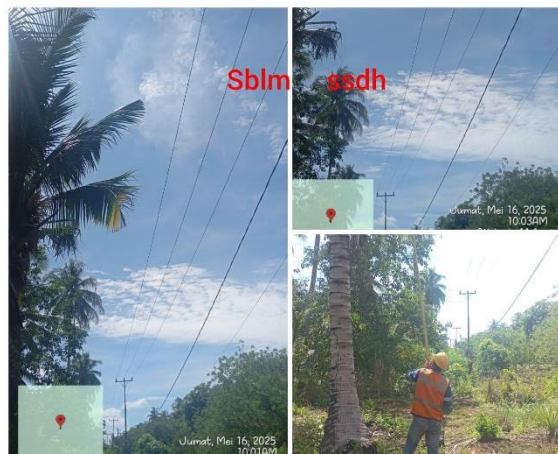
Gambar 2.97 Pemangkasan/ROW
