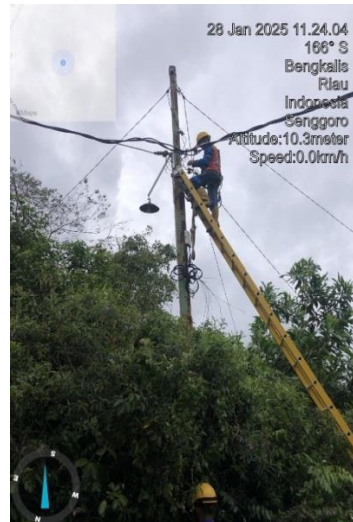
Gambar 2.14 Menaikkan kabel SKUTR
