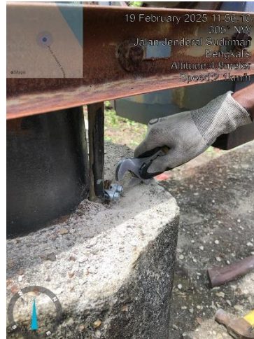
Gambar 2.50 Pemasangan grounding body
