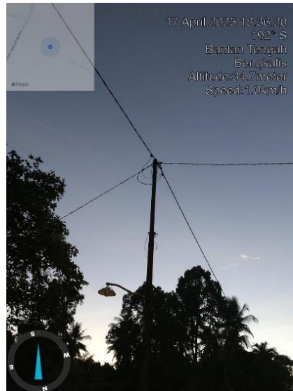
Gambar 2.72 Pemasangan kabel SR
