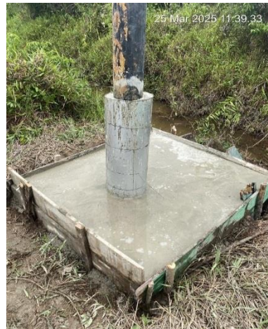
Gambar 2.56 Pengecoran manset
