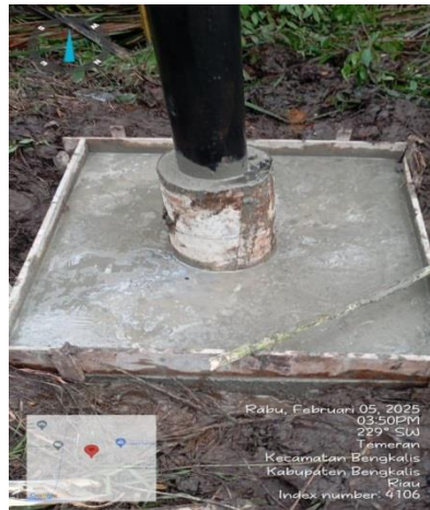
Gambar 2.48 Pembuatan manset
