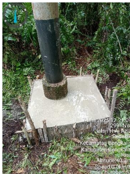
Gambar 2.87 Pengecoran manset
