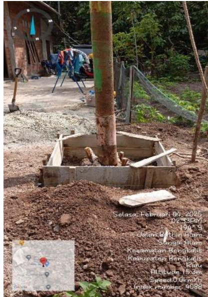
Gambar 2.68 Pemasangan manset
