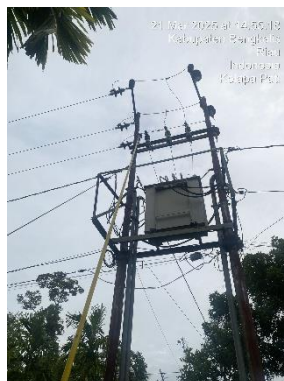
Gambar 3.3.12 Trafo distribusi
