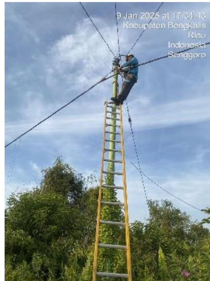
Gambar 2.6 Menaikkan kabel SKUTR yang jatuh
