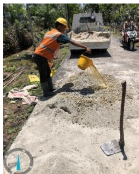
Gambar 2.65 pengecoran pada tiang TR
