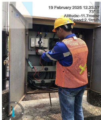
Gambar 2.30 Pengecekan tegangan setelah di PHB-TR
