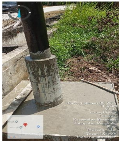
Gambar 2.20 Pengecoran manset
