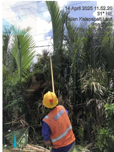
Gambar 2.52 Pemangkasan/ROW
