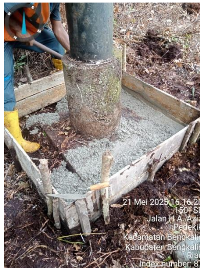
Gambar 2.54 Pembuatan manset
