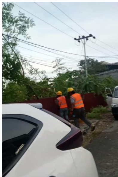
Gambar 2.112 Pemangkasan/ROW
