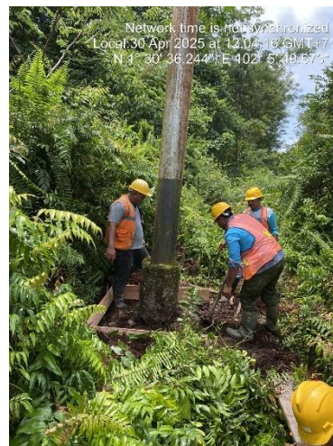
Gambar 2.83 Pembuatan manset
