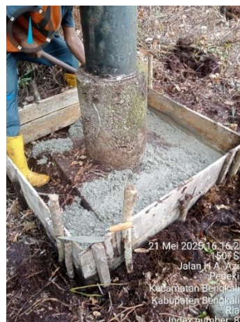
Gambar 2.100 Pembuatan manset
