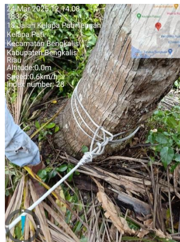
Gambar 2.55 Pemasangan treck schoor
