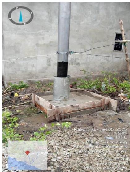
Gambar 2.47 Pembuatan manset
