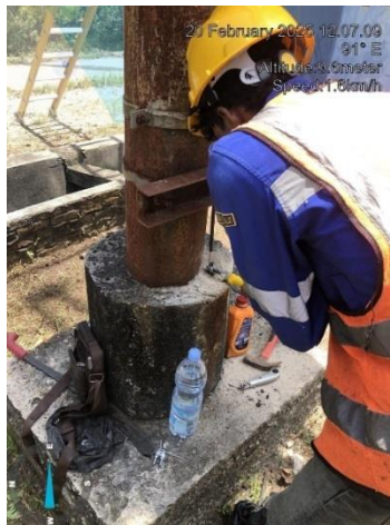
Gambar 2.35 Penguncian finik untuk grounding
