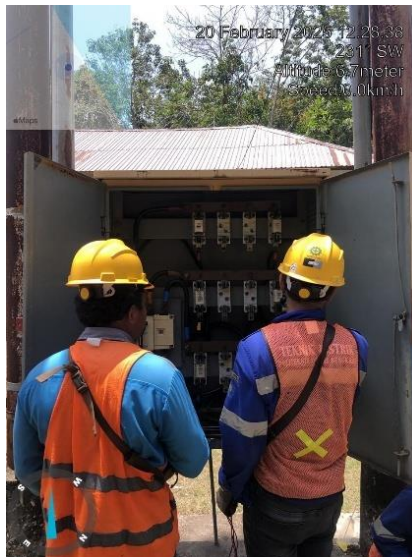
Gambar 2.38 Pengecekan tegangan setelah di PHB-TR
