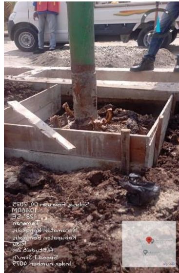
Gambar 2.18 Pembuatan manset
