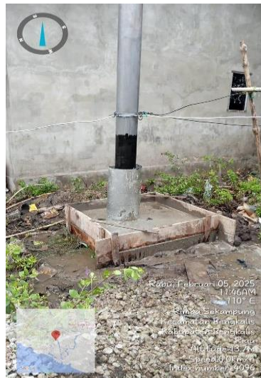
Gambar 2.19 Pengecoran manset
