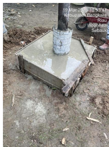
Gambar 2.53 Pengecoran manset
