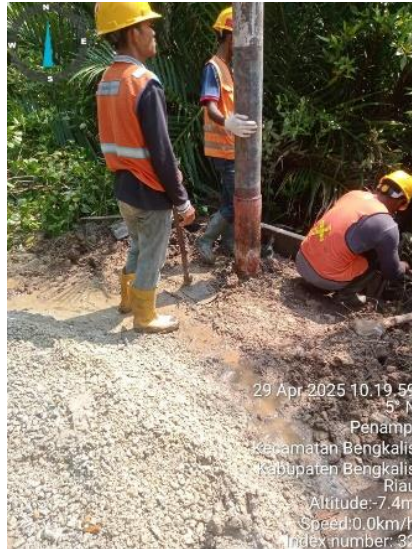
Gambar 2.80 Pembuatan manset
