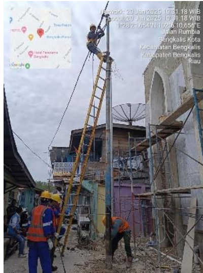
Gambar 2.8 Pemindahan tiang JTR
