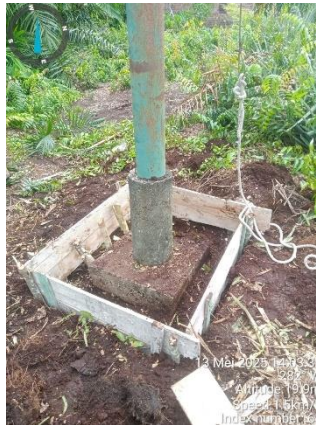
Gambar 2.91 Pembuatan manset
