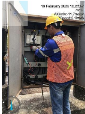
Gambar 3.3.10 Pengecekan dan pengukuran
