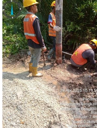
Gambar 2.82 Pembuatan manset
