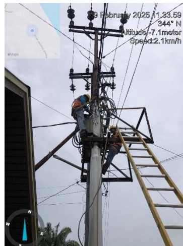
Gambar 2.51 Pemeliharaan PHBTR
