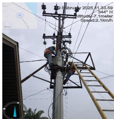
Gambar 2.29 Pengguncian baut pada busing dan memberi pengenalan R, S, T, DAN N pada join
