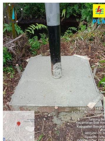
Gambar 2.49 Pembuatan manset
