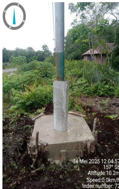
Gambar 2.94 Pengecoran manset
