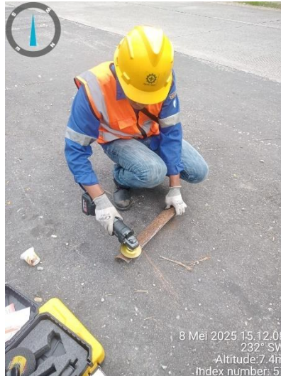
Gambar 2.88 Proses pengamplasan besi agar lekat
