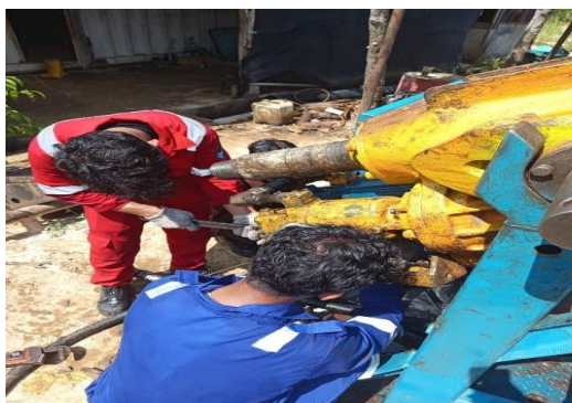
Gambar 4.13 Pemasangan hose supply dan return . (Sumber: Dokumentasi Pribadi)
