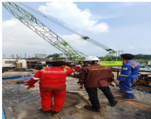
Gambar 3.11 Penataan ulang komponen-komponen di yard KM-08 (Sumber : Dokumentasi Pribadi)
