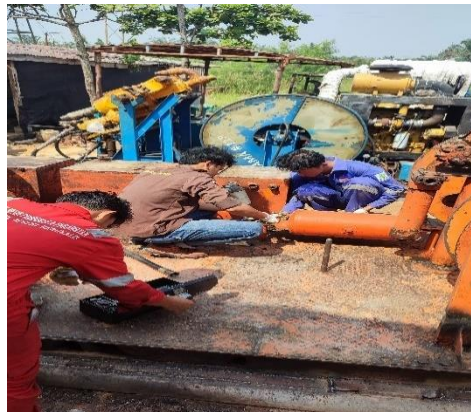
Gambar 3.29 Pemasangan air tube dan hose ARJ-05 (Sumber : Dokumentasi Pribadi)
