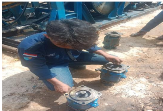
Gambar 3.10 Perbaikan motor hidrolik 4633 (Sumber: Dokumentasi Pribadi)
