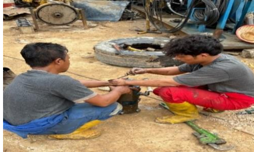
Gambar 4.12 Pemasangan Komponen Motor hidrolik type 4633 ARJ-09 (Sumber: Dokumentasi Pribadi)
