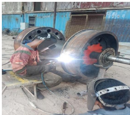
Gambar 3.12 welding DRUM WINCH RIG-02 (Sumber : Dokumentasi Pribadi)
