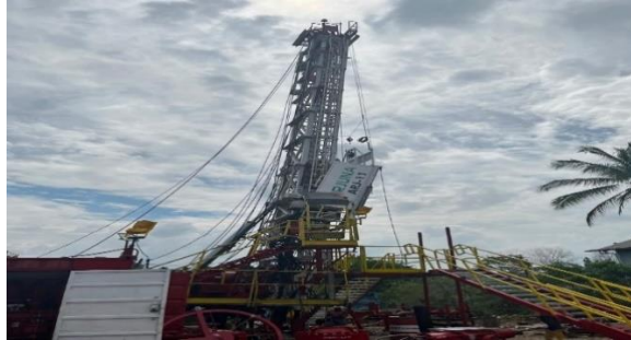
Gambar 3.18 Inspeksi pada unit RIG-11 (Sumber : Dokumentasi Pribadi)
