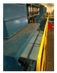
Gambar 3.52 Filter Udara Generator
