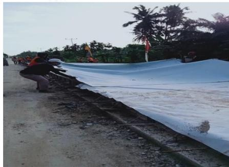
Gambar 4.13: Pekerjaan geotek non woven rigid
