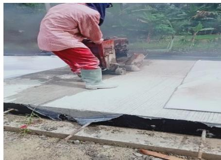
Gambar 4.12: Pekerjaan cutting rigid
