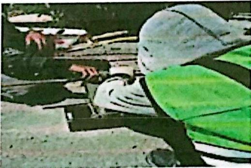
ruskam kayu, kemudian digunakan mesin penggetar (vibrator) untuk memadatkan beton dan menghilangkan udara yang terjebak didalam beton yang baru di hamparkan. Setelah beton terlihat agak mengering, kemudian permukaan beton di garis menggunakan penggaruk besi, setelah itu beton di tutup menggunakan geotex non woven, kemudian di curing untuk menjaga suhu beton tidak terlalu panas.
