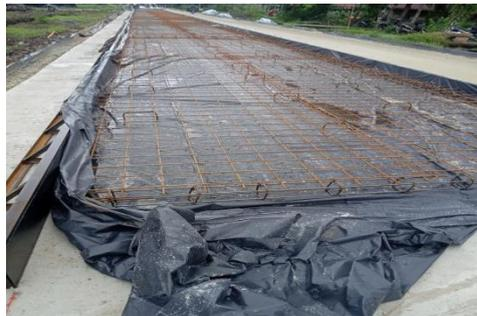
Gambar 4.9: Pekerjaan pemasangan tulangan rigid
