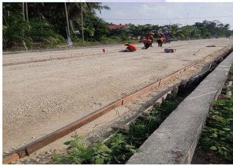
Gambar 4.3: Pekerjaan pemasangan bekisting le
