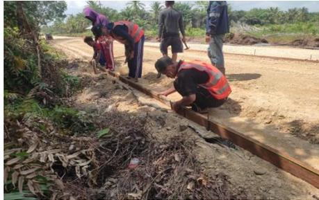
Gambar 3.10: Pekerjaan pemasangan mal lc
