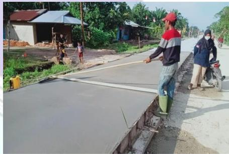
Gambar 4.11: Pekerjaan grooving rigid
