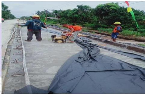
Gambar 3.14: Pekerjaan pemasangan plastik terpal rigid
