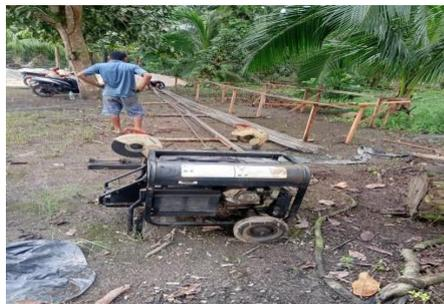
Gambar 4.5: Pekerjaan pemotongan tulangan
