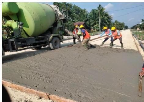
Gambar 3.11: Pekerjaan pengecoran lc
