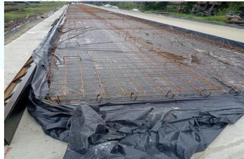
Gambar 3.15: Pekerjaan pemasangan tulangan rigid
