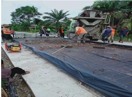
Gambar 4.10: Pekerjaan pengecoran rigid
