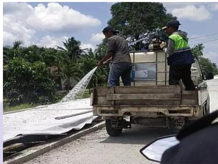
Gambar 4.43: Pekerjaan curing rigid
