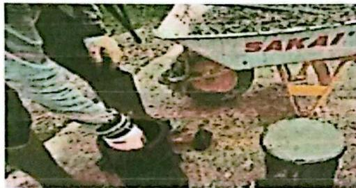
beton yang baru di hamparkan. Setelah beton terlihat agak mengering, kemudian permukaan beton di gans menggunakan penggaruk besi, setelah itu beton di tutup menggunakan geotex non woven, kemudian di curing untuk mcnjaga suhu beton tidak terlalu panas.
