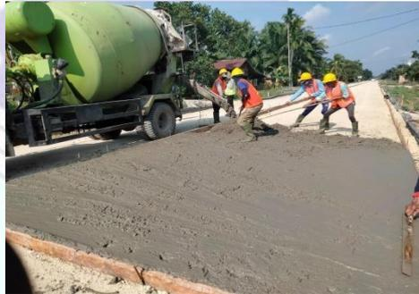
Gambar 4.4: Pekerjaan pengecoran lc
