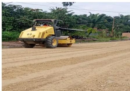
Gambar 4.2: Pekerjaan pematatan base B
