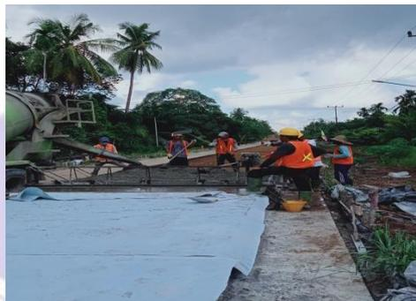
Gambar 3.18: Pekerjaan pengecoran rigid
