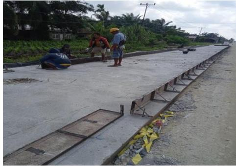
Gambar 3.14: Pekerjaan pemasangan mal rigid
