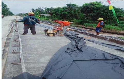
Gambar 4.8: Pekerjaan pemasangan plastik terpal rigid
