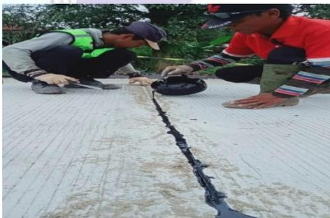
Gambar 3.20: Pekerjaan penuangan aspal pada potongan rigid
