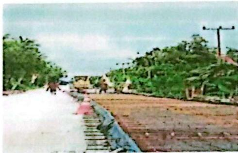
Dilakukan pemasangan mal le sebelah kanan dari STA 950 meter menggunakan bahan papan, tulangan dan menggunakan alat bor.
