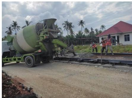
Gambar 3.16: Pekerjaan pengecoran rigid
