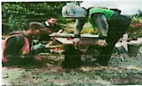
Dilakukan penyambungan pemasangan mal rigid menggunakan mesin bor untuk penancapan penahan mal rigid, kemudian dipasang geotex woven sebagai alas, setelah itu dipasang kayu berbentuk segitiga pada setiap 10,50 cm, kemudian dilakukan pemasangan tulangan rigid, tulangan bangku dan tulangan wiremesh, tulangan tiebar dan tulangan dowel.
