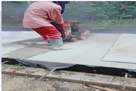
Gambar 3.19: Pekerjaan pemotongan rigid
