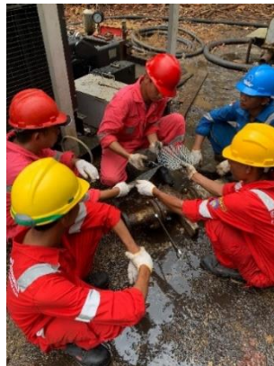
Gambar 4. 7 Proses pemasangan filter tambahan pada jalur hisap pompa. Sumber : Dokumentasi Lapangan
