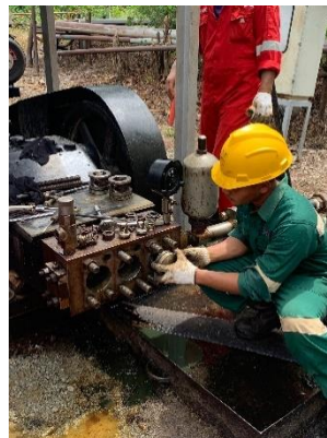
Gambar 4. 2 Tahap lanjutan pembongkaran bagian housing pompa Sumber: Dokumentasi Lapangan
