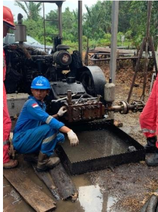
Gambar 4. 1 Proses awal pembongkaran Triplex Plunger Pump Sumber: Dokumentasi Lapangan
