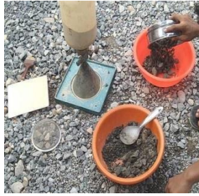
Gambar 3. 16 Alat-alat Uji Sand Cone Sumber : Dokumentasi lapangan 2024
