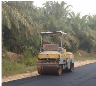
Gambar 3. 7 Tandem Roller Sumber : Dokumentasi lapangan 2024
