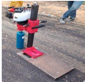
Gambar 3. 17 Mesin Core Drill Aspal Sumber : Dokumentasi lapangan 2024
