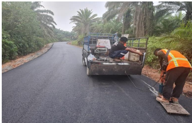
Gambar 4. 9 Pengujian Core Drill AC-BC Sumber : Dokumentasi lapangan 2024
