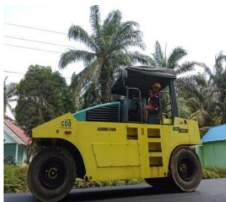
Gambar 3. 8 Pneumatic Tired Roller Sumber : Dokumentasi lapangan 2024
