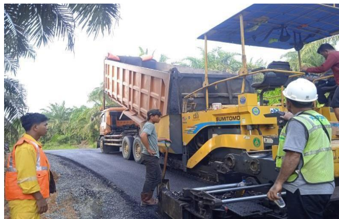
Gambar 4. 5 Penuangan AC-BC ke dalam Asphalt Finisher
