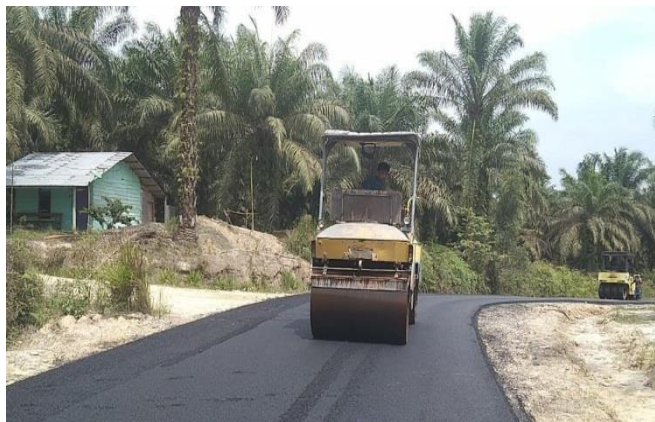
Gambar 4. 7 Pemadatan Tandem Roller Sumber : Dokumentasi Lapangan 2024
