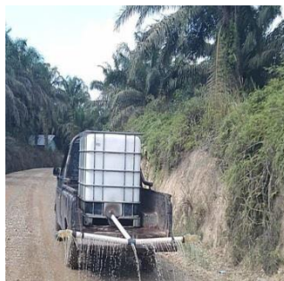
Gambar 3. 5 Water Tank Sumber : Dokumentasi lapangan 2024
