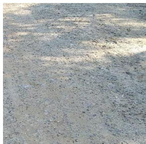
Gambar 3. 19 Material Agregat Kelas A Sumber : Dokumentasi lapangan 2024
