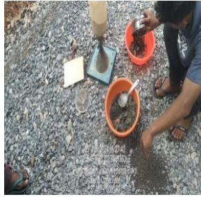
Gambar 3. 25 Pengujian Sand Cone Base B Sumber : Dokumentasi Lapangan 2024
