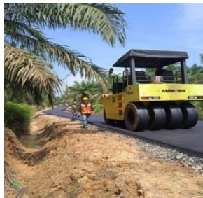
Gambar 3. 32 Pemadatan Menggunakan Pneumati Tired Roller Sumber : Dokumentasi lapangan 2024
