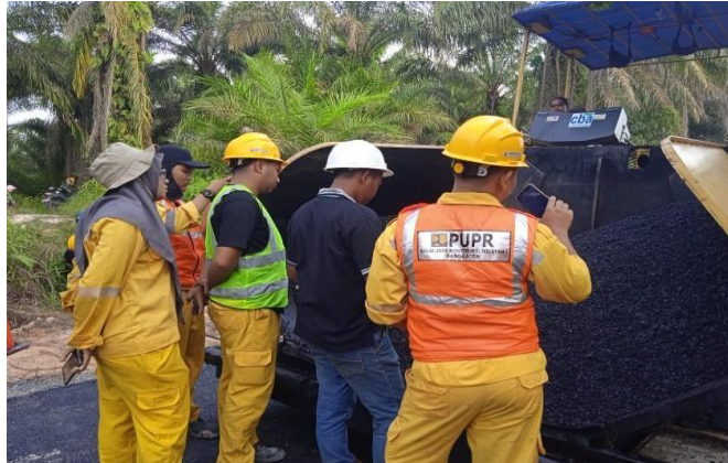
Gambar 4. 3 Pengecekan suhu aspal di dalam Asphalt Finisher Sumber : dokumentasi lapangan 2024
