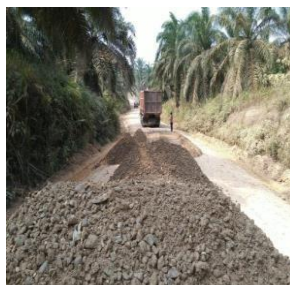
Gambar 3. 26 Pekerjaan Penghamparan Base A Sumber : Dokumentasi lapangan 2024
