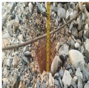
Gambar 3. 28 Pengujian Test Pit Base A Sumber : Dokumentasi lapangan 2024
