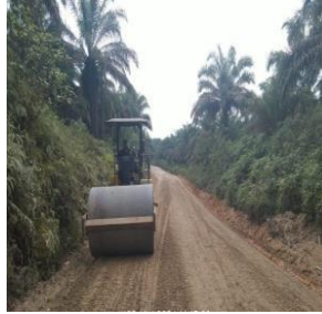
Gambar 3. 23 Pekerjaan Pemdatan Base B Sumber : Dokumentasi lapangan 2024
