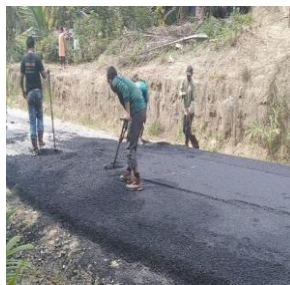
Gambar 3. 30 Pekerjaan Penghamparan AC-BC Sumber : Dokumentasi lapangan 2024
