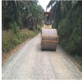
Gambar 3. 27 Pemadatan Base A Sumber : dokumentasi lapangan 2024
