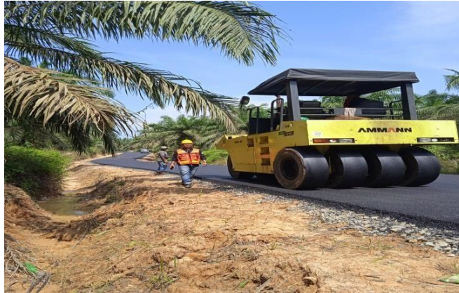
Gambar 4. 8 Pemadatan Pneumatic Tired Roller Sumber : Dokumentasi lapangan 2024
