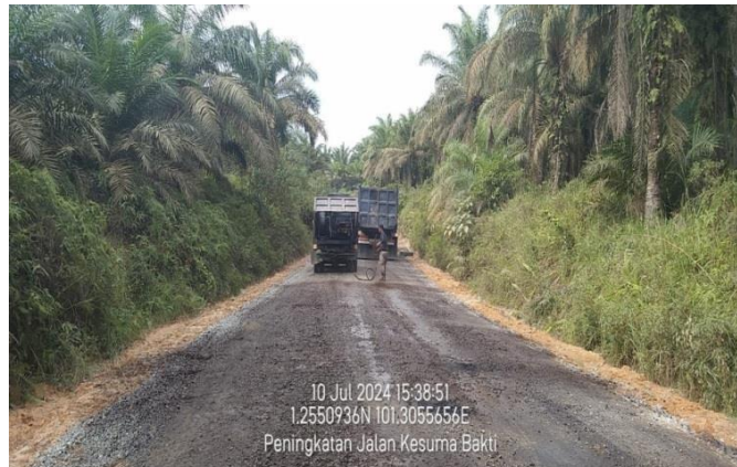
Gambar 4. 2 Pekerjaan prime coat Sumber : Dokumentasi lapangan 2024
