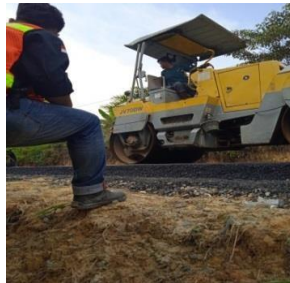
Gambar 3. 31 Pemadatan menggunakan Tandem Roller Sumber : Dokumentasi lapangan 2024
