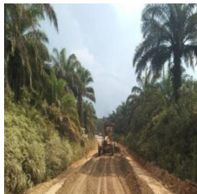
Gambar 3. 22 Pekerjaan Penghamparan Base B Sumber : Dokumentasi lapangan 2024
