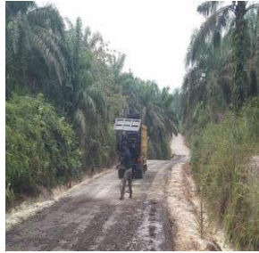
Gambar 3. 29 Pekerjaan Prime Coat Sumber : dokumentasi lapangan 2024
