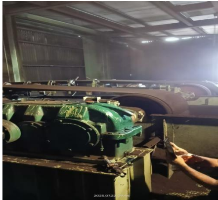
Gambar 3. 8 Kegiatan Selasa 22 Juli 2025 (Sumber : Dokumentasi PT. Power Plant )
