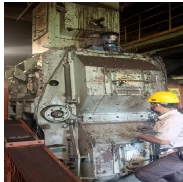
Gambar 3. 38 Kamis 28 Agustus 2025 (Sumber : Dokumentasi PT. Power Plant)
