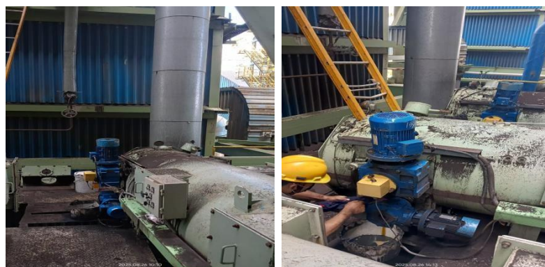
Gambar 3. 36 Selasa 26 Agustus 2025 (Sumber : Dokumentasi PT. Power Plant)
