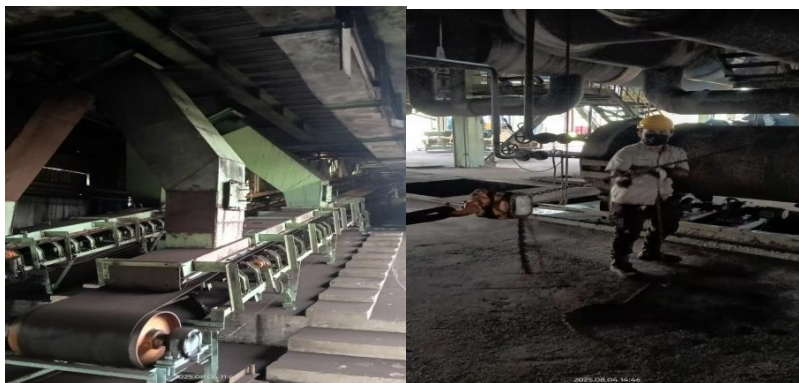
Gambar 3. 19 Kegiatan Senin 4 Agustus 2025 (Sumber : Dokumentasi PT. Power Plant)
