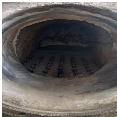
Gambar 3. 40 Sabtu 30 Agustus 2025 (Sumber : Dokumentasi PT. Power Plant)
