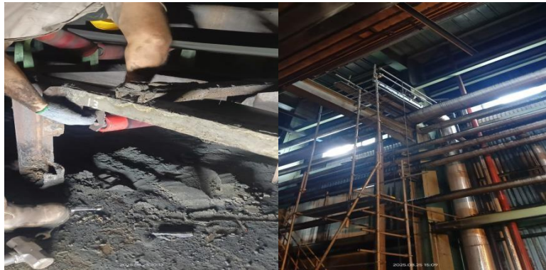
Gambar 3. 35 Senin 25 Agustus 2025 (Sumber : Dokumentasi PT. Power Plant)
