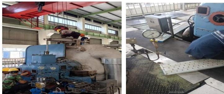
Gambar 3. 2 Kegiatan Selasa 15 Juli 2025 (Sumber : Dokumentasi PT. Power Plant )
