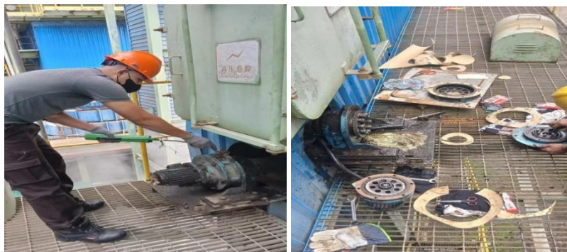
Gambar 3. 30 Selasa 19 Agustus 2025 (Sumber : Dokumentasi PT. Power Plant)
