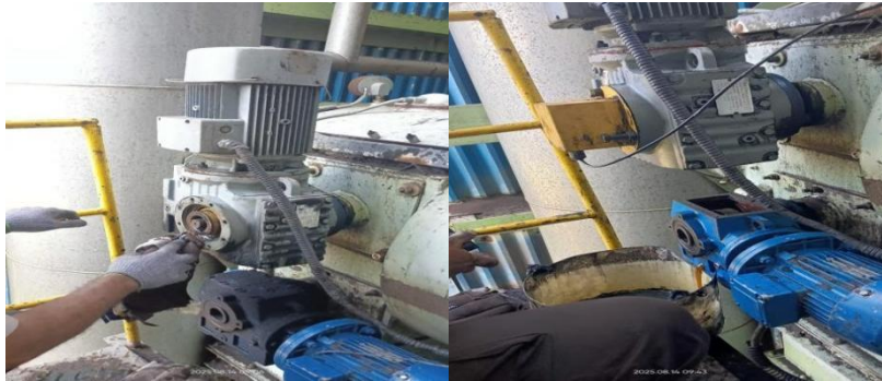
Gambar 3. 27 Kamis 14 Agustus 2025 (Sumber : Dokumentasi PT. Power Plant)
