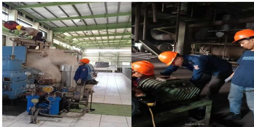
Gambar 3. 4Kegiatan Kamis 17 Juli 2025 (Sumber : Dokumentasi PT. Power Plant)
