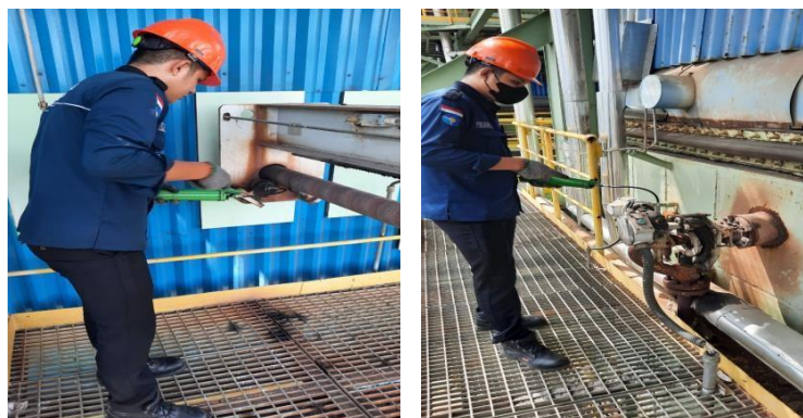
Gambar 3. 16 Kegiatan Kamis 31 Juli 2025 (Sumber : Dokumentasi PT. Power Plant)
