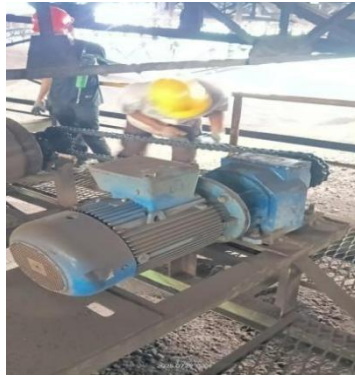
Gambar 3. 14 Kegiatan Selasa 29 Juli 2025 (Sumber : Dokumentasi PT. Power Plant)
