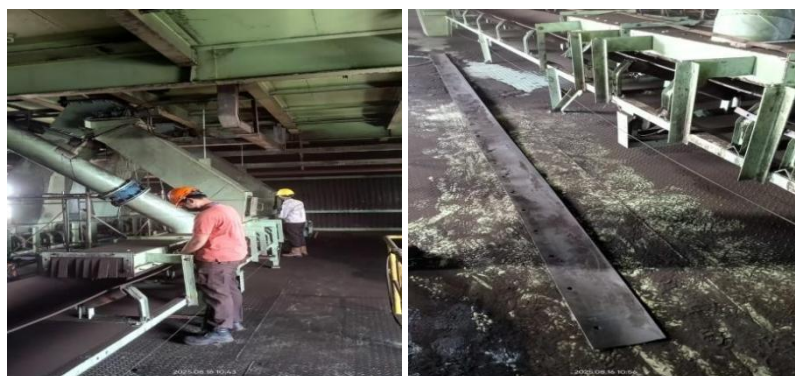
Gambar 3. 29 Sabtu 16 Agustus 2025 (Sumber : Dokumentasi PT. Power Plant)
