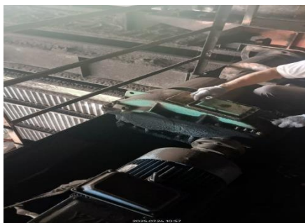
Gambar 3. 10 Kegiatan Kamis 24 Juli 2025 (Sumber : Dokumentasi PT. Power Plant )
