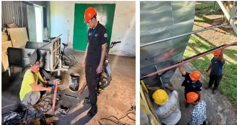
Gambar 3. 22 Kegiatan Kamis 7 agustus 2025 (Sumber : Dokumentasi PT Power Plant )
