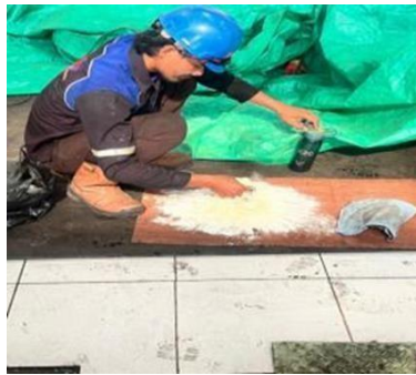
Gambar 3. 7 Kegiatan senin 21 juli 2025 (Sumber : Dokumentasi PT Power Plant)
