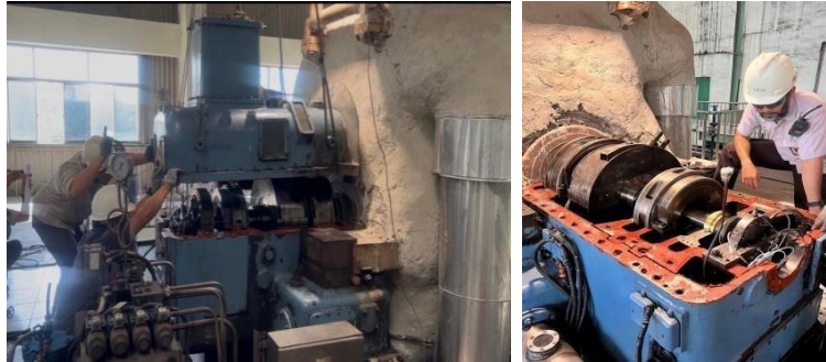
Gambar 3. 5 Kegiatan jum'at 18 juli 2025 (Sumber : Dokumentasi PT Power Plant)
