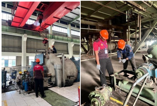
Gambar 3. 4 Kegiatan Kamis 17 juli 2025 (Sumber : Dokumentasi PT Power Plant )
