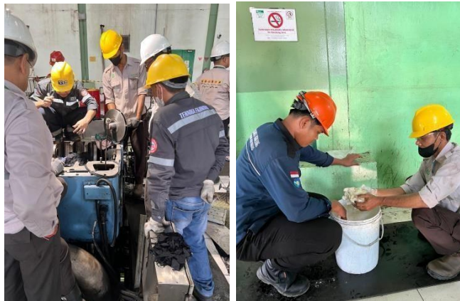
Gambar 3. 37 Kegiatan Rabu 27 agustus 2025 (Sumber : Dokumentasi PT Power Plant )
