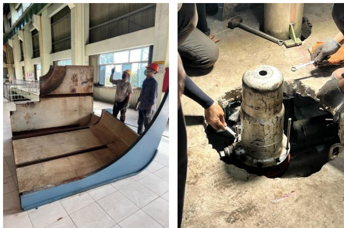
Gambar 3. 2 Kegiatan Selasa 15 juli 2025 (Sumber : Dokumentasi PT Power Plant )
