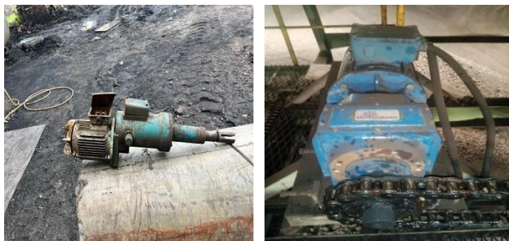
Gambar 3. 11 Kegiatan jum'at 25 juli 2025 (Sumber : Dokumentasi PT Power Plant )
