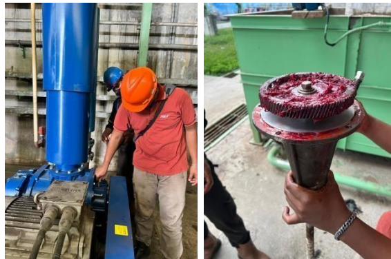
Gambar 3. 14 Kegiatan selasa 29 juli 2025 (Sumber : Dokumentasi PT Power Plant )
