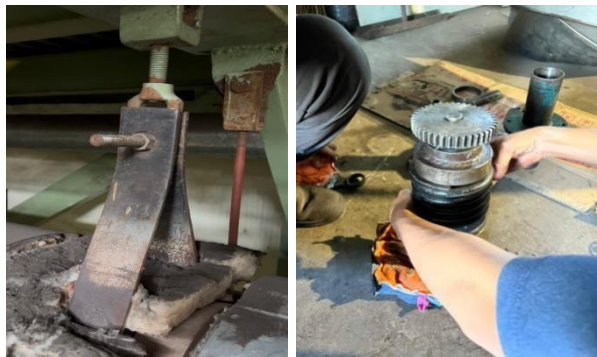
Gambar 3. 10 Kegiatan kamis 24 juli 2025 (Sumber : Dokumentasi PT Power Plant )
