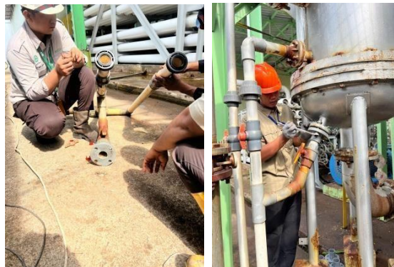
Gambar 3. 16 Kegiatan Kamis 31 juli 2025 (Sumber : Dokumentasi PT Power Plant )
