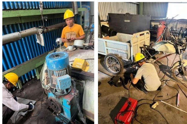
Gambar 3. 31 Kegiatan Rabu 20 agustus 2025 (Sumber : Dokumentasi PT Power Plant)
