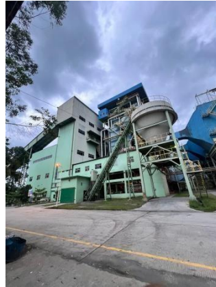
Gambar 3. 1 Kegiatan Senin 14 Juli 2025 (Sumber : Dokumentasi PT Power Plant )
