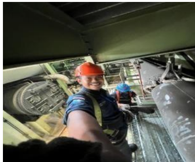
Gambar 3. 8 Kegiatan selasa 22 juli 2025 (Sumber : Dokumentasi PT Power Plant)
