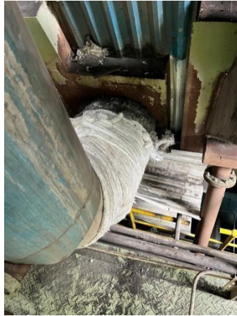
Gambar 3. 32 Kegiatan Kamis 21 agustus 2025 (Sumber : Dokumentasi PT Power Plant )
