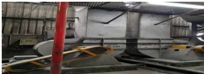
Gambar 4.3 force draft fan (FD FAN)
