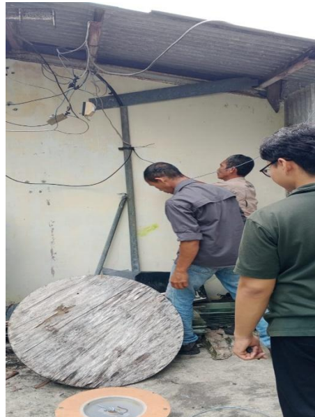
Gambar 3. 2 Penambahan Kabel telepon
