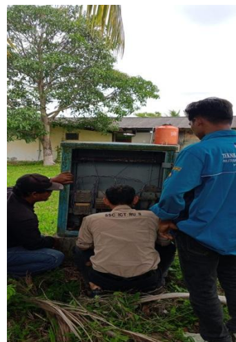
Gambar 3. 5 Pengecekan Rumah Kabel
