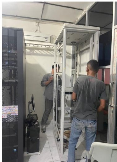
Gambar 3. 8 Pemasangan Rack Server
