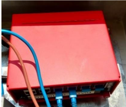
Gambar 4. 25 Mini OTB (Optical Terminal Box)
