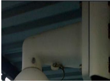
Gambar 4. 41 Bracket pada CCTV
