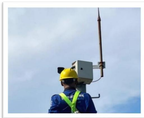
Gambar 4. 47 Kamera CCTV pada tiang yang telah dipasang di area PT. Kilang Pertamina Internasional RU II SPK
