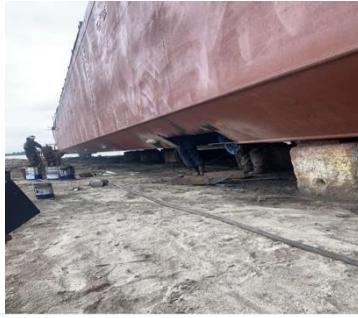
Gambar 2.4 Bottom yang di repair
