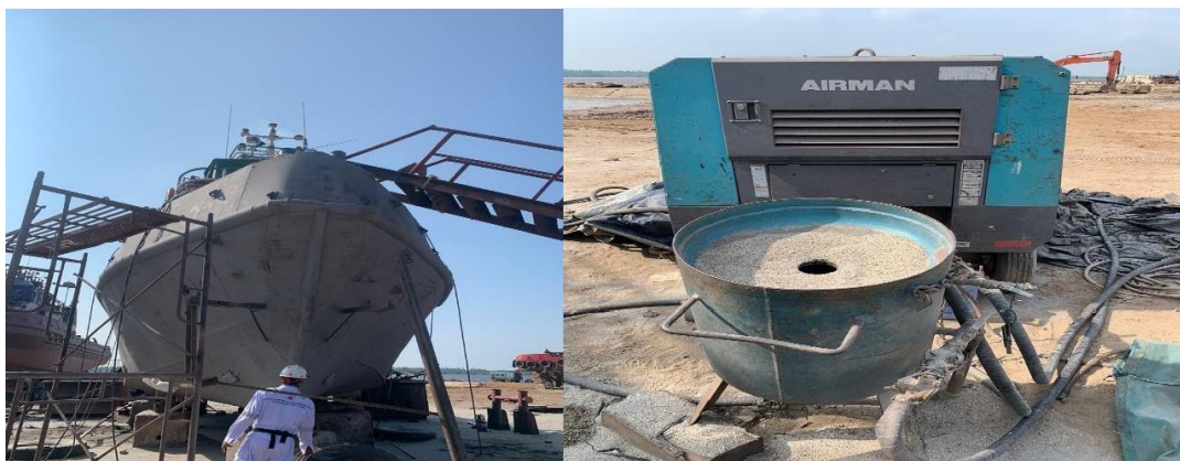
Gambar 2.9 Proses Blasting dan Alat Kompresor Airman dan Pot
