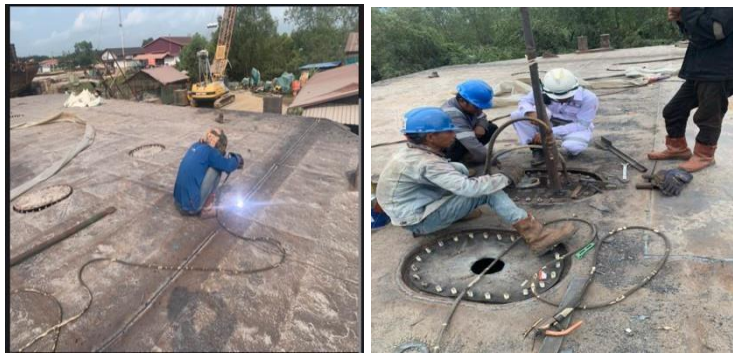
Gambar 2.3 Mengecek hasil las dan pengujian air tes
