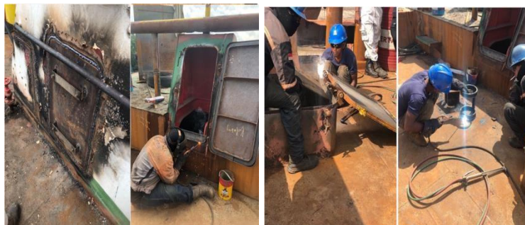
Gambar 2.6 Repair Pintu Kemudi
