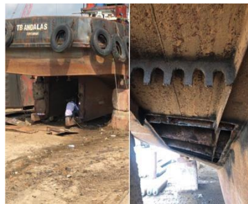
Gambar 2.3 Bottom yang di repair
