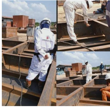
Gambar 2.4 Pengecekan Cacat Las
