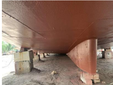
Gambar 2.2 Marking peletakan Zinc Anoda
