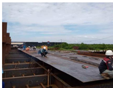
Gambar 2.4 Kontruksi long bulkhead
