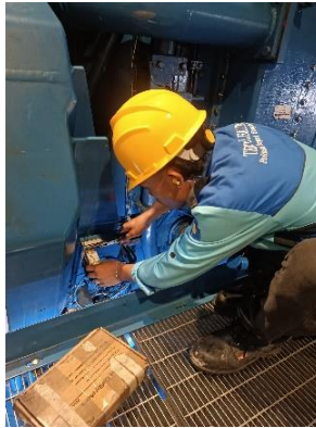
Gambar 3. 13 Penggantian Converter
