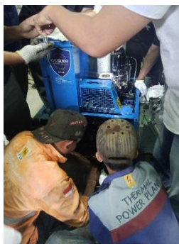
Gambar 3.51 compressor instrumen air (sumber : dokumentasi penulis. 2025)
